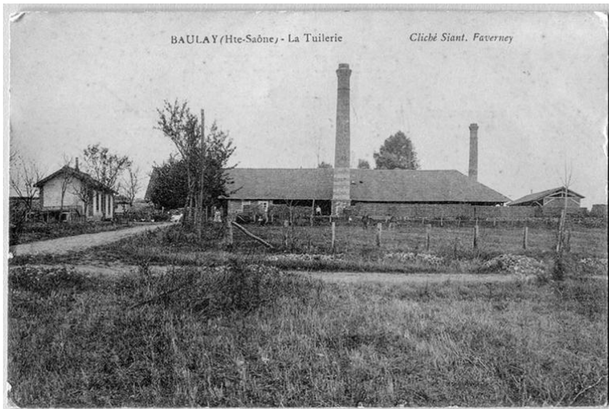
Tuilerie de Baulay. 70, Baulay
