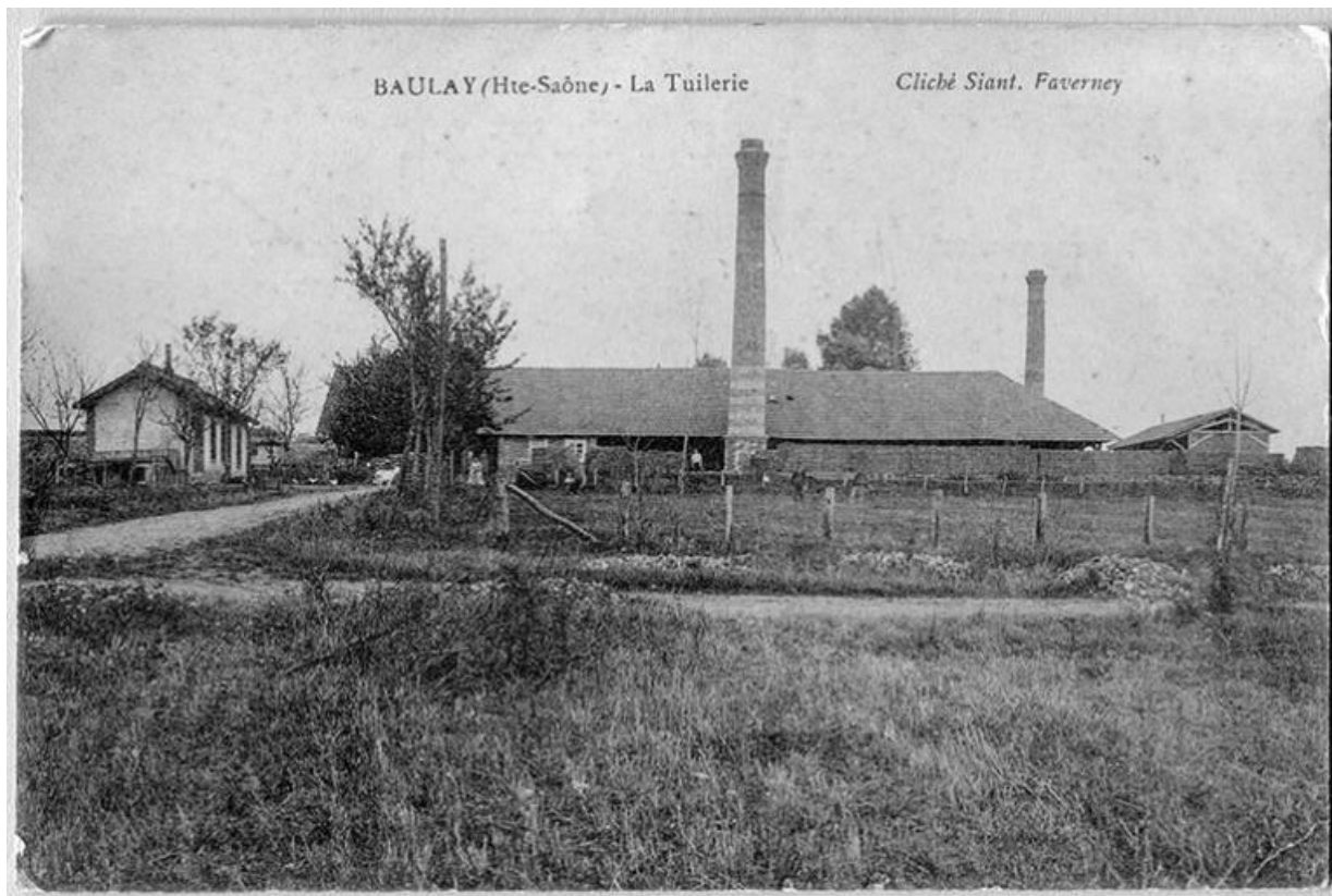
Tuilerie de Baulay. 70, Baulay
