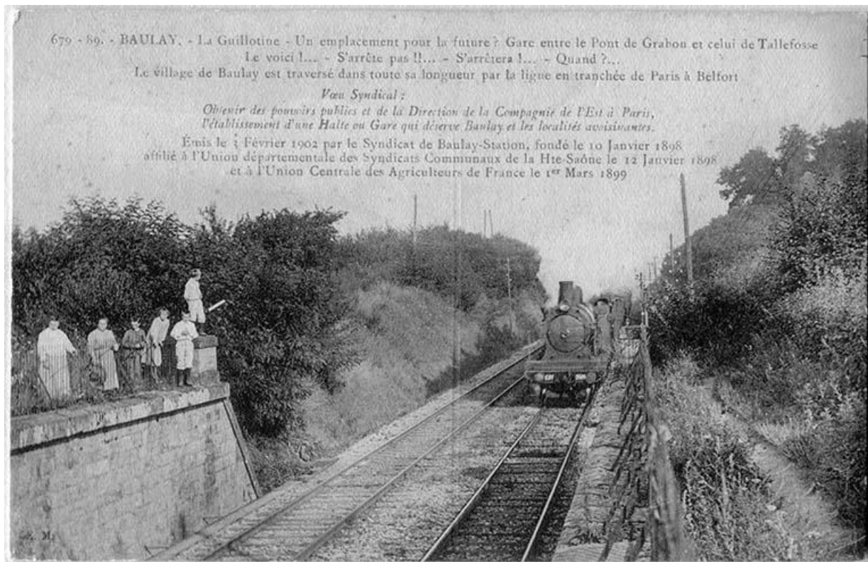
Vue de la voie ferrée, la "tranchée" de Baulay. 70, Baulay
