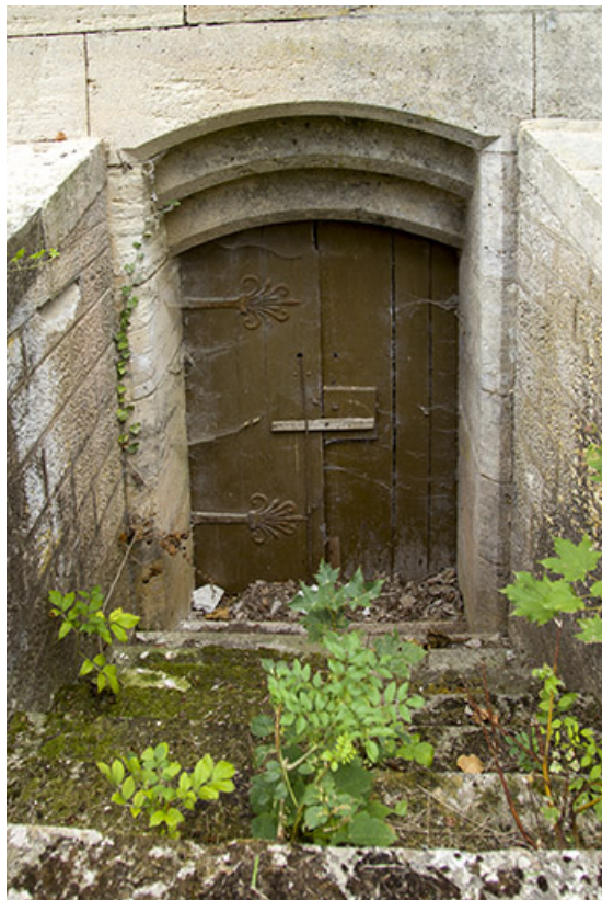
Détail : porte conduisant au sous-sol.
