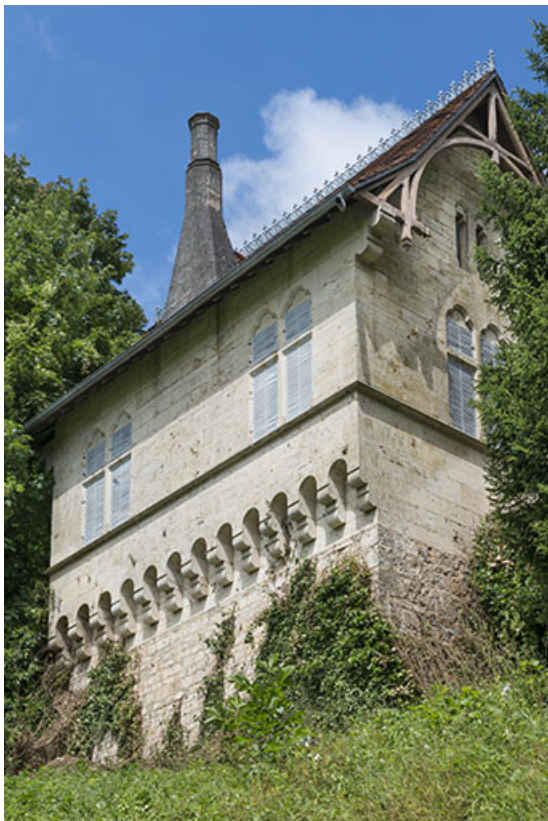
Vue générale de trois quarts montrant la tour, depuis le sud.
