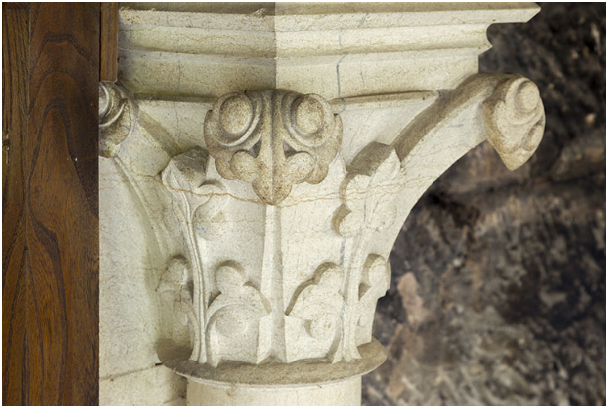
Détail : le chapiteau d'une des colonnes de la cheminée.
