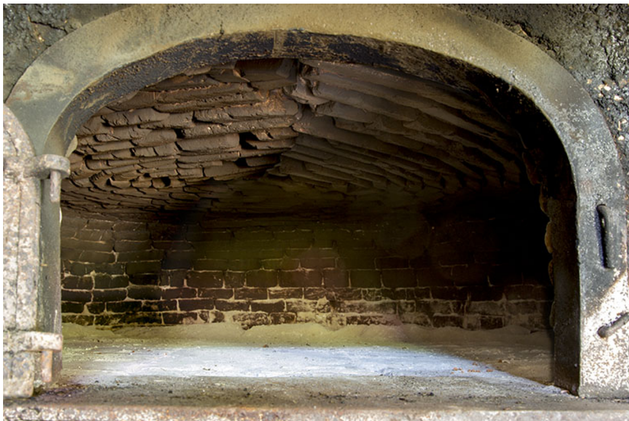
Intérieur du logis : détail du four à pain.
