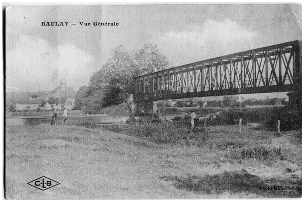
Vue générale du village et du pont métallique sur la Saône. 70, Baulay
