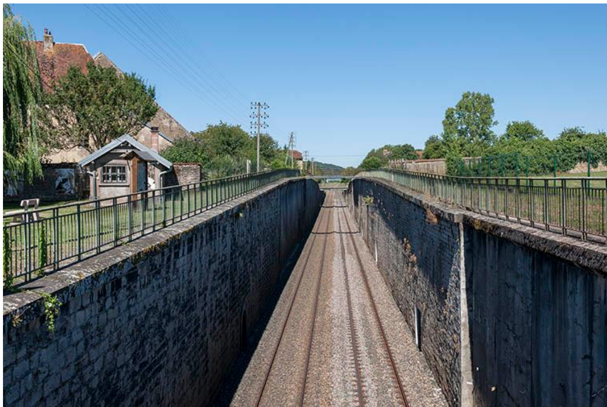
La ligne de chemin de fer Paris-Bâle qui traverse le village, la distillerie sur la gauche. 70, Baulay
