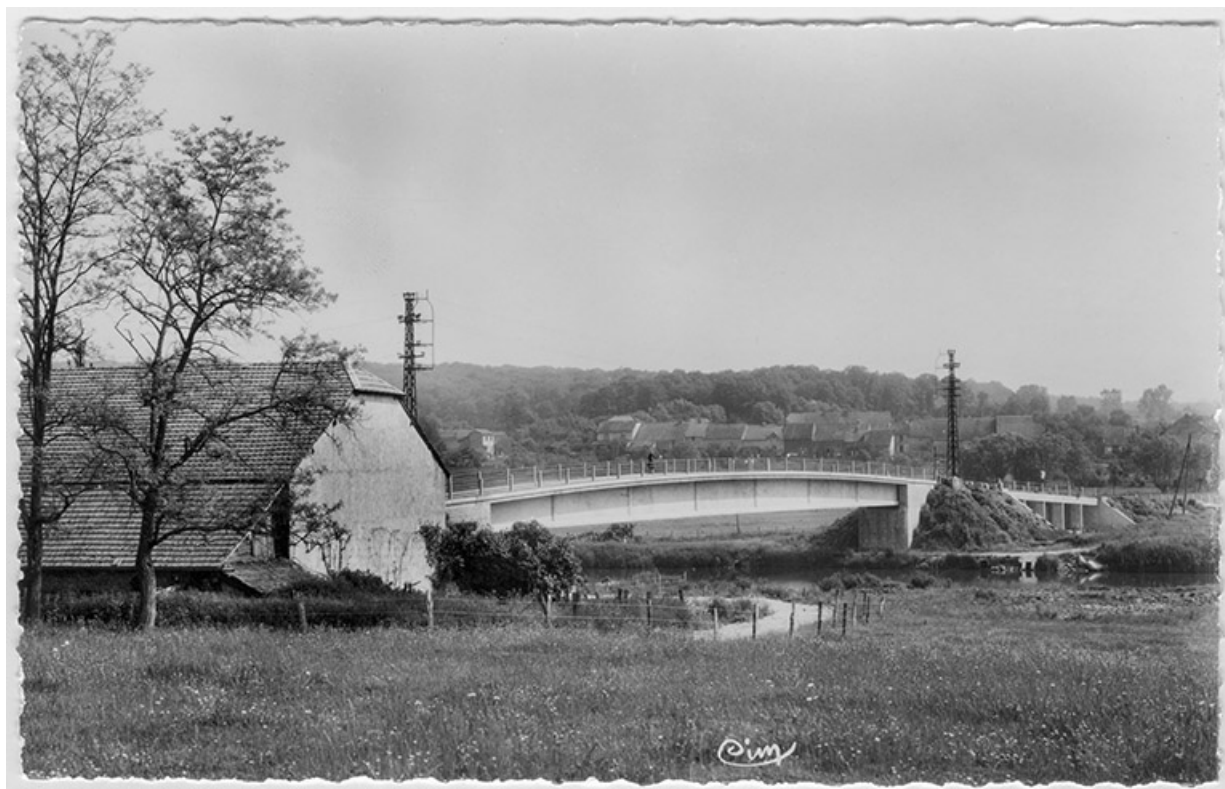
Pont en béton remplaçant le pont métallique 70, Baulay
