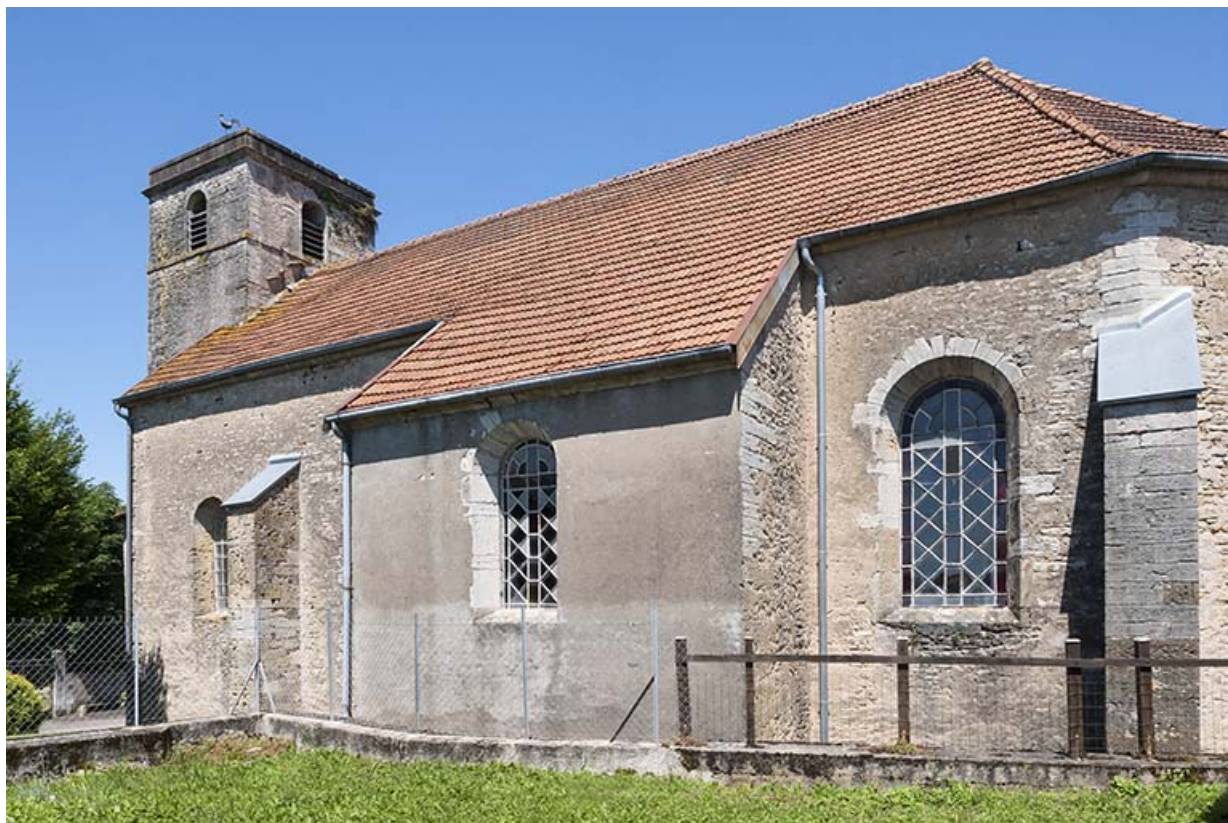
Vue latérale Sud 70, Chaux-lès-Port
