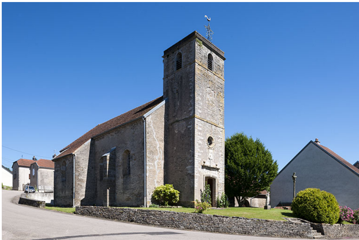
Eglise, vue Nord-Ouest 70, Chaux-lès-Port
