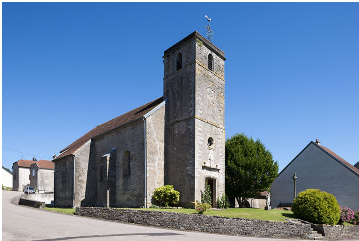
Eglise, vue Nord-Ouest 70, Chaux-lès-Port
