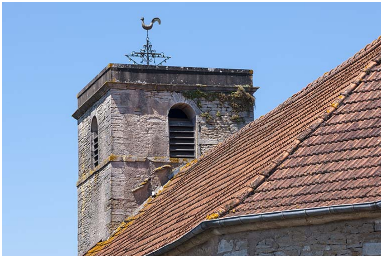
Vue du clocher 70, Chaux-lès-Port
