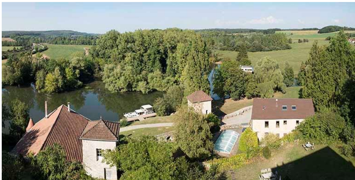
Les bâtiments des communs dans la basse cour, depuis le toit-terrasse du donjon du château, la Saône et le Durgeon. 70, Chemilly, lieudit : La Côte
