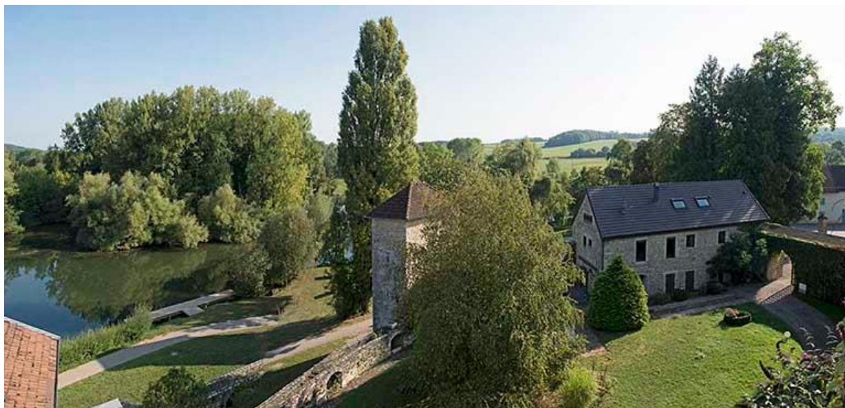
Vue des communs dans la basse-cour et de la véloroute le long de la Saône 70, Chemilly, lieudit : La Côte
