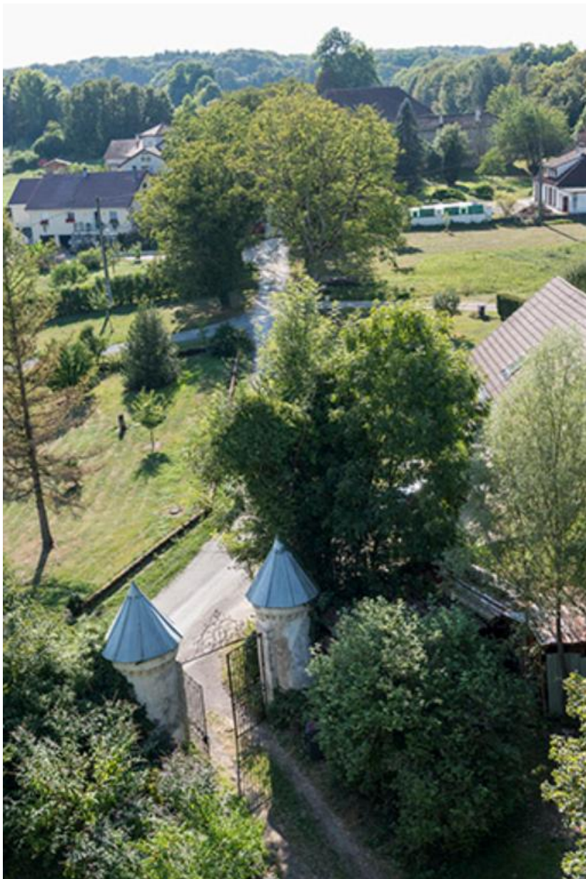
Portail d'entrée au château, situé rue du château, à l'Ouest, en direction de l'ancien couvent. 70, Chemilly, lieudit : La Côte
