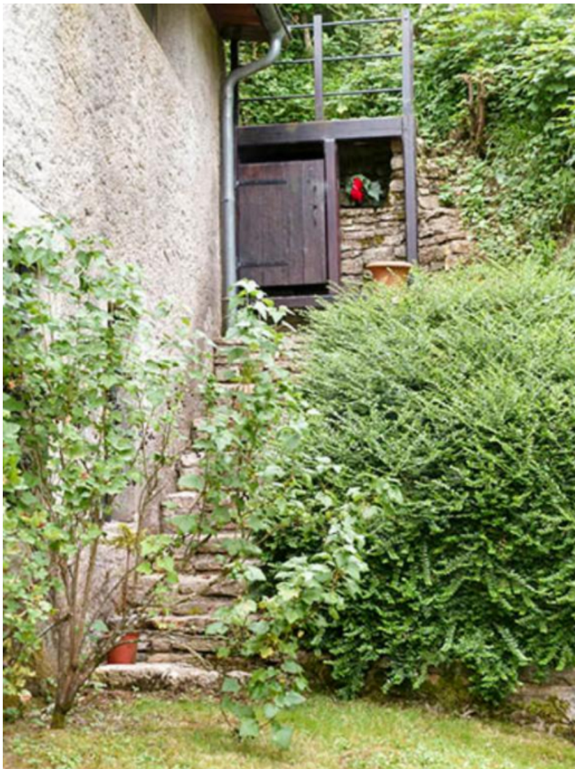
Accès et entrée de la glacière, côté Ouest de l'ancienne écurie.
