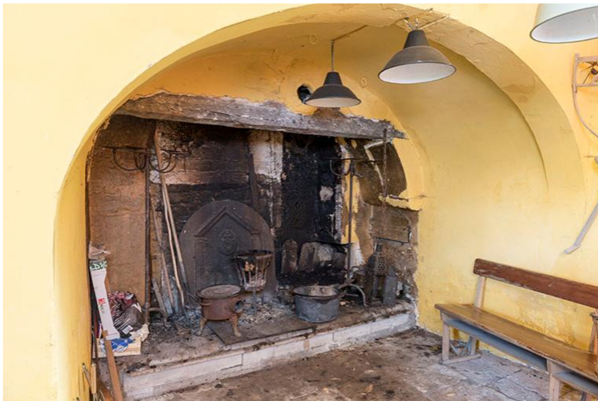
Cheminée et four à pain, rez-de-chaussée du donjon.
