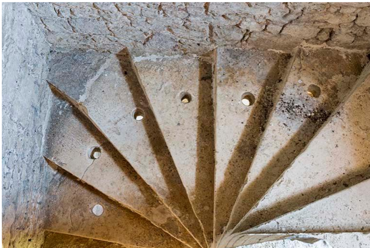
Vue de l'escalier intérieur de la tour sur le mur d'enceinte entre les deux cours, détail de l'emmarchement menant au pigeonnier 70, Chemilly, lieudit : La Côte
