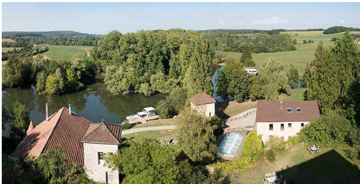
Les bâtiments des communs dans la basse cour, depuis le toit-terrasse du donjon du château, la Saône et le Durgeon. 70, Chemilly, lieudit : La Côte
