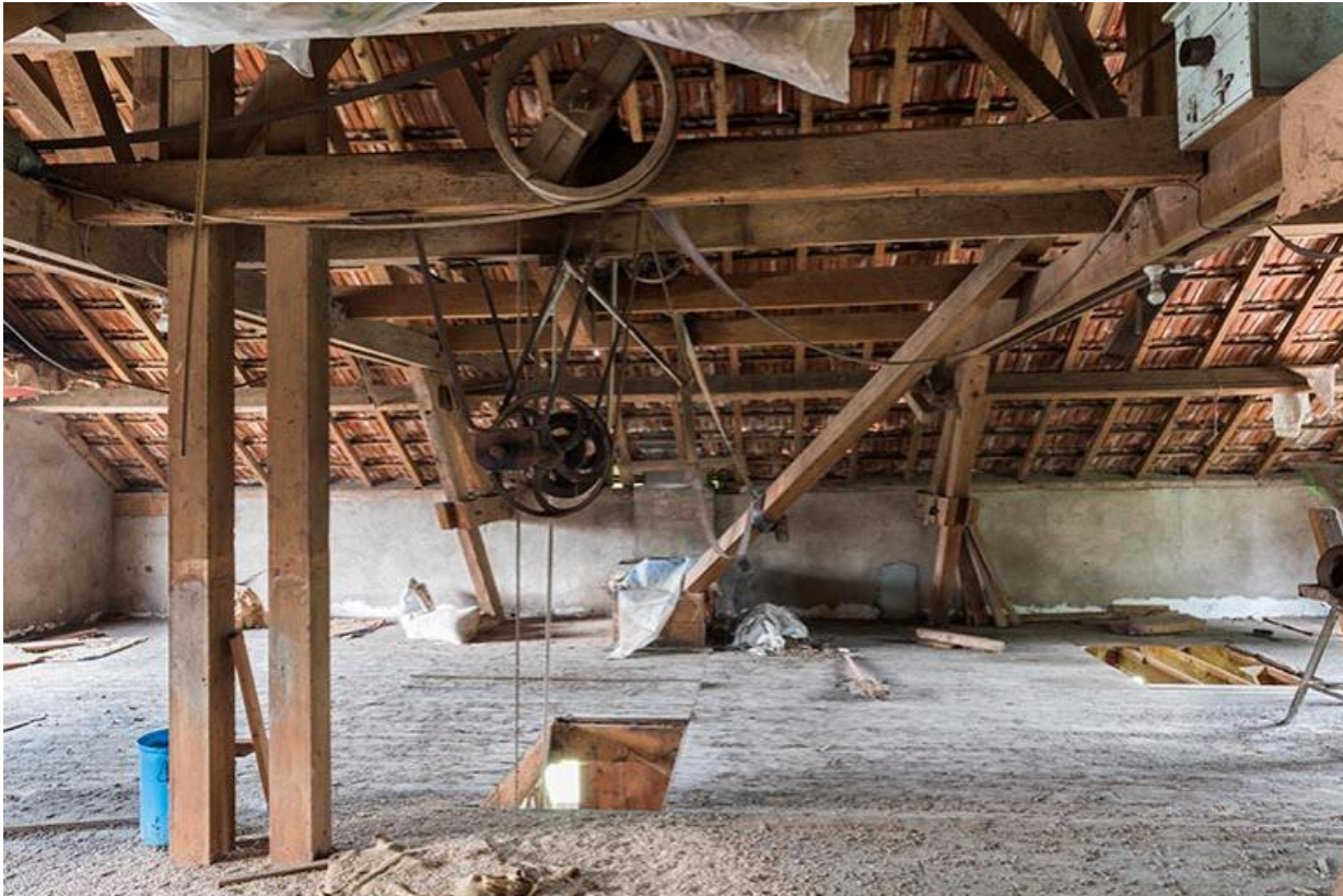
Vue de l'étage en surcroît, système de transmission par poulies et courroies et conduits fermés en bois 70, Chemilly Grande rue
