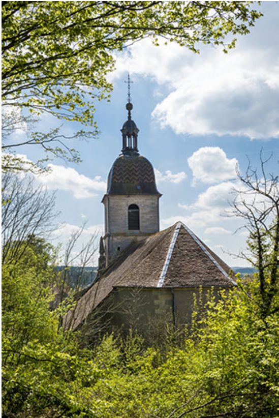
Vue depuis l'ancien cimetière. 70, Port-sur-Saône Grande Rue
