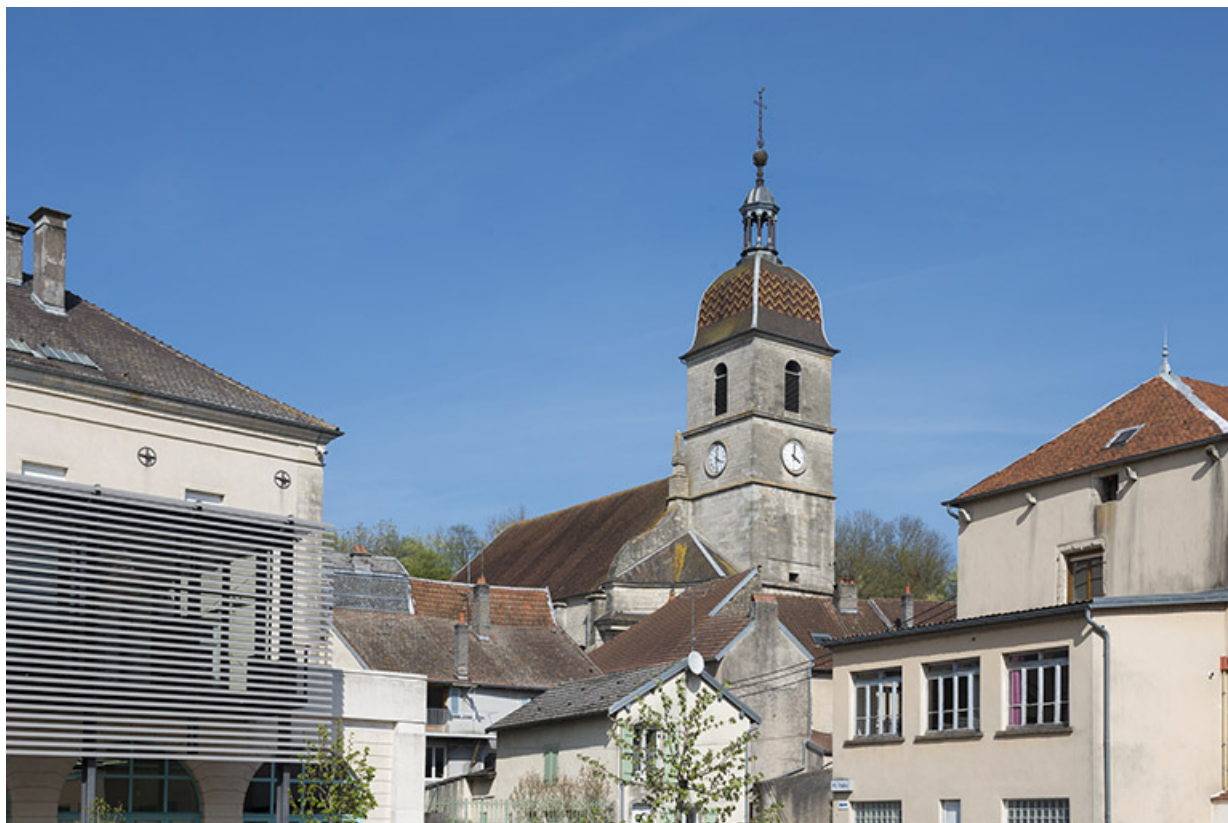
L'église depuis la place située derrière la mairie.
