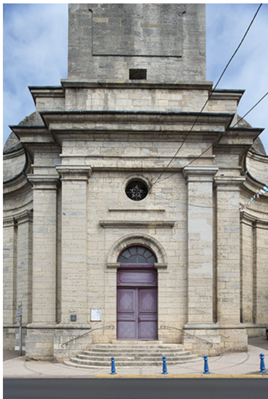
La façade principale et le portail d'entrée.
