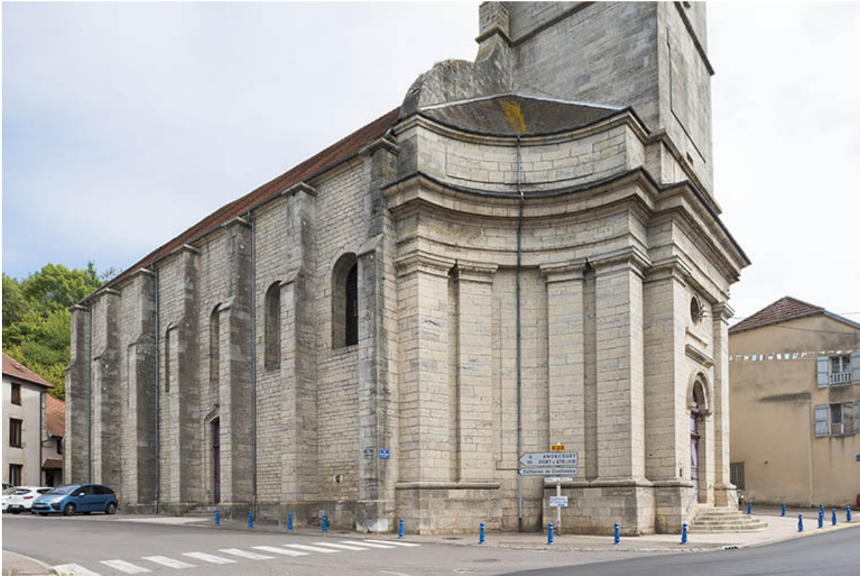
Le mur latéral ouest de l'édifice.
