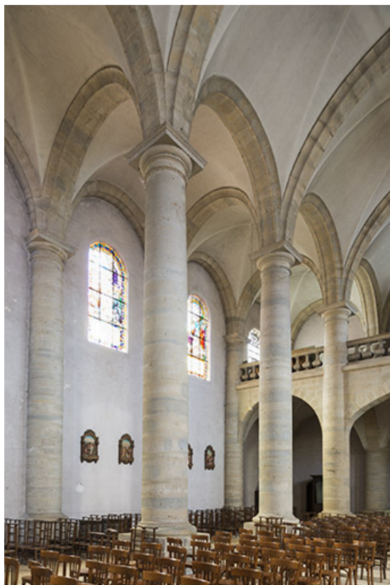
Vue sur les colonnes séparant la nef du collatéral Ouest. 70, Port-sur-Saône Grande Rue
