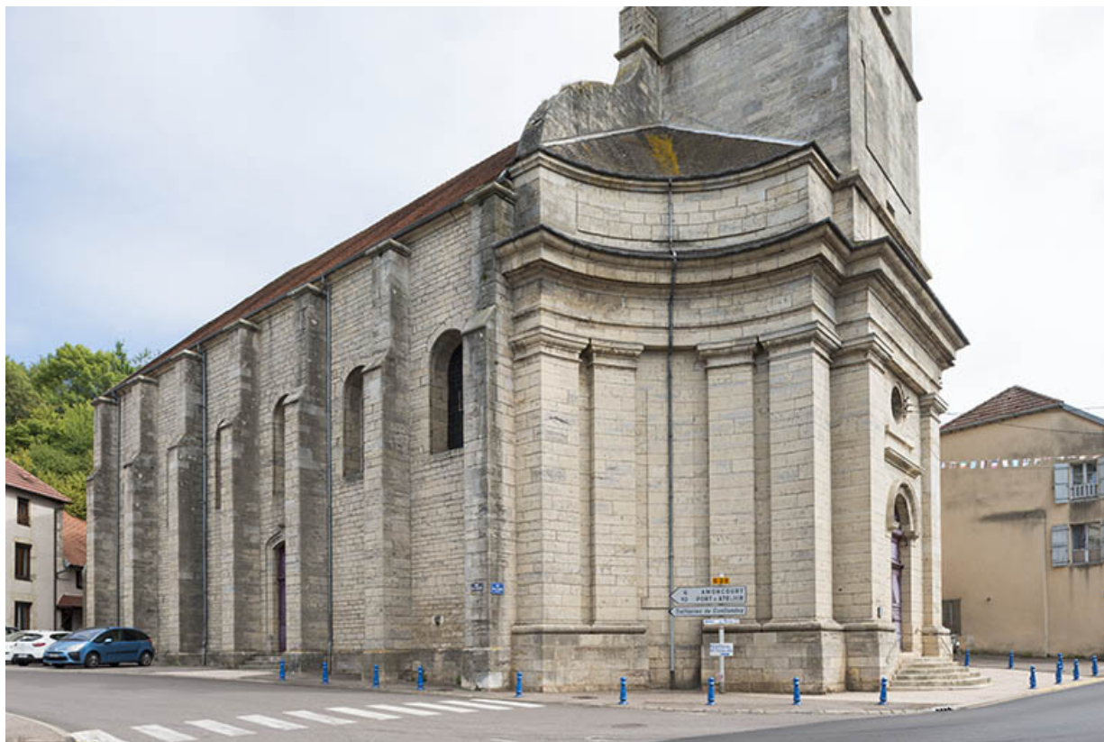
Le mur latéral ouest de l'édifice.
