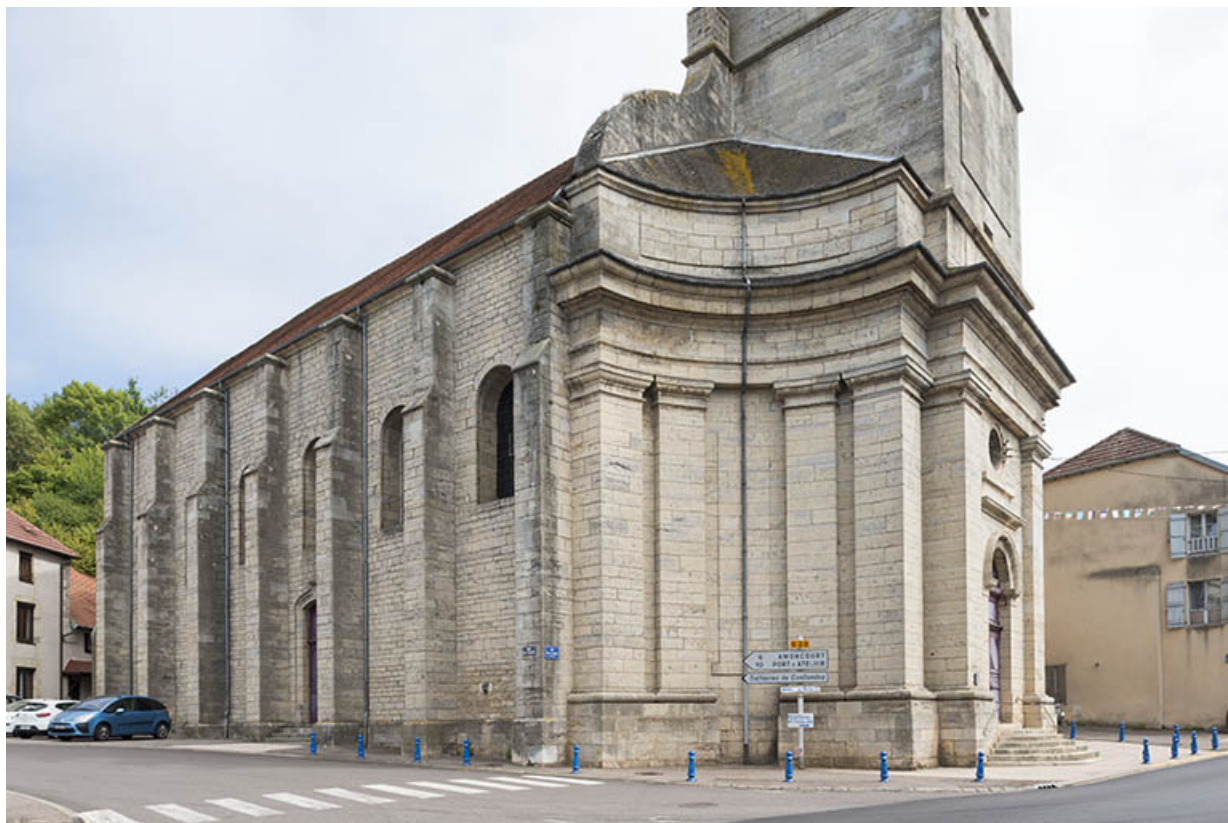
Le mur latéral ouest de l'édifice.
