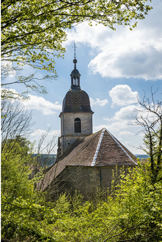
Vue depuis l'ancien cimetière. 70, Port-sur-Saône Grande Rue
