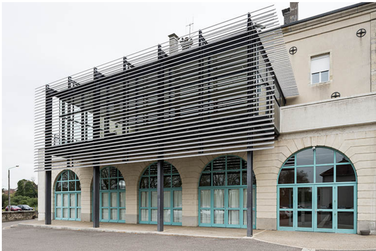
Façade postérieure de l'hôtel de ville. 70, Port-sur-Saône
