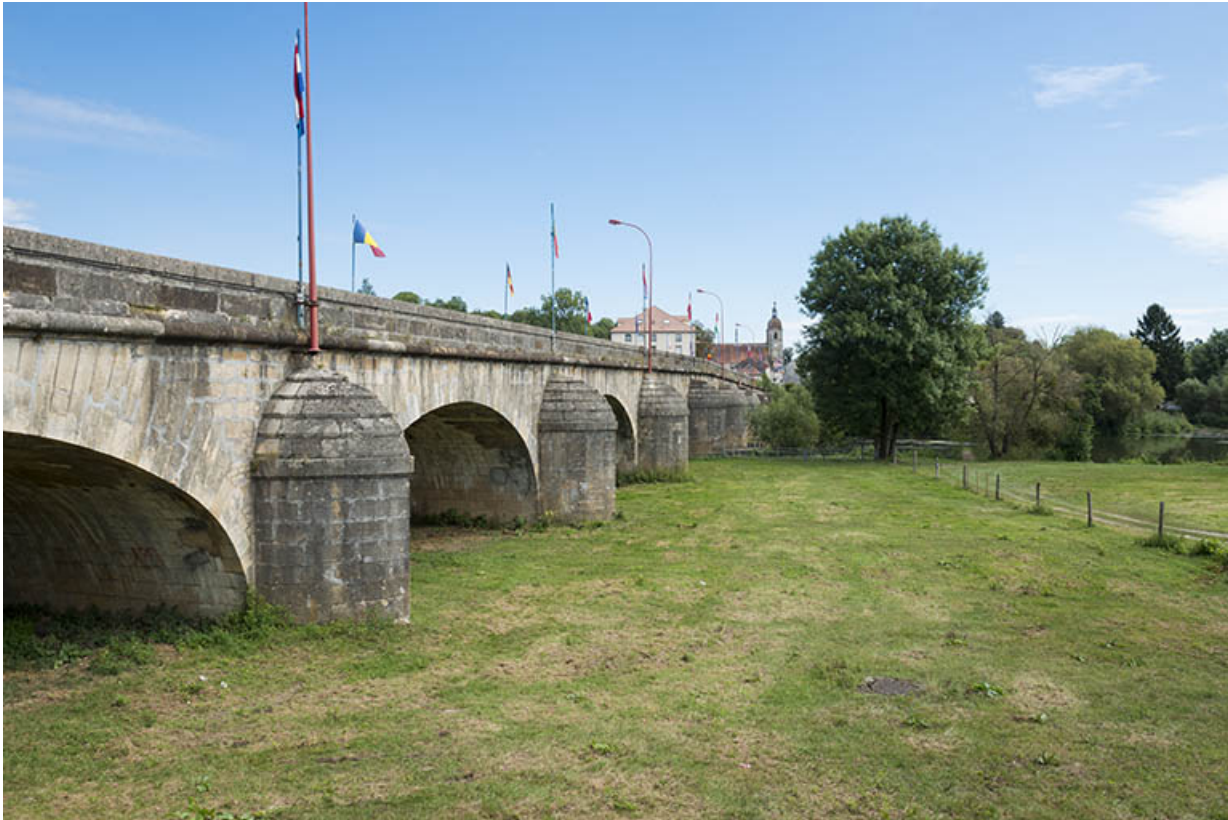
Le pont en pierre. 70, Port-sur-Saône
