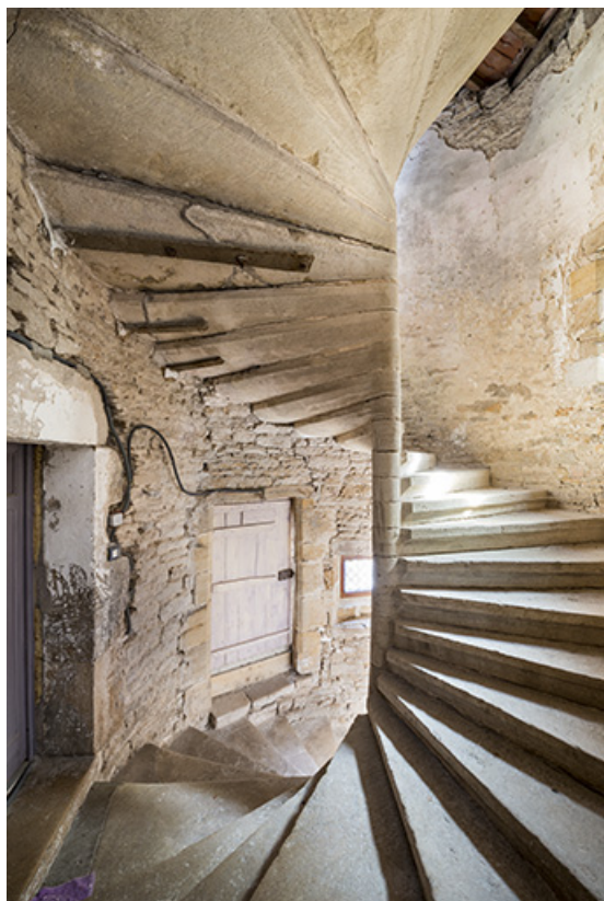
Esacalier situé dans l'ancien prieuré.
