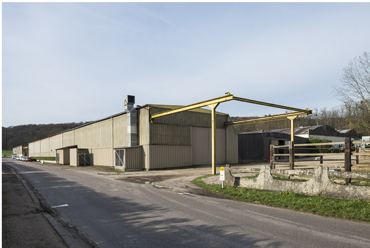
Hangar de la société Selam, route de Ferrières. 70, Port-sur-Saône
