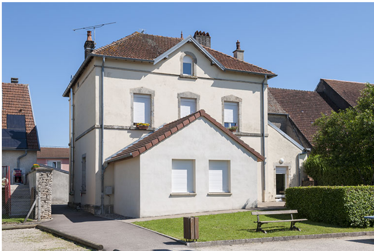
Façade postérieure avec l'agrandissement contemporain.
