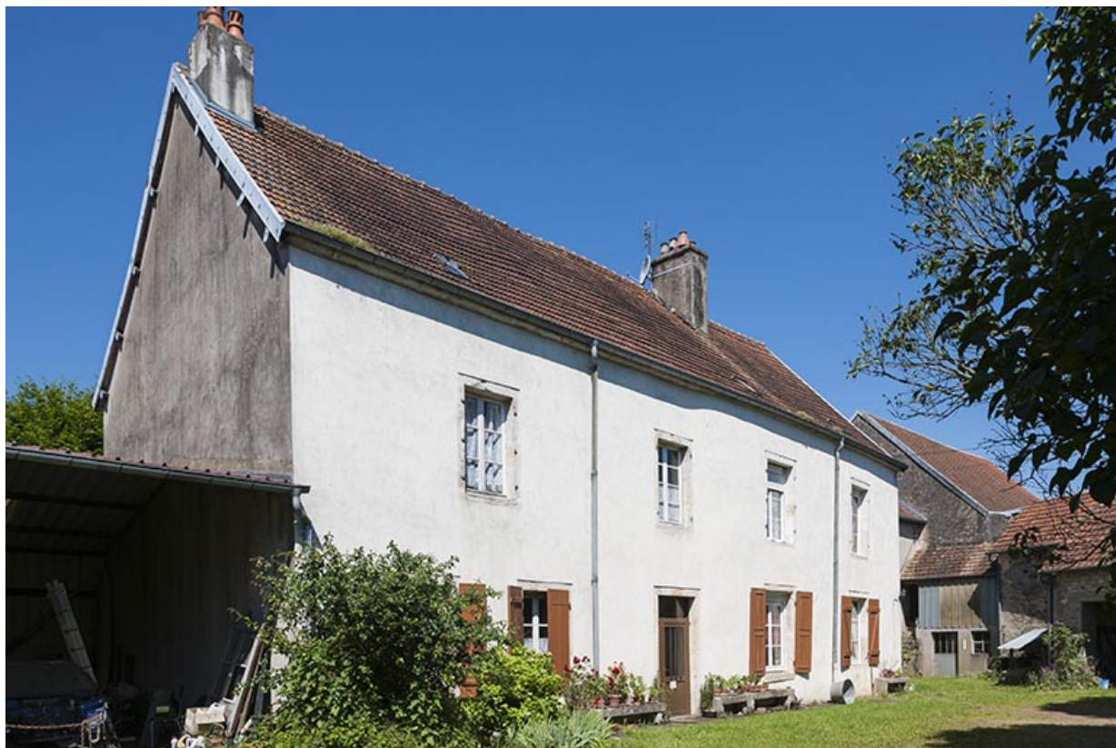
Château du village. 70, Chaux-lès-Port
