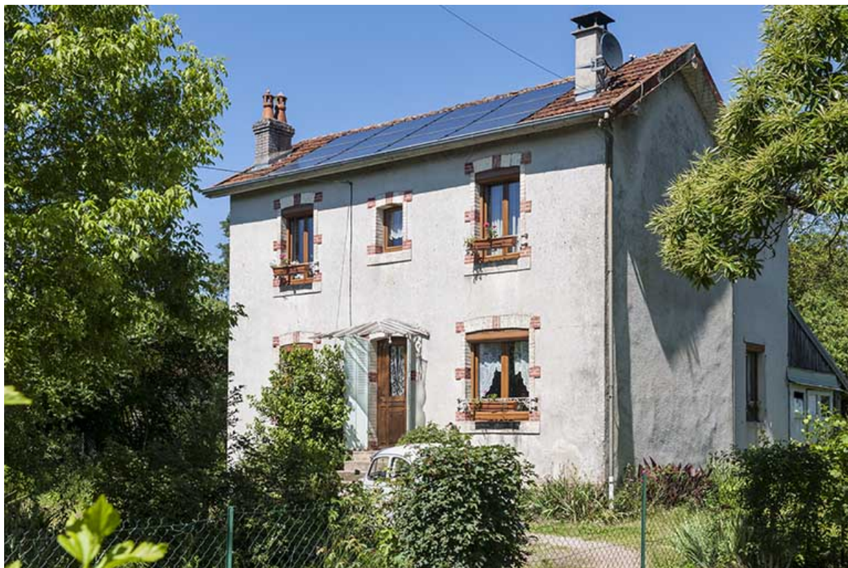
Maison située vers l'entrée du village.
