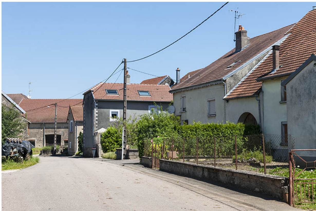
Rue principale regroupant plusieurs typologies de fermes, Chaux-les-Ports.
