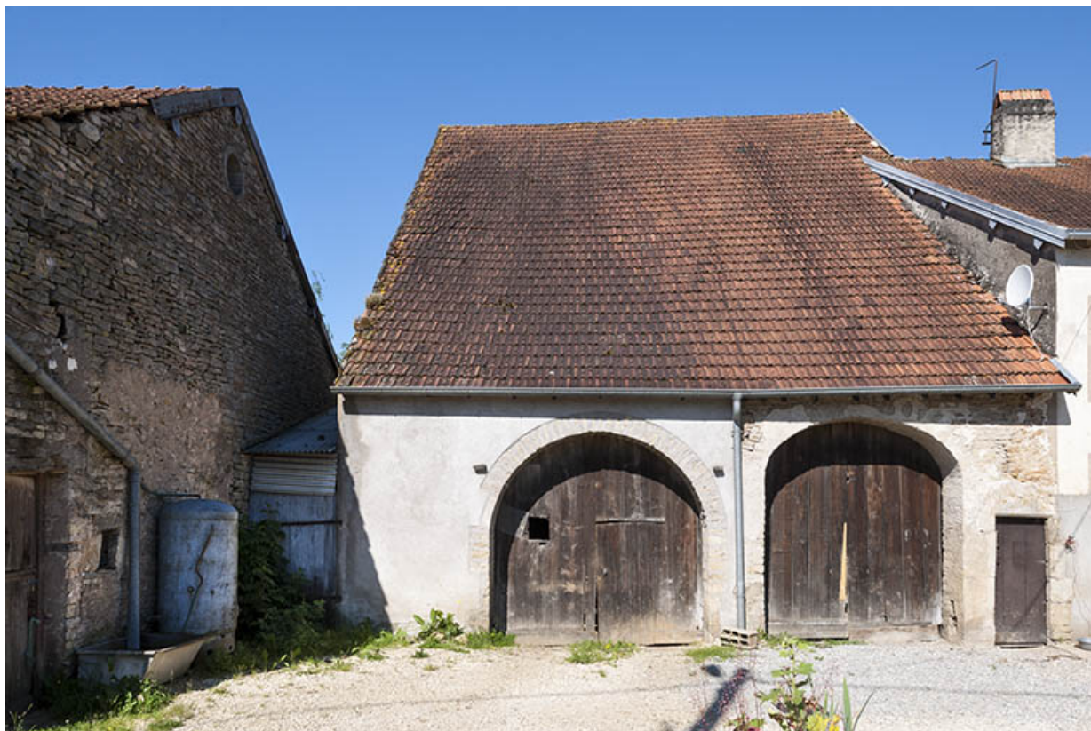
Grange à deux portes charretière. 70, Chaux-lès-Port
