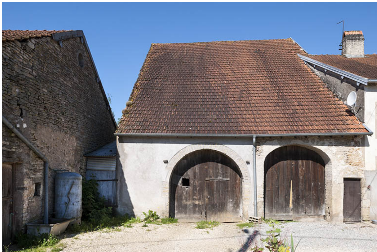
Grange à deux portes charretière.
