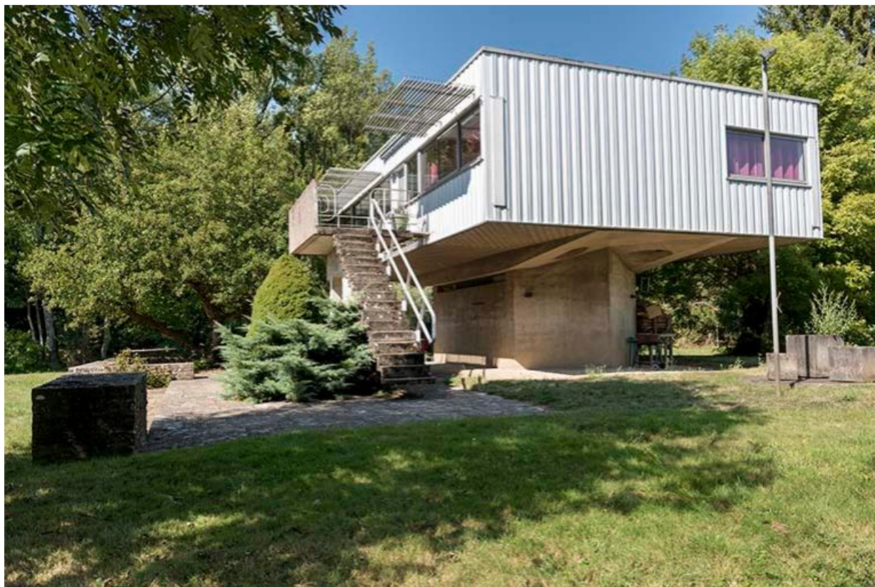
Villa, angle sud-ouest 70, Chemilly
