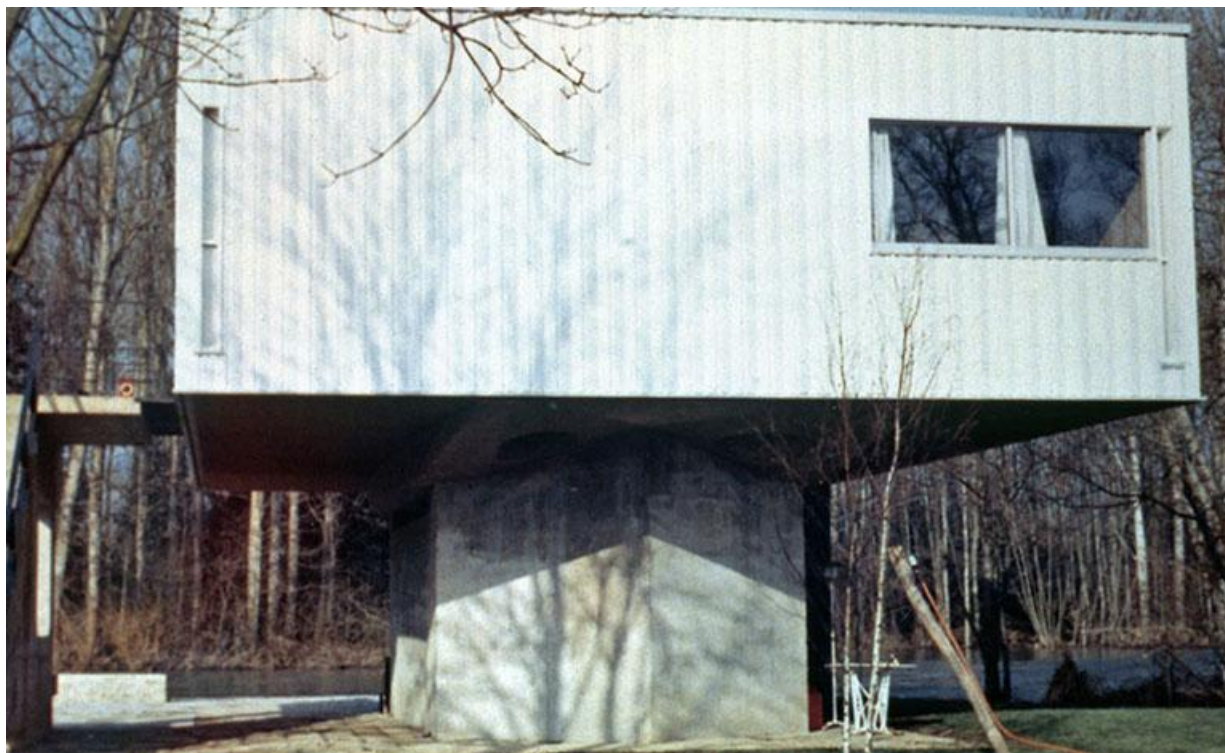
Vue de la façade latérale sud-ouest, photographie ancienne, ca. 1965-1970, Archives privées. 70, Chemilly
