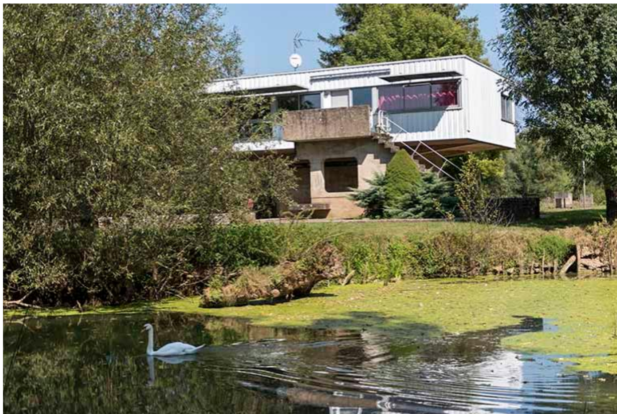
La villa, façade ouest, vue depuis la rive d'en face 70, Chemilly
