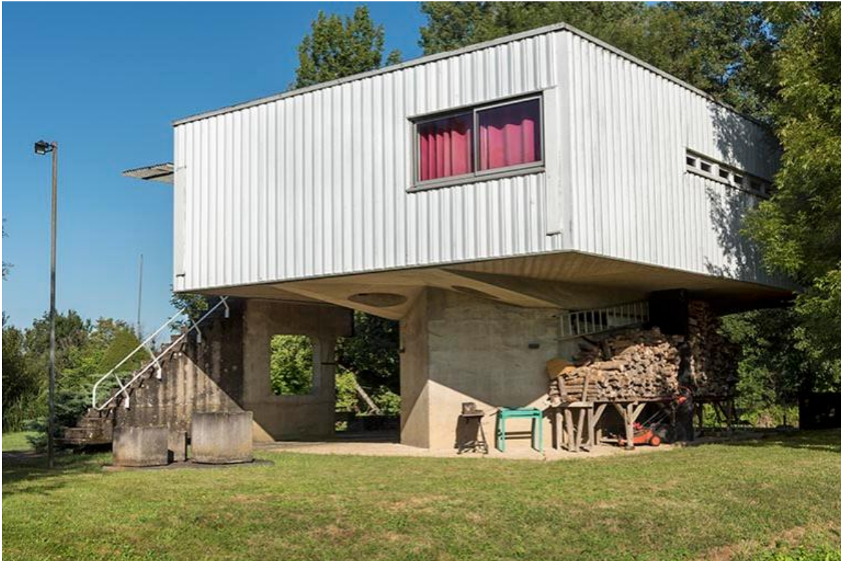
Villa, angle sud-est, escalier et pile en béton 70, Chemilly
