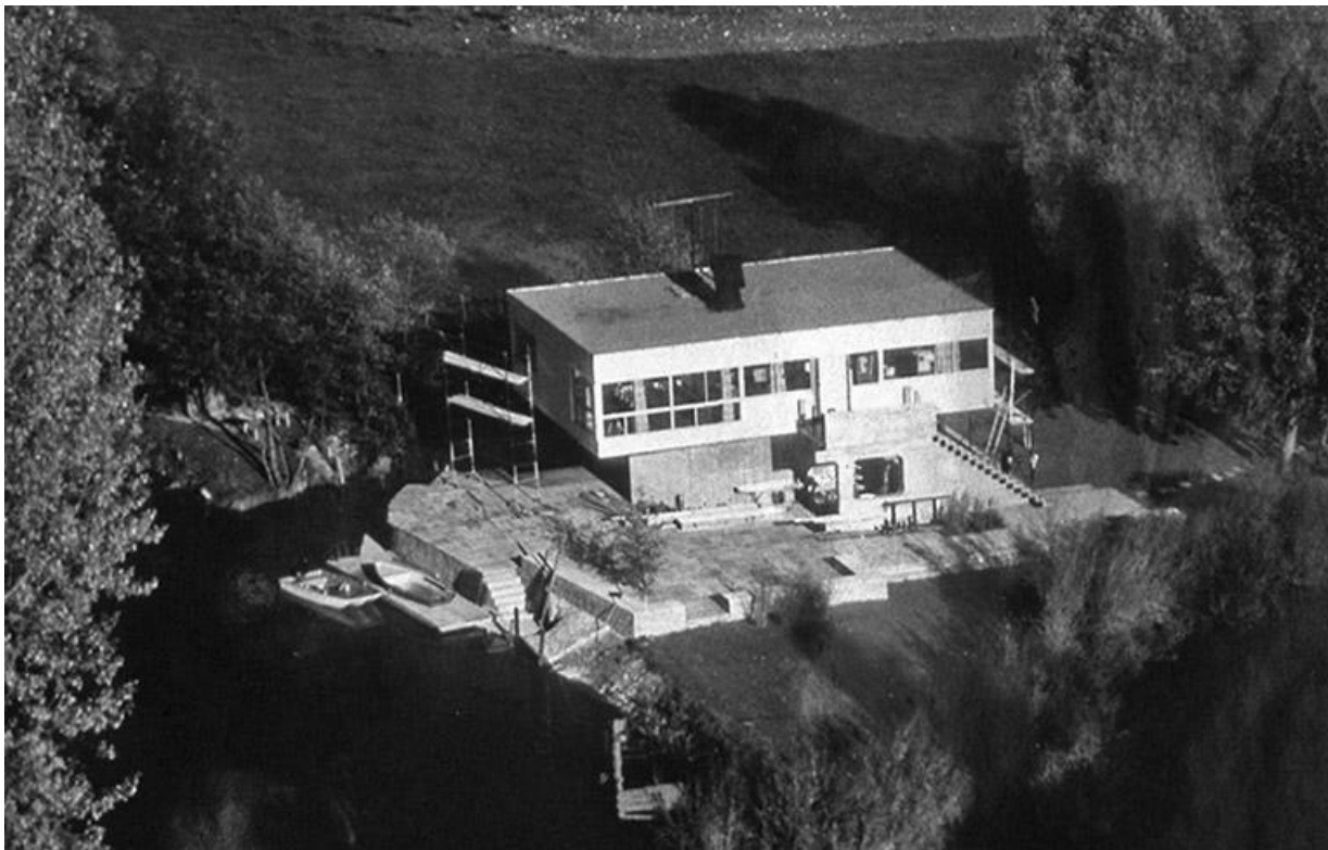
Vue aérienne de la maison lors du chantier, photographie ancienne, ca. 1965, Archives privées. 70, Chemilly
