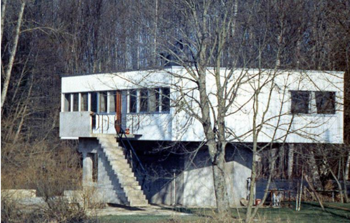
Vue des façades antérieure et latérale depuis le sud-est, photographie ancienne, ca. 1965-1970, Archives privées. 70, Chemilly
