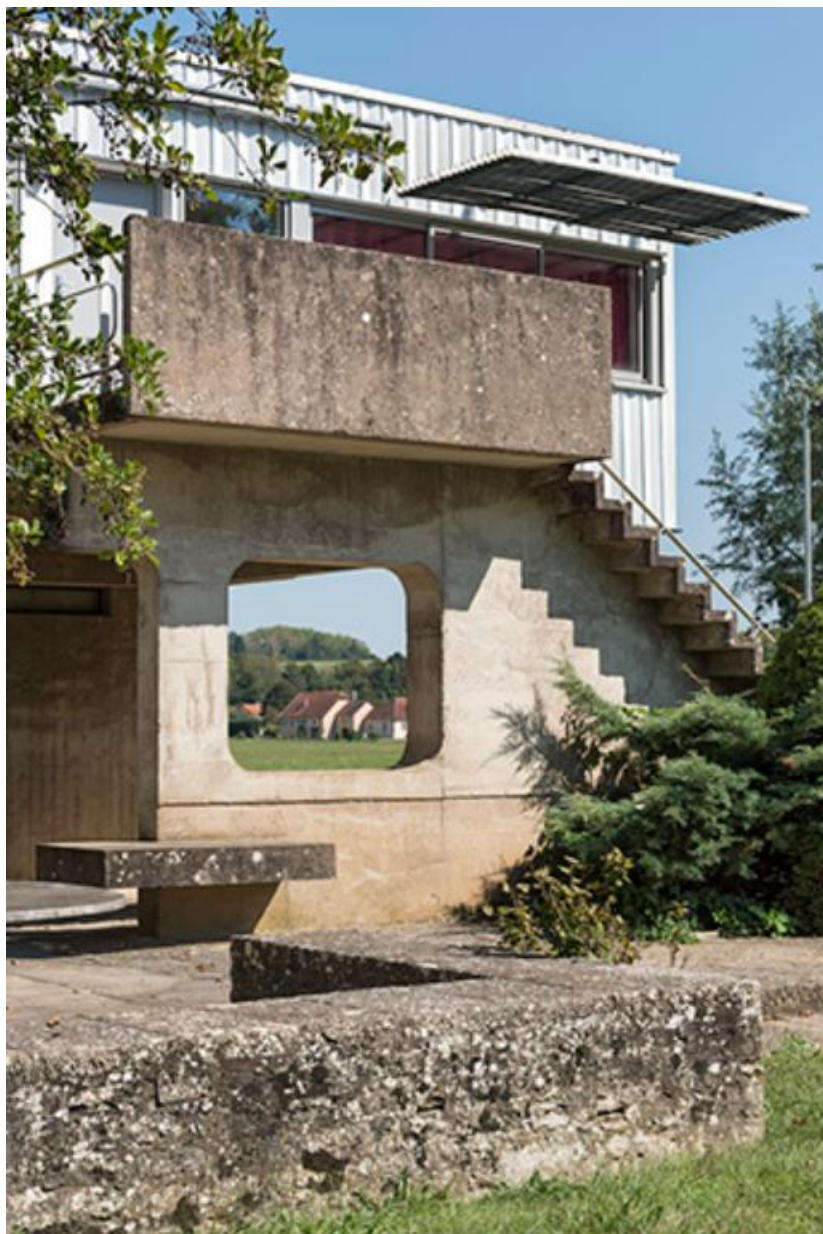
Façade ouest, et vue sur l'ancien moulin à travers l'ouverture dans le mur de l'escalier 70, Chemilly
