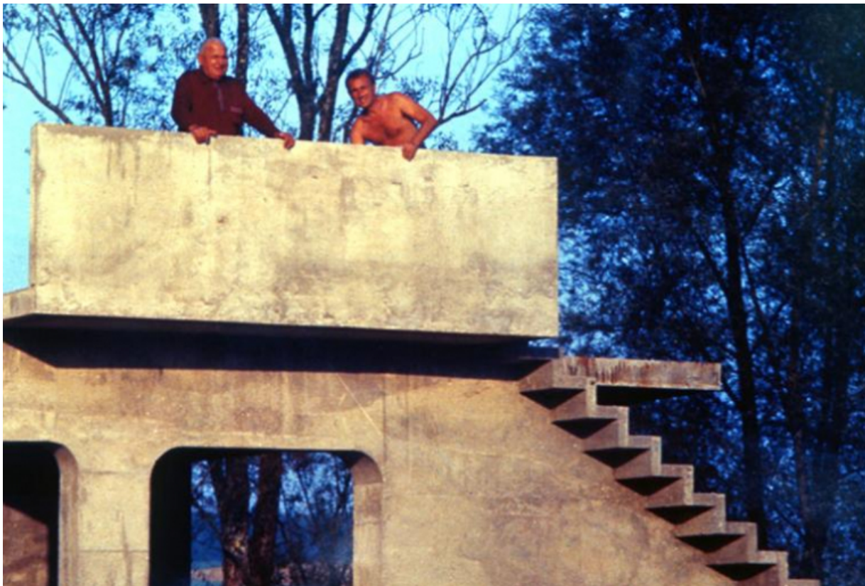
Vue de l'escalier lors du chantier, photographie ancienne, ca.1965, Archives privées. 70, Chemilly
