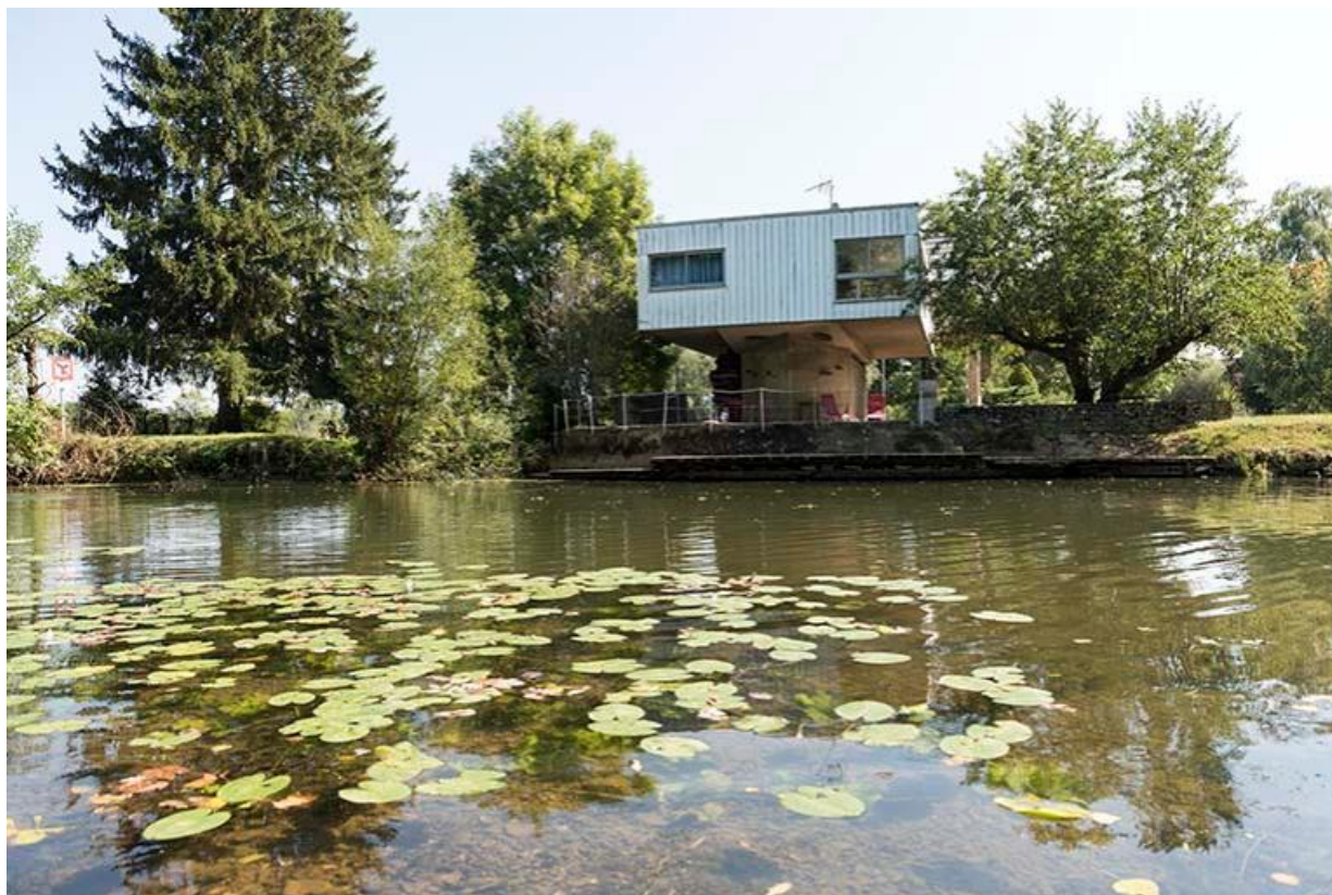
Vue de la façade nord, depuis la rivière 70, Chemilly
