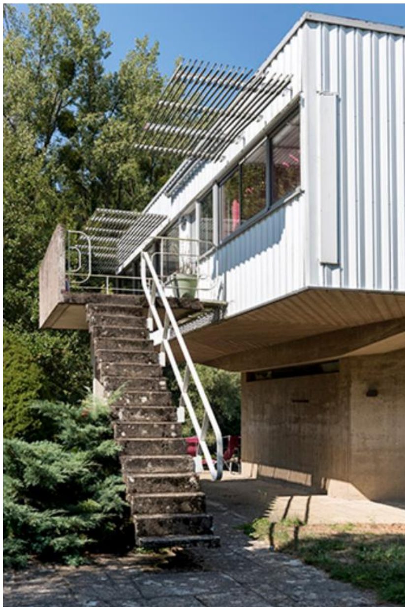
Villa, détails de l'escalier détaché du sol, du balcon et des pare-soleil métalliques 70, Chemilly
