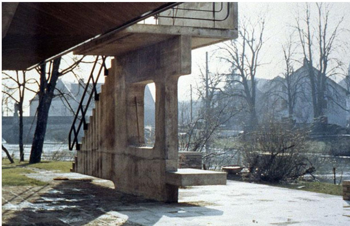
Vue du voile en béton de l'escalier et du palier, photographie ancienne, ca. 1965-1970, Archives privées. 70, Chemilly
