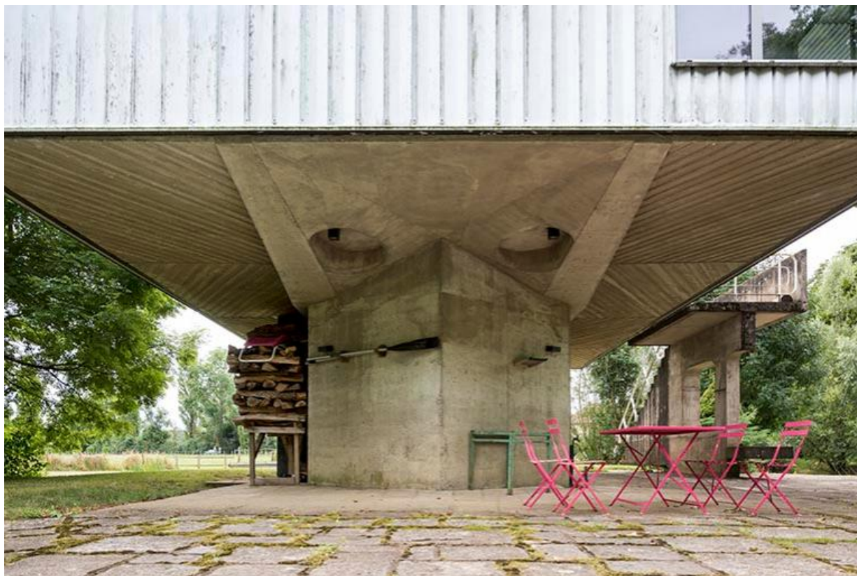
Vue de la pile et du soubassement avec alvéoles aménagées, façade nord 70, Chemilly
