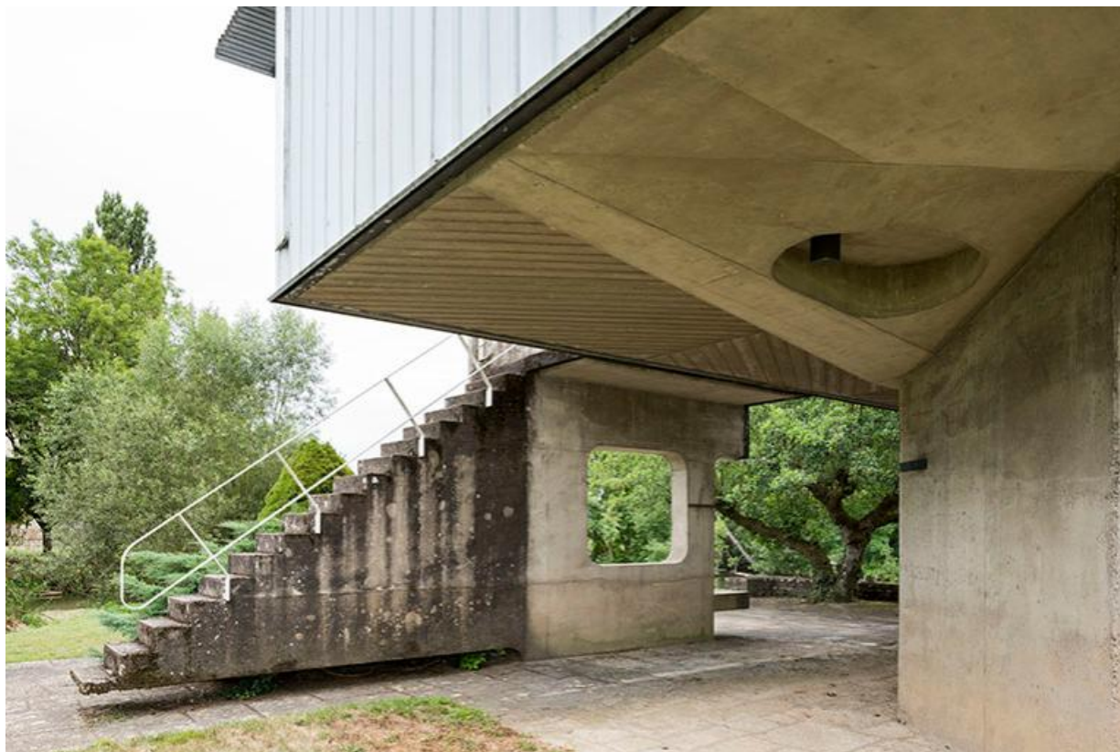
Côté sud, vue de l'escalier détaché du sol, de son mur porteur avec son ouverture et détail d'une alvéole aménagée sous la plateforme de la maison
