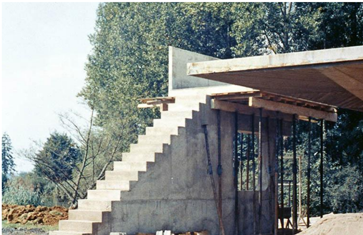
Vue de l'escalier lors du chantier, photographie ancienne, ca.1965, Archives privées. 70, Chemilly
