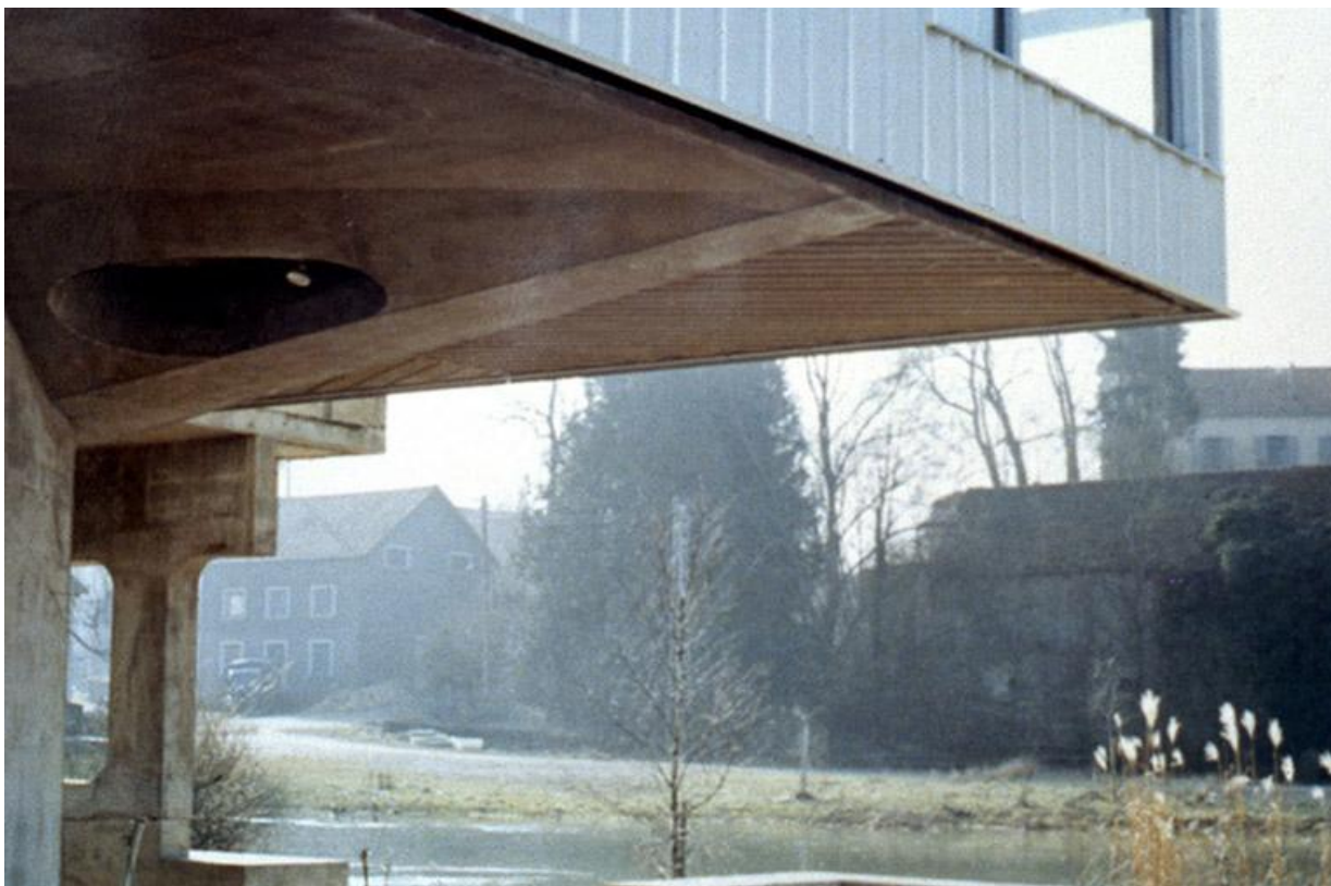
Vue de la dalle de plancher en direction du sud, photographie ancienne, ca. 1965-1970, Archives privées. 70, Chemilly
