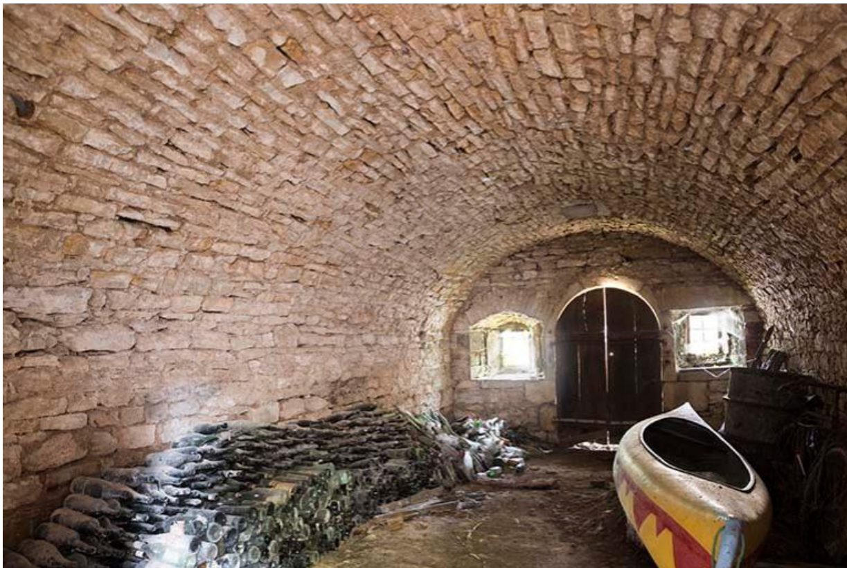
Vue intérieure de la cave ouvrant sur la rue 70, Chemilly, 6 rue de la Petite Rampe
