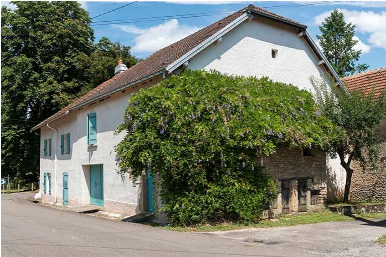
Maison située 1 Grande rue, avec une soue à cochons contre le mur pignon, côté rue de la Barque 70, Chemilly, 6 rue de la Petite Rampe
