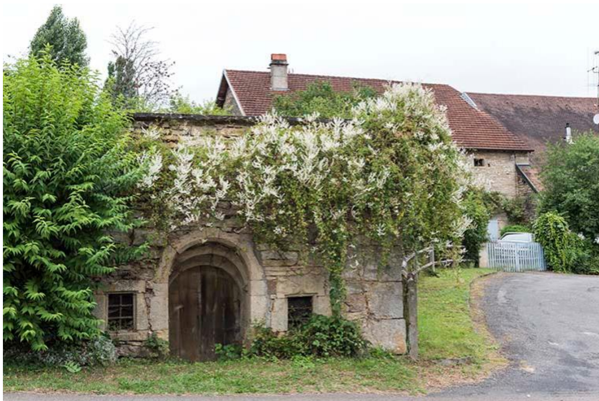
Entrée de cave de la maison dite "espagnole", depuis la Grande rue 70, Chemilly, 6 rue de la Petite Rampe
