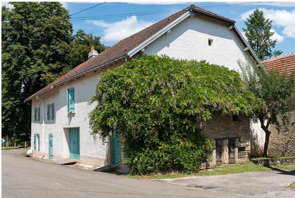
Maison située 1 Grande rue, avec une soue à cochons contre le mur pignon, côté rue de la Barque 70, Chemilly, 6 rue de la Petite Rampe
