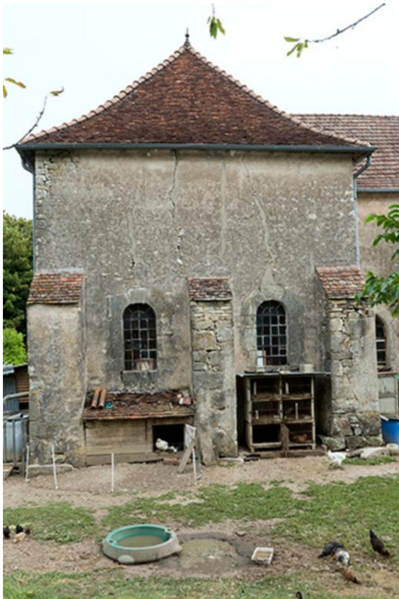
Façade ouest 70, Chemilly
