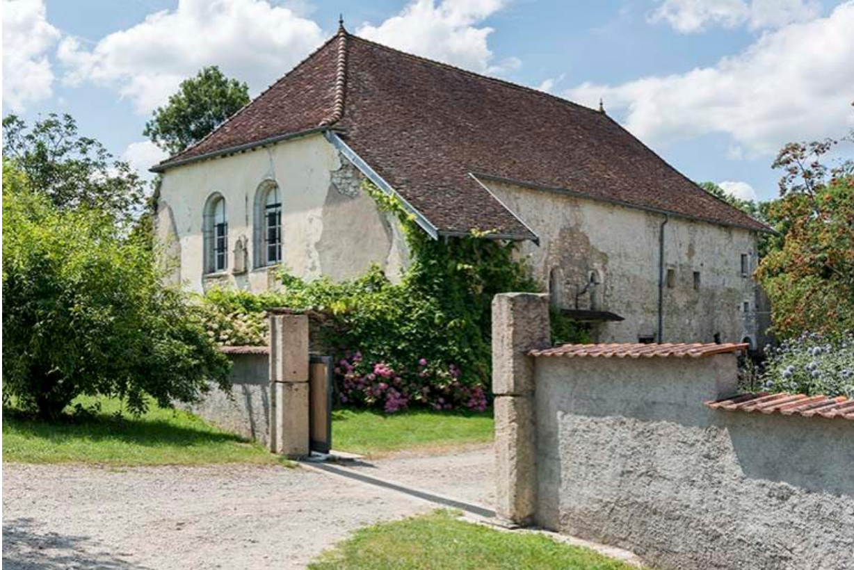
Vue de la chapelle, côté cour 70, Chemilly
