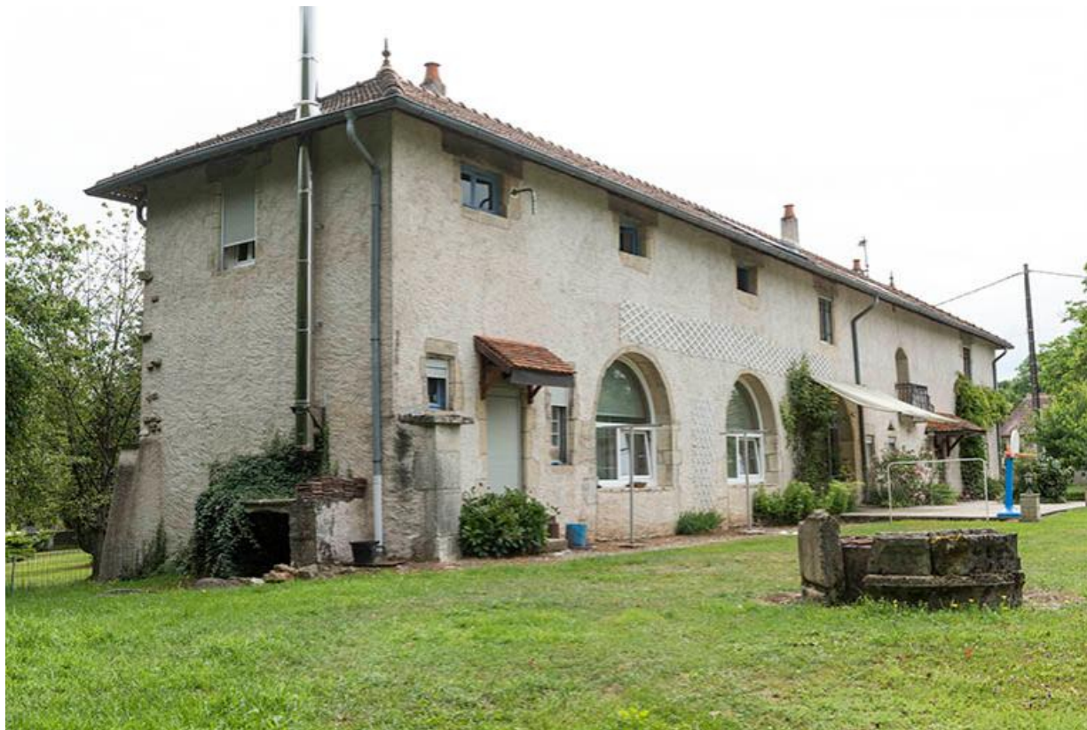
Vue de l'ancienne aile conventuelle reconvertie en habitation 70, Chemilly
