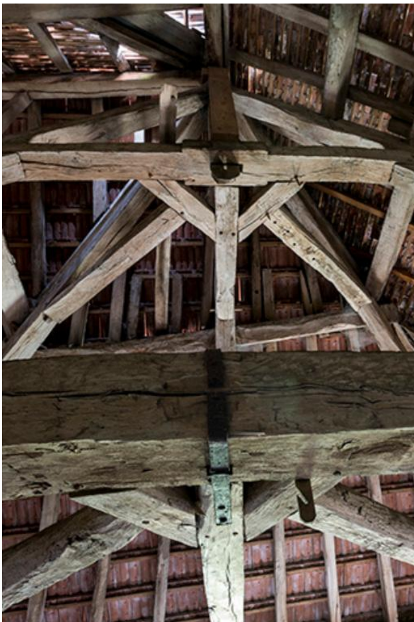
Poutrage du grenier de la chapelle
