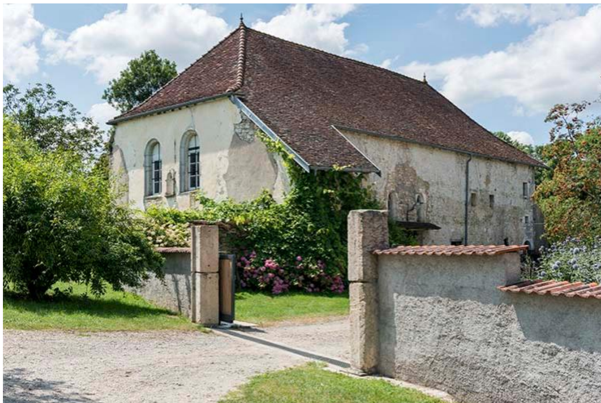
Vue de la chapelle, côté cour 70, Chemilly
