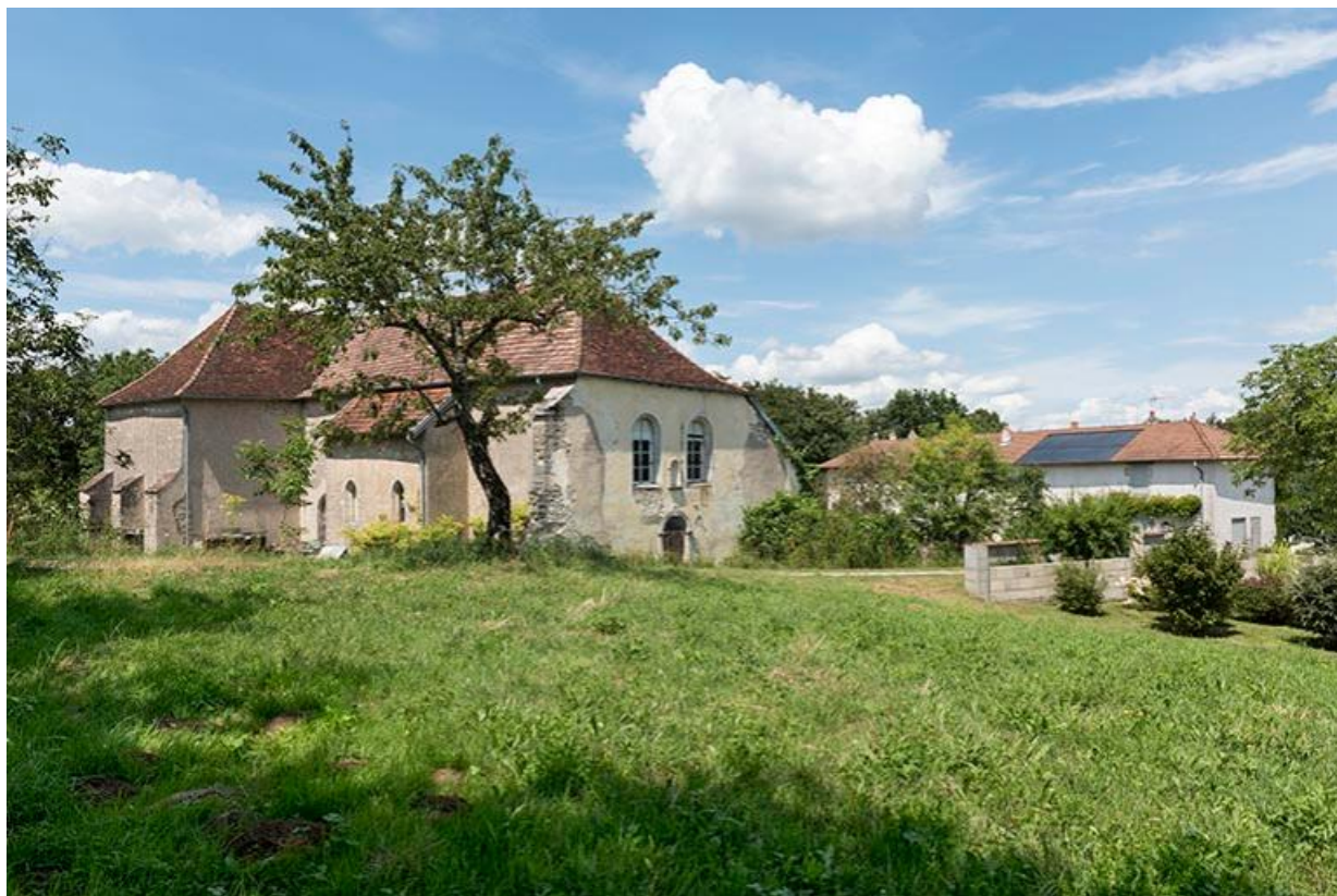
Vue d'ensemble de la chapelle et des anciens bâtiments conventuels 70, Chemilly
