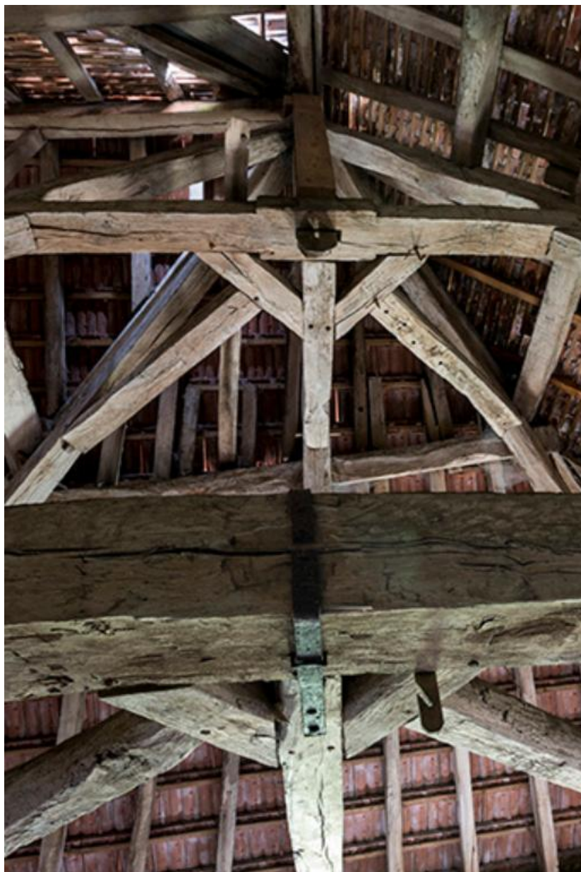
Poutrage du grenier de la chapelle
