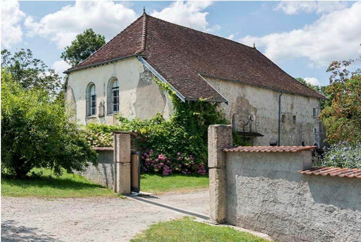
Vue de la chapelle, côté cour 70, Chemilly
