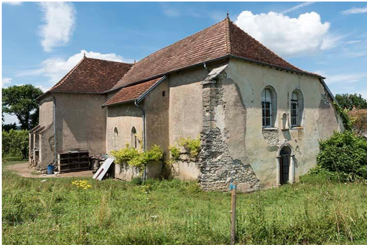
Vue d'ensemble de la chapelle
