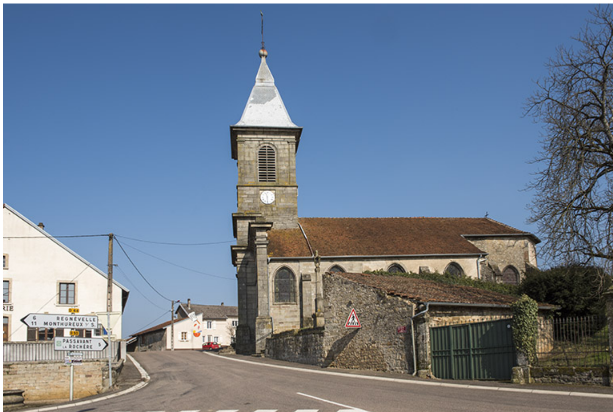
Vue d'ensemble de la façade depuis le sud. 70, Vouécourt rue de la corvée
