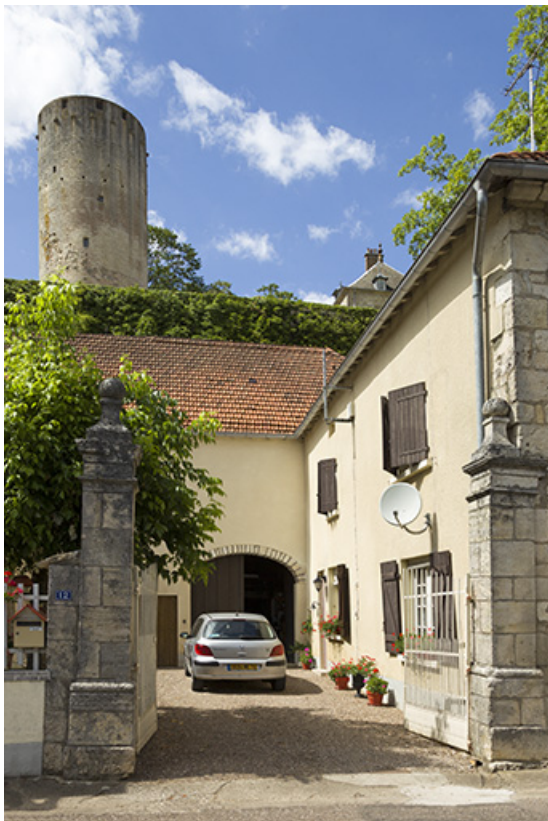
Vue partielle des bâtiments autour de la cour, depuis la rue du Pâquis.
