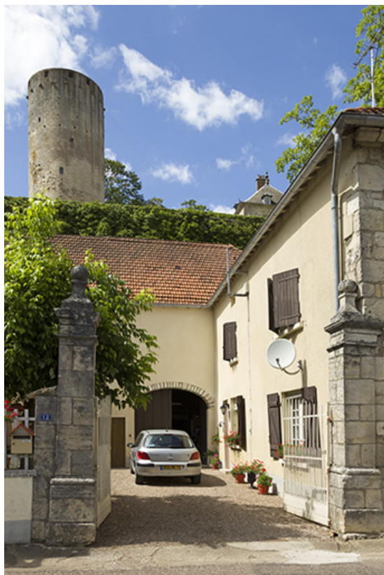
Vue partielle des bâtiments autour de la cour, depuis la rue du Pâquis.
