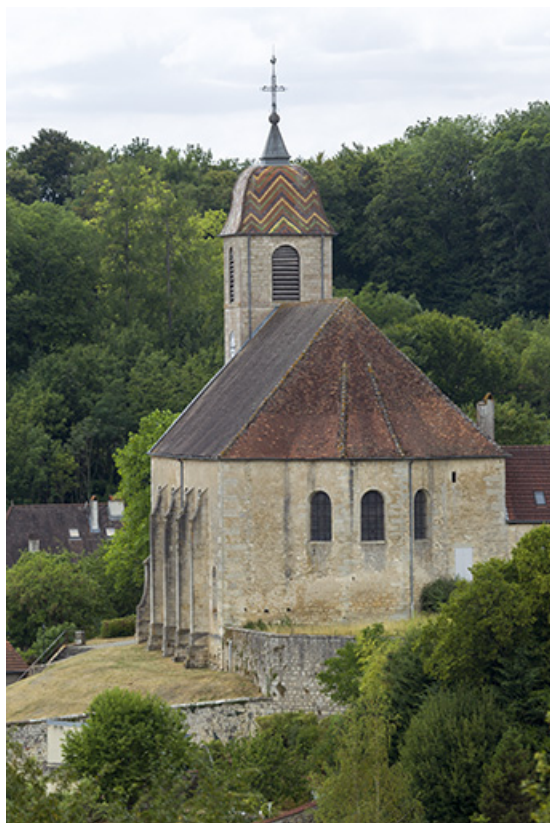
Vue de l'abside depuis la colline du couvent de minimes. 70, Rupt-sur-Saône
