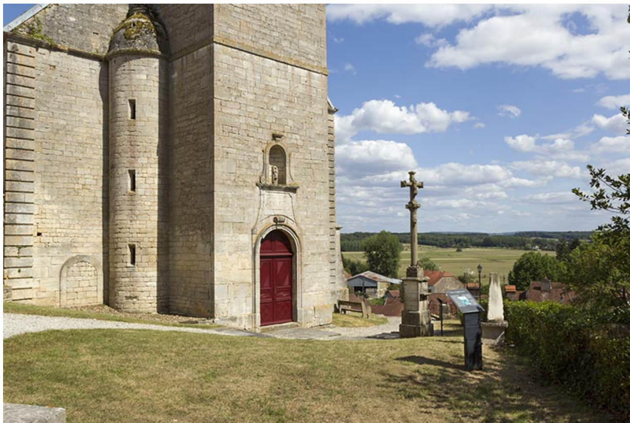
Vue du rez-de-chaussée de la tour-clocher. 70, Rupt-sur-Saône
