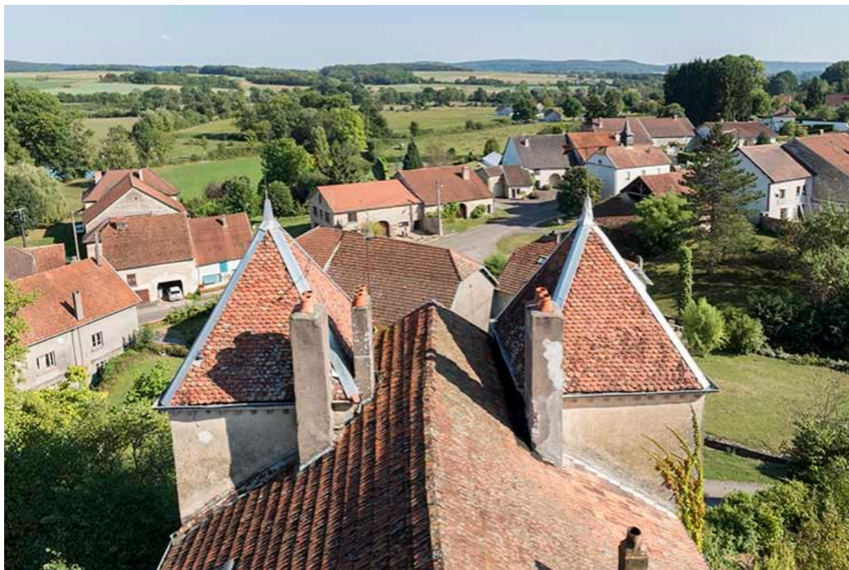
Vue des tours du château et de l'ensemble du village depuis le toit-terrasse du donjon. 70, Chemilly
