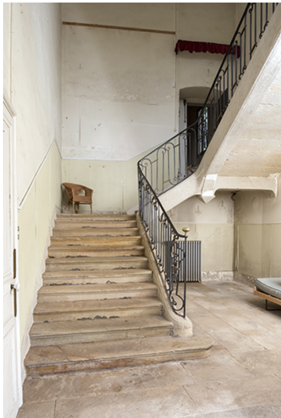
Vue de trois-quart de l'escalier principal.
