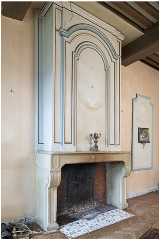
A l'étage : seconde pièce à gauche depuis l'escalier. 70, Vouécourt, 1 rue des Marronniers
