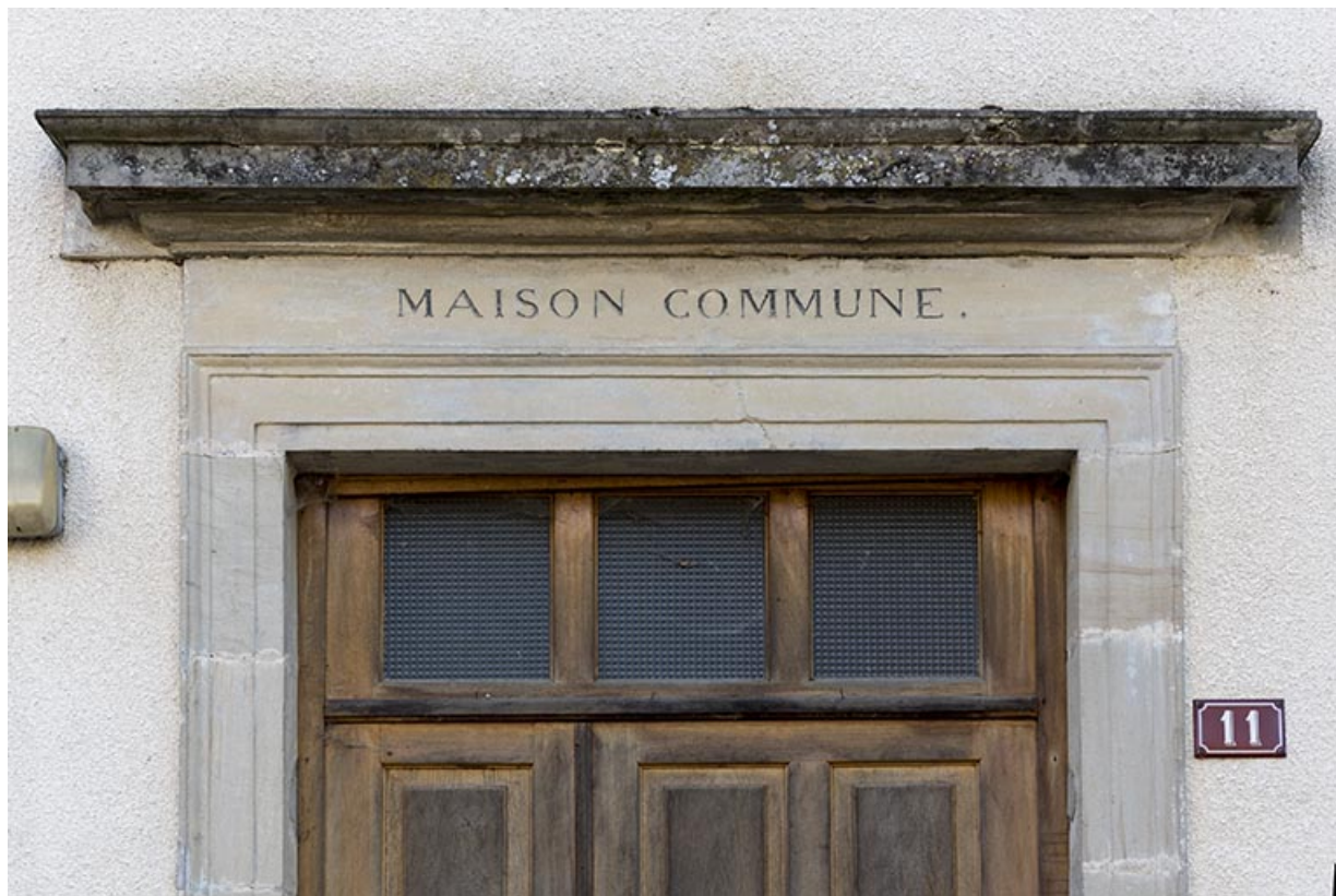
Pignon est : détail du linteau de l'entrée.
