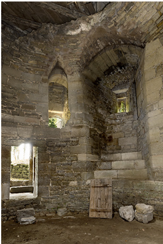
Dans la tour ouest : vue sur l'entrée et l'escalier. 70, Demangevelle
