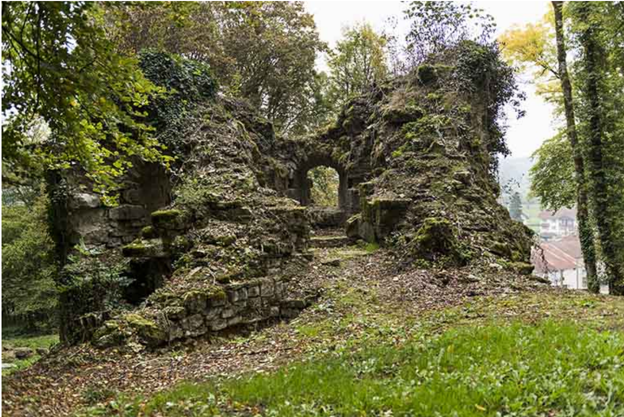
Vue sur la tour est. 70, Demangevelle
