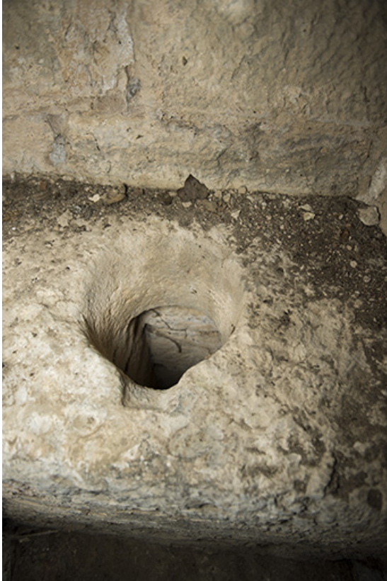
Dans la tour ouest. Détail de latrines.
