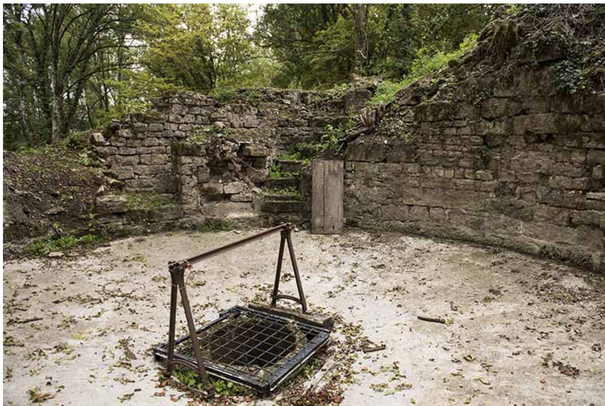
Dans la tour ouest. Vue de la partie sommitale depuis le haut. 70, Demangevelle
