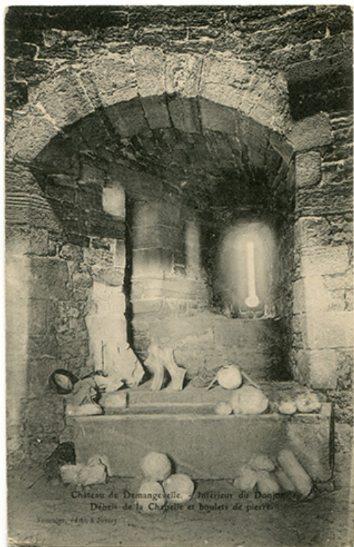
Château de Demangevelle. Intérieur du donjon. Débris de la chapelle et boulets de pierre. Carte postale. 70, Demangevelle
