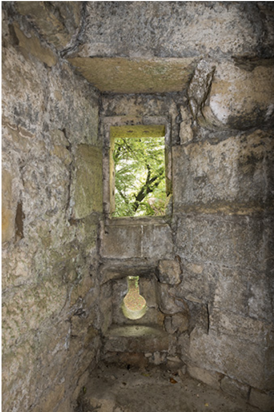
Dans la tour ouest : meurtrière, canonnière. 70, Demangevelle
