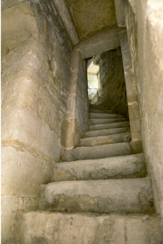
La tour ouest. Vue intérieure de l'escalier. 70, Demangevelle
