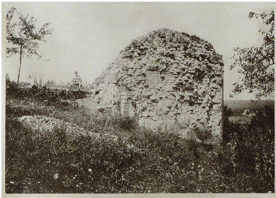
Photographie de Vedastus : les ruines de Demangevelle. Août 1890. 70, Demangevelle
