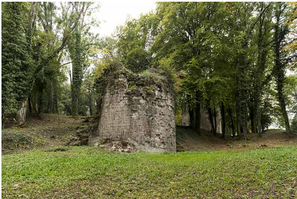
Depuis l'est, vue sur la tour est. La tour ouest est au second plan. 70, Demangevelle
