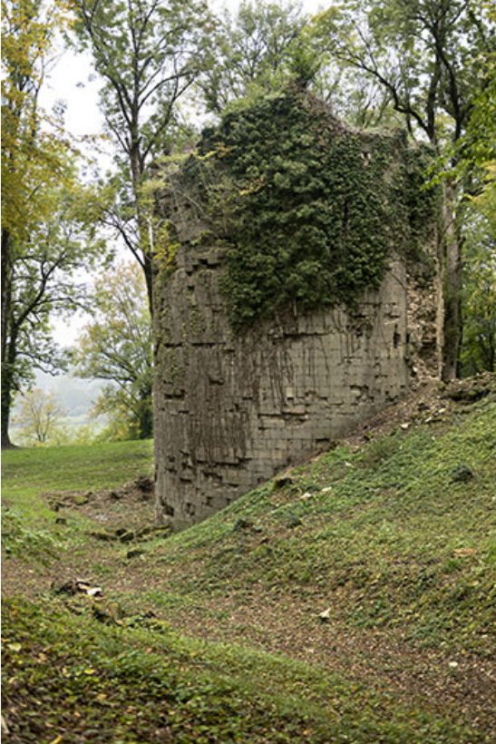
La tour ouest : vue rapprochée du sud. 70, Demangevelle
