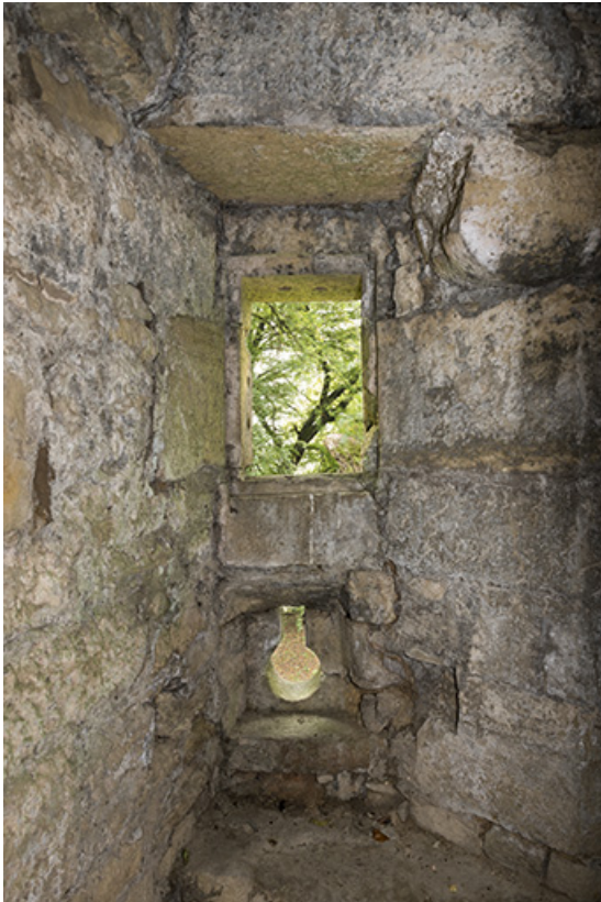
Dans la tour ouest : meurtrière, canonnière. 70, Demangevelle
