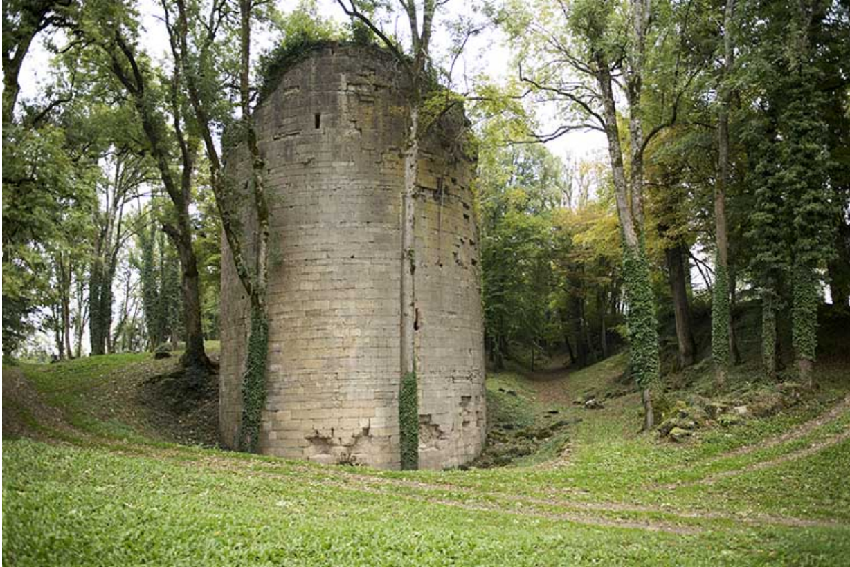
La tour ouest, vue de l'ouest.
