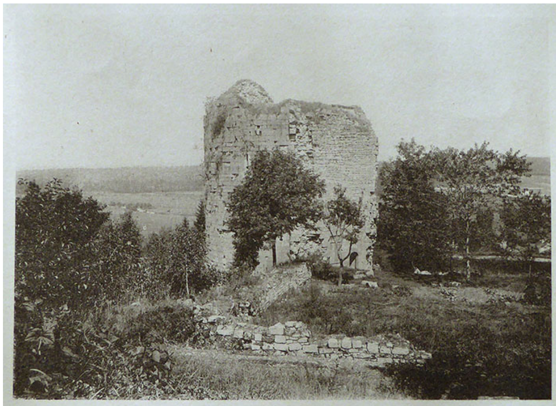
Photographie de Vedastus : les ruines de Demangevelle. Août 1890. 70, Demangevelle
