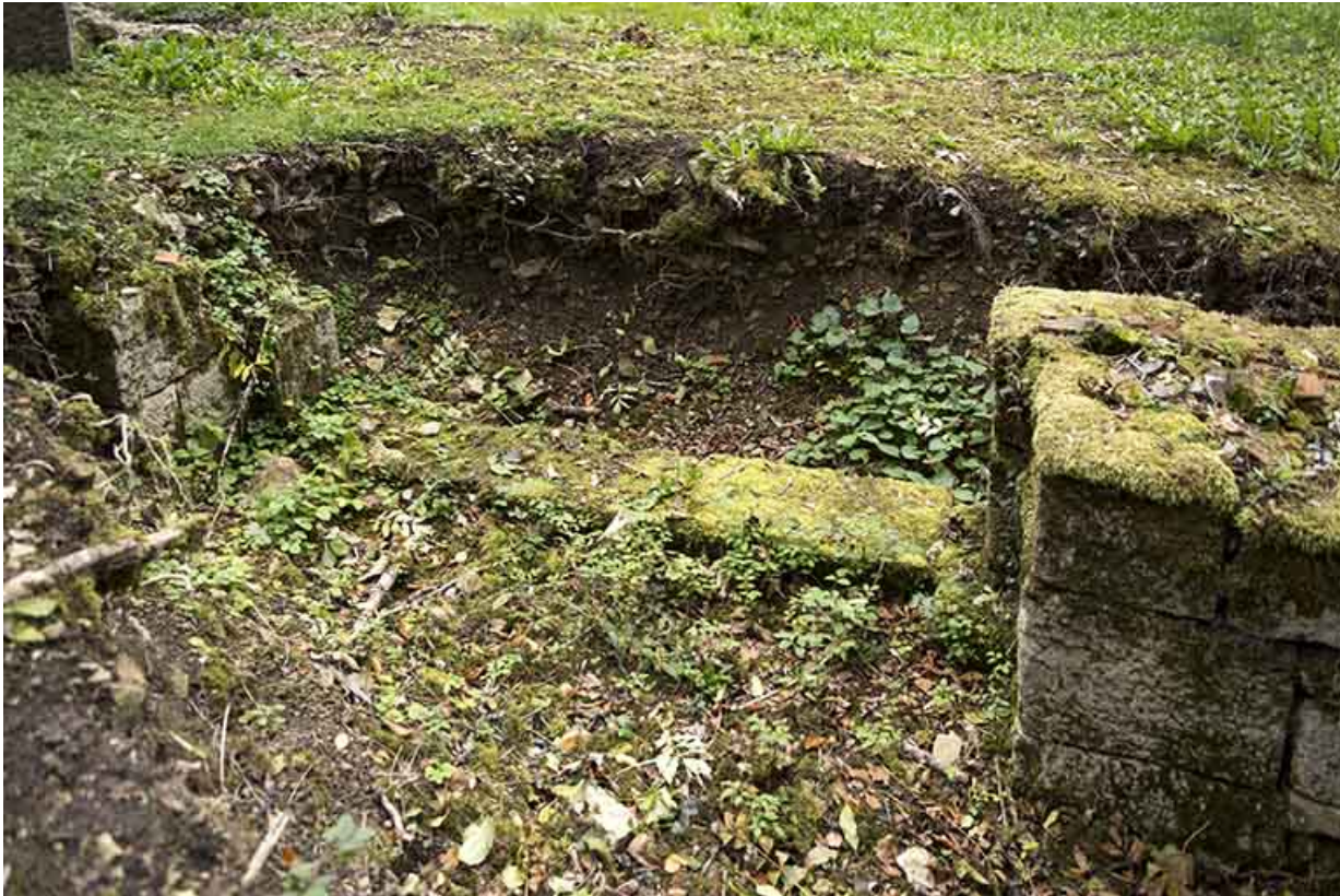
Détail de maçonnerie autour de la tour est. 70, Demangevelle
