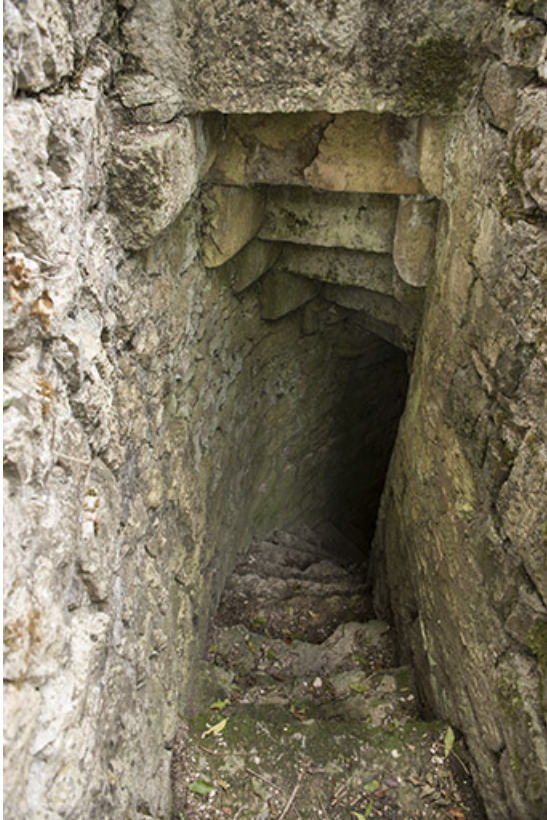
Dans la tour ouest. Vue de l'escalier depuis le haut. 70, Demangevelle
