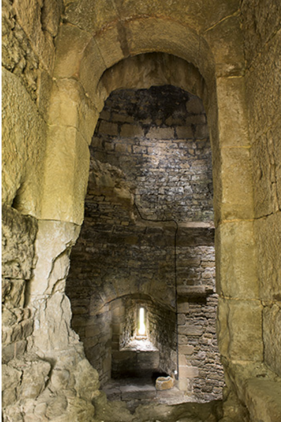
La tour ouest. Vue intérieure depuis l'entrée. 70, Demangevelle
