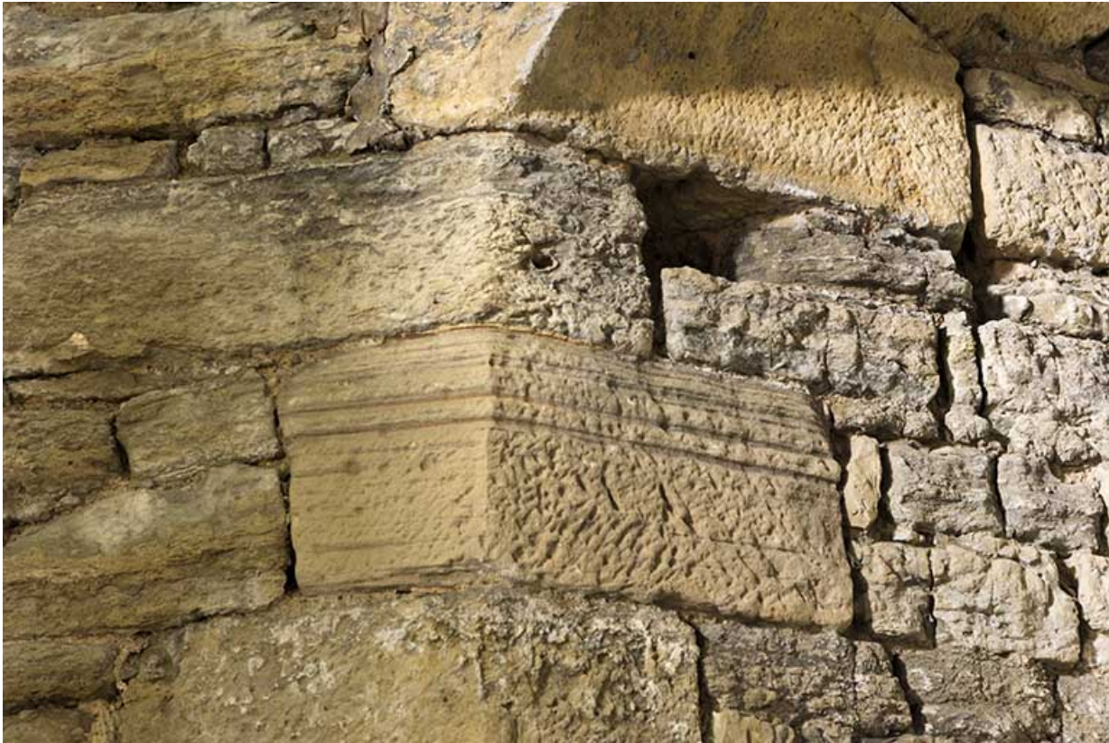
Détail de maçonnerie.
