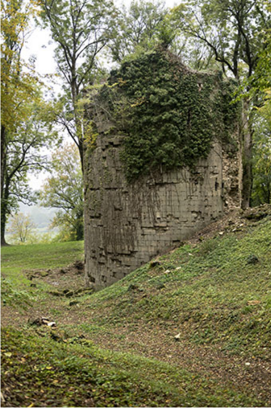
La tour ouest : vue rapprochée du sud.
