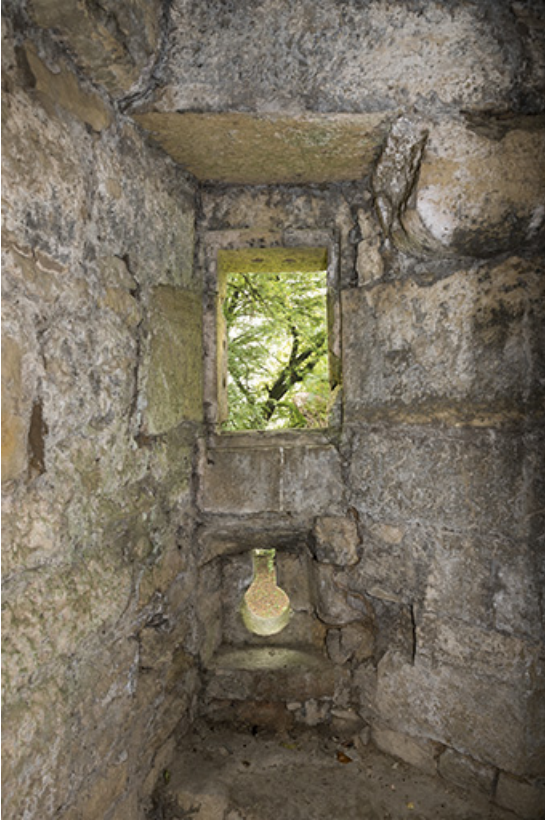
Dans la tour ouest : meurtrière, canonnière. 70, Demangevelle
