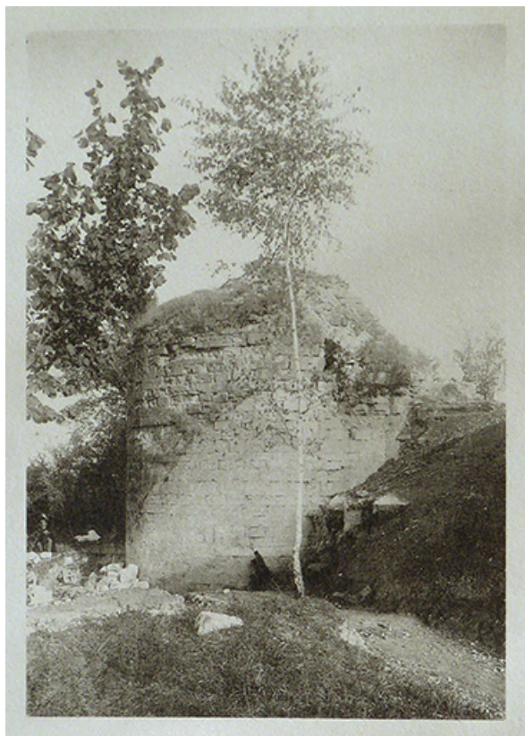
Photographie de Vedastus : les ruines de Demangevelle. Août 1890. 70, Demangevelle
