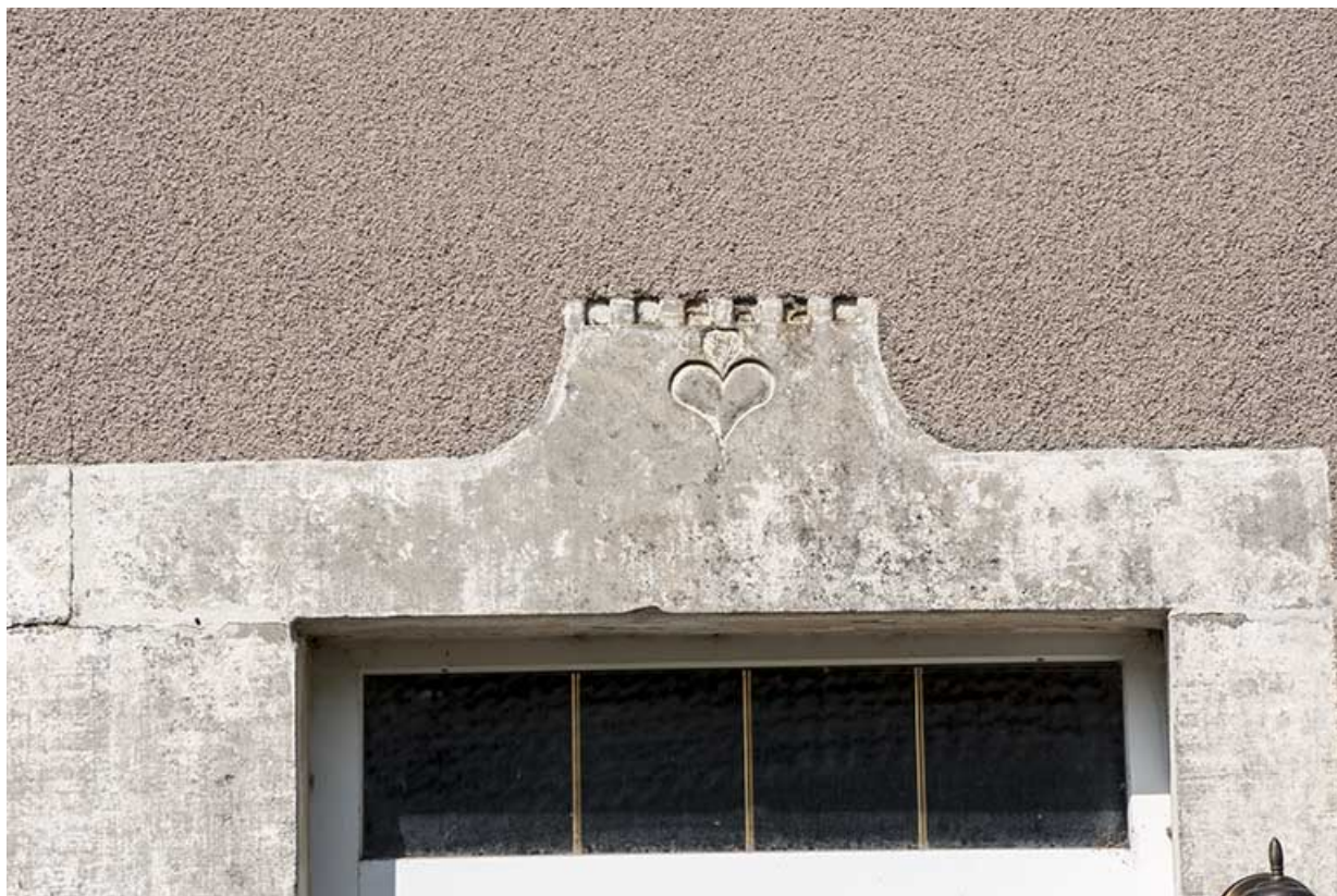
Détail du décor sur les linteaux.
