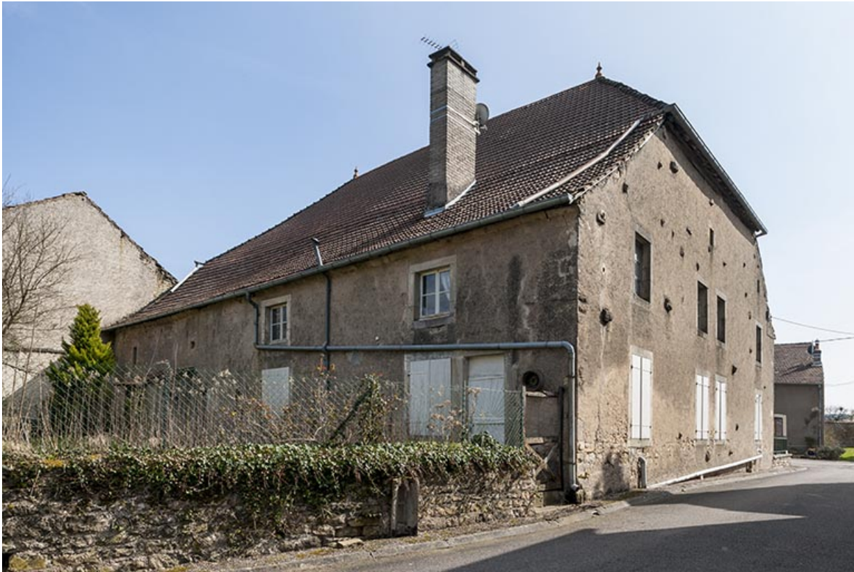
Façade postérieure et mur pignon ouest.
