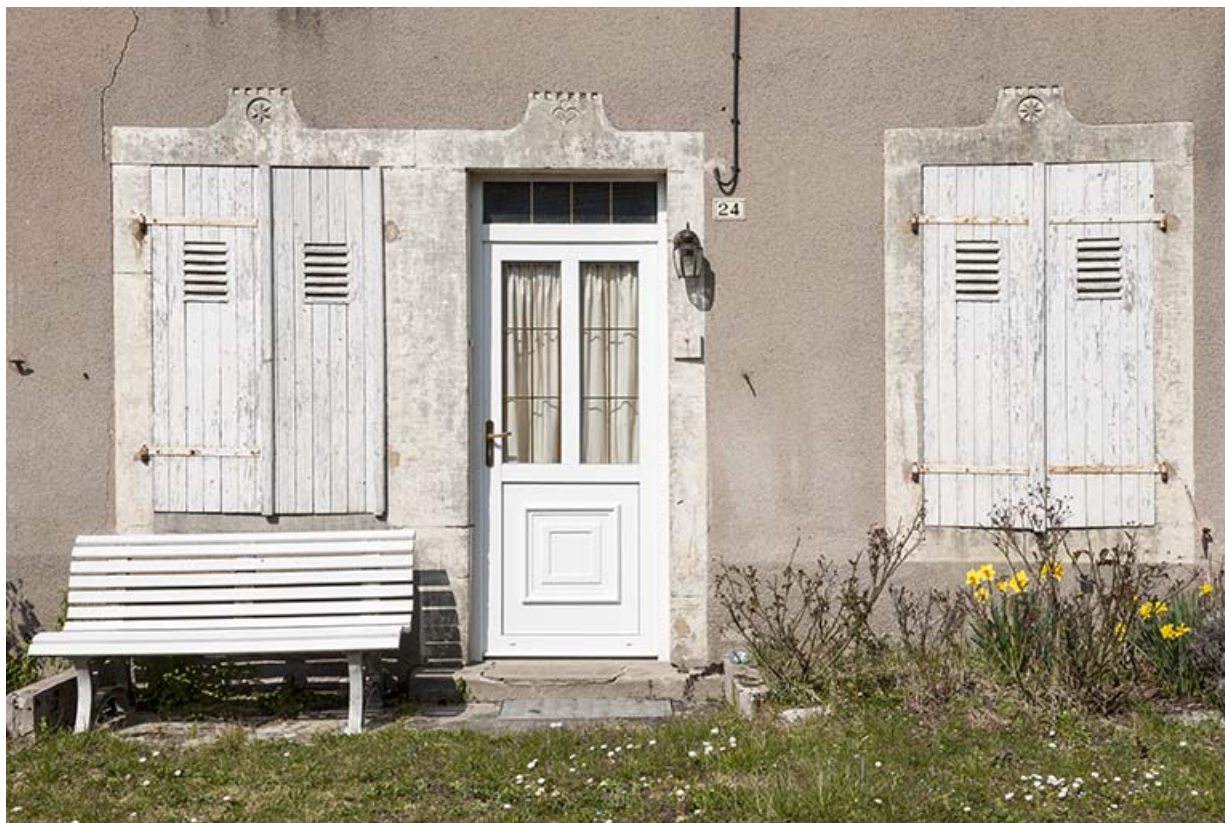
Porte d'entrée, façade principale.
