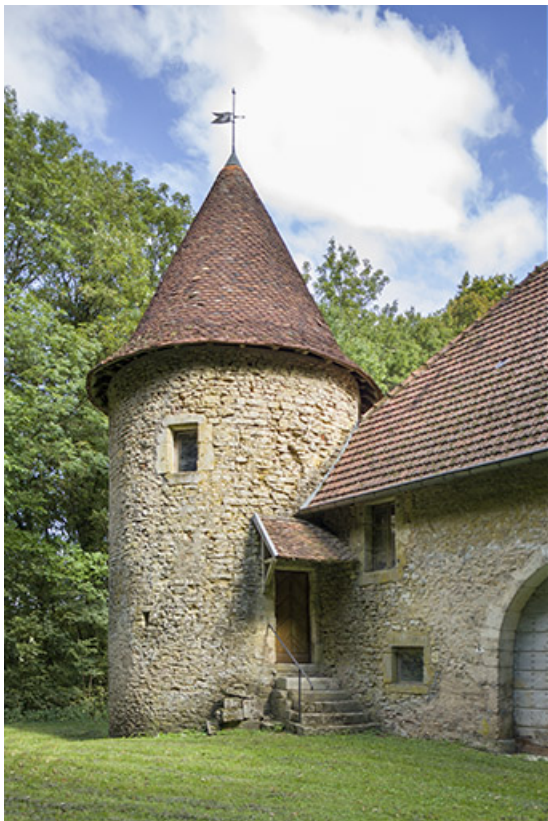
La tour à l'angle nord-est du cuvage.
