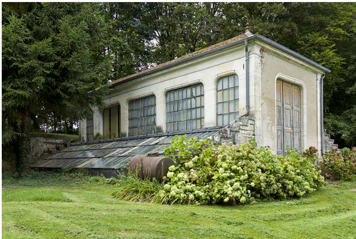
Vue générale sud-est de l'orangerie et de la serre.
