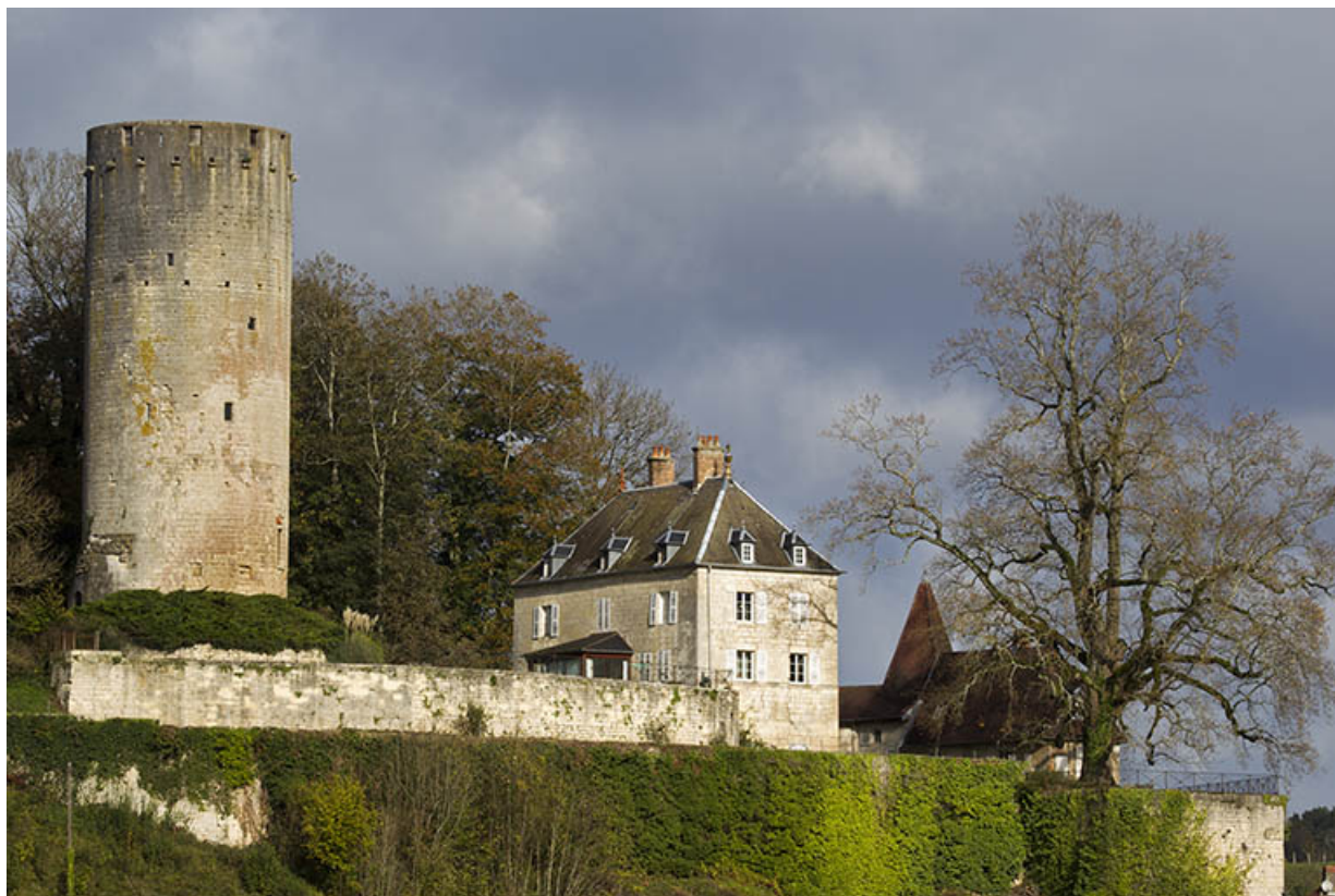
Vue générale depuis le sud avec, de gauche à droite, le donjon, le "nouveau château" et le "vieux château". 70, Rupt-sur-Saône, 5 rue de la Garenne
