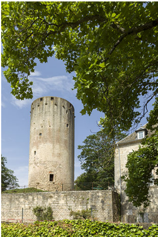
L'ancienne entrée du donjon vue depuis l'est.
