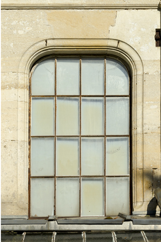
Une des baies de la façade sud de l'orangerie.
