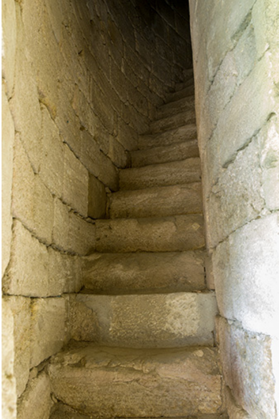
Intérieur du donjon : l'escalier en pierre.
