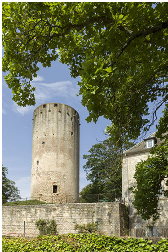
L'ancienne entrée du donjon vue depuis l'est.
