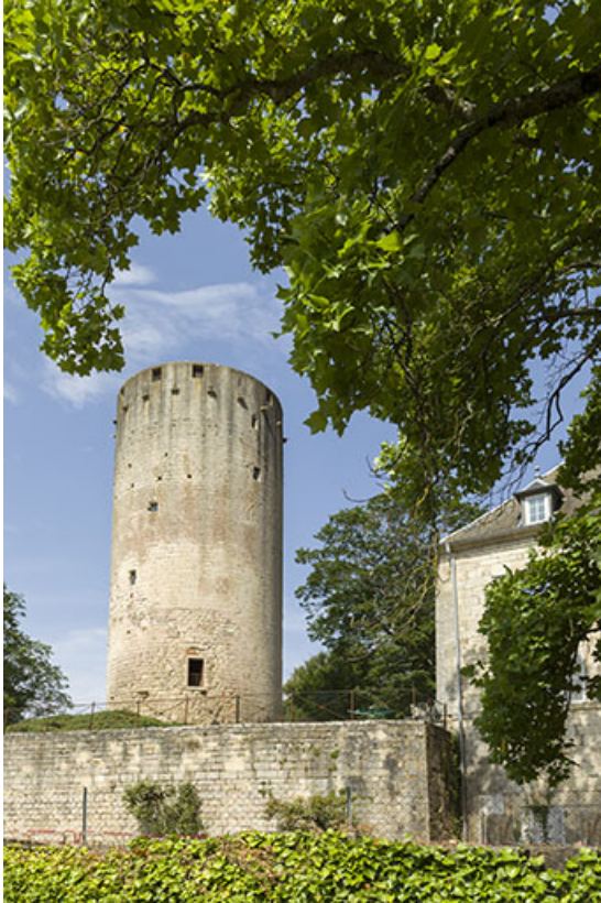
L'ancienne entrée du donjon vue depuis l'est.
