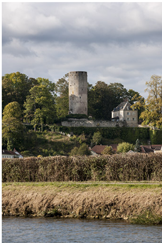
Le donjon et le "nouveau château" (la "gentilhommière") depuis la Saône. 70, Rupt-sur-Saône, 5 rue de la Garenne
