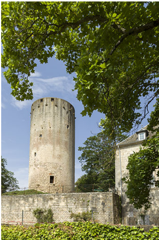
L'ancienne entrée du donjon vue depuis l'est.
