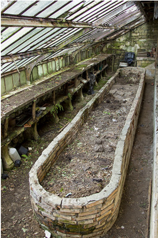
Intérieur de la serre accolée à la façade sud. 70, Rupt-sur-Saône, 5 rue de la Garenne
