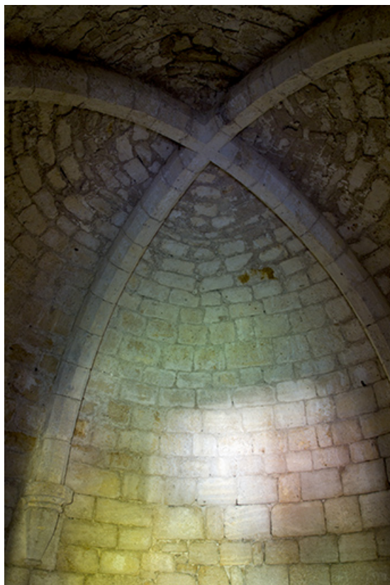
Intérieur du donjon : salle du 1er niveau voûtée d'ogives.
