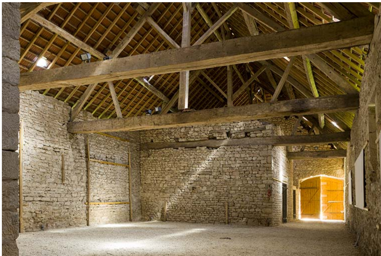
Intérieur du cuvage, en direction du sud-est. 70, Rupt-sur-Saône, 5 rue de la Garenne
