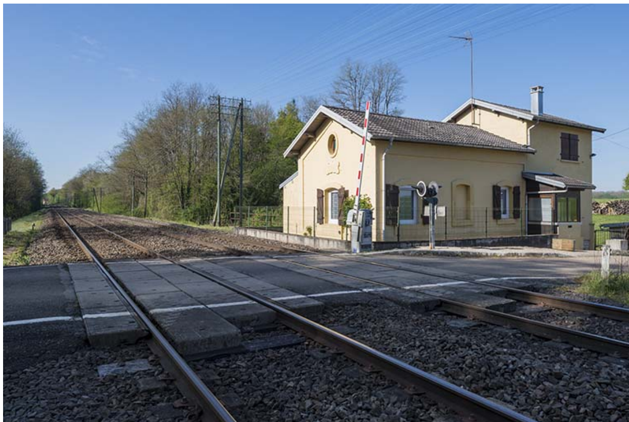
Vue depuis le Nord. 70, Chaux-lès-Port
