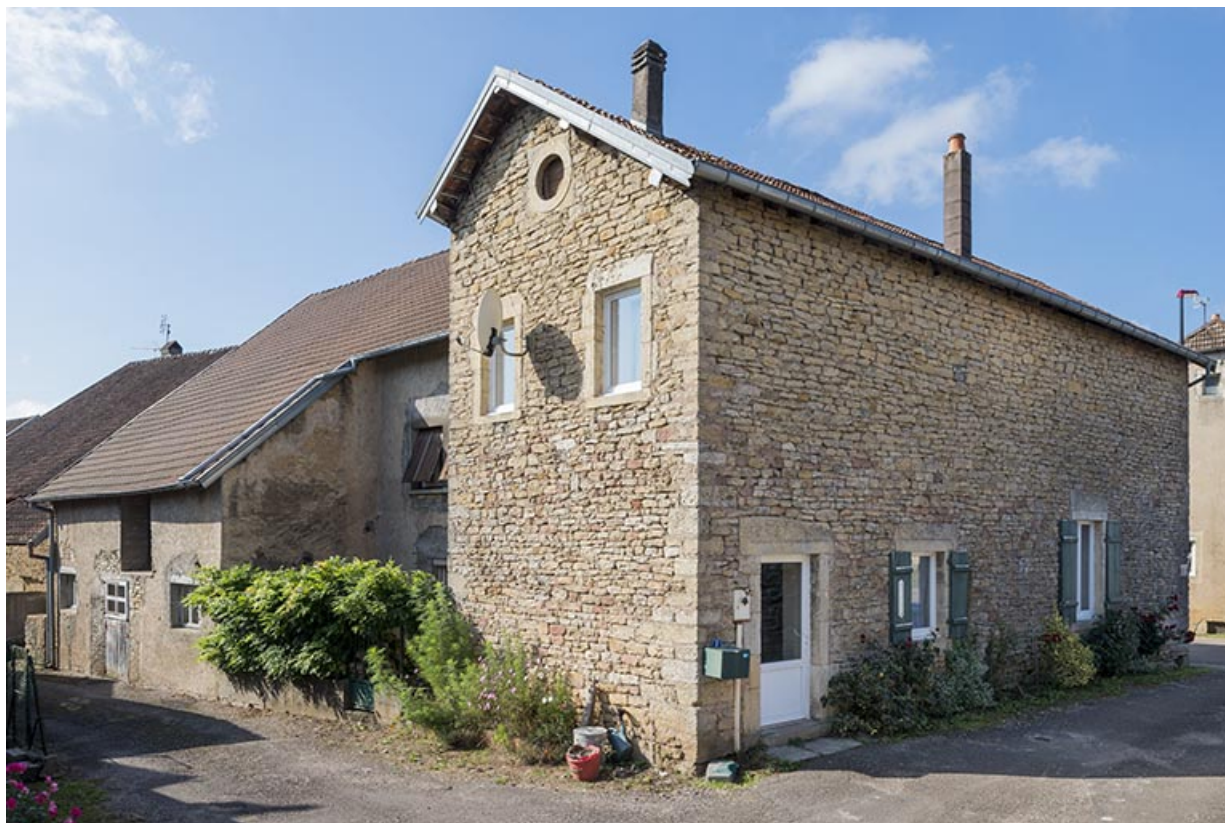
Maison située à l'angle de la rue du Cornot et de la Grande rue. 70, Vauchoux
