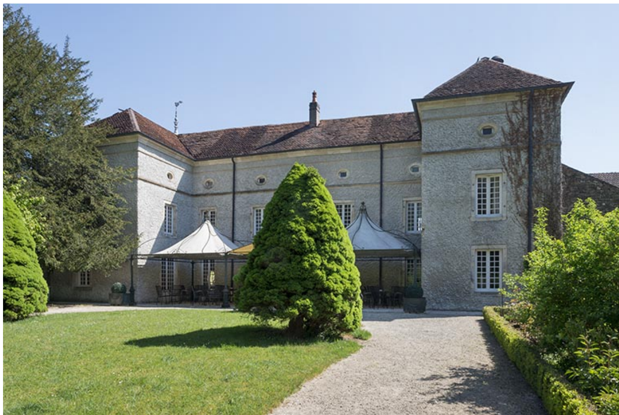
Vue générale, façade postérieure.
