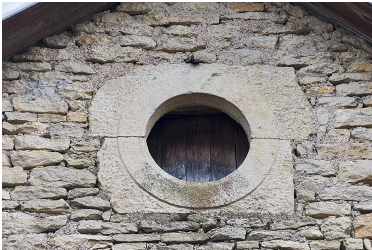
L'oculus, sur le pignon de la maison.
