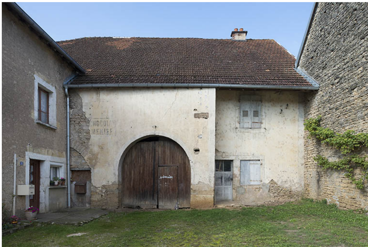
La grange avec le retour en équerre du logis. 70, Vauchoux
