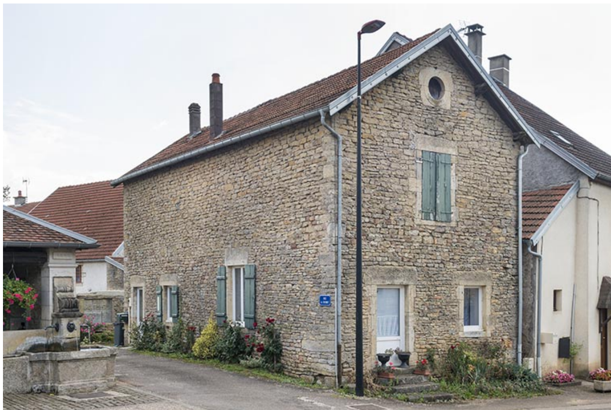
Vue de la maison depuis la Grande rue. 70, Vauchoux
