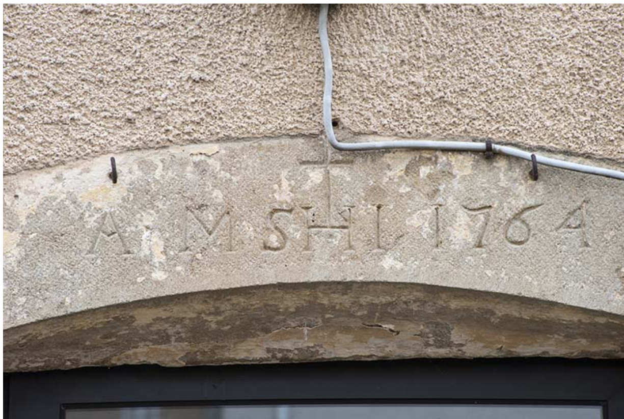
Date portée sur le linteau de la porte.
