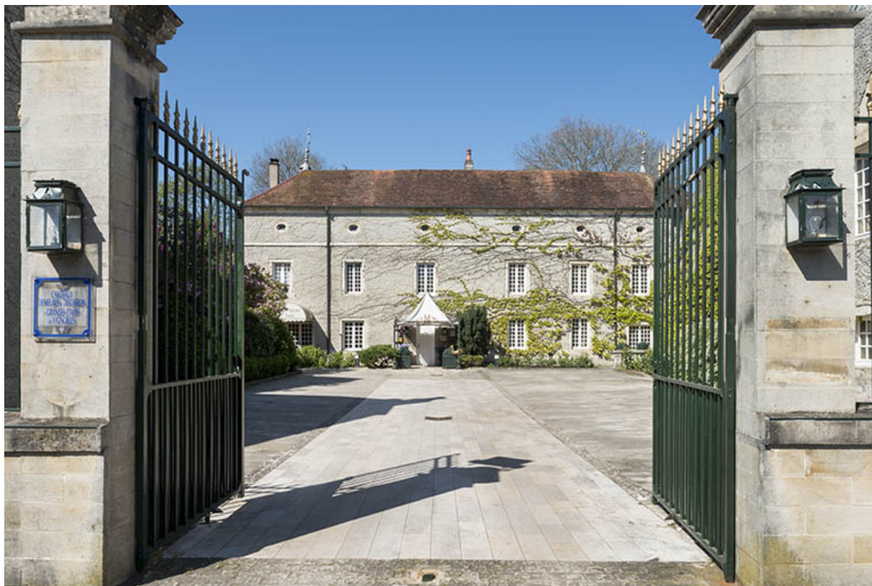
Le chateau, vue générale de la façade principale. 70, Vauchoux
