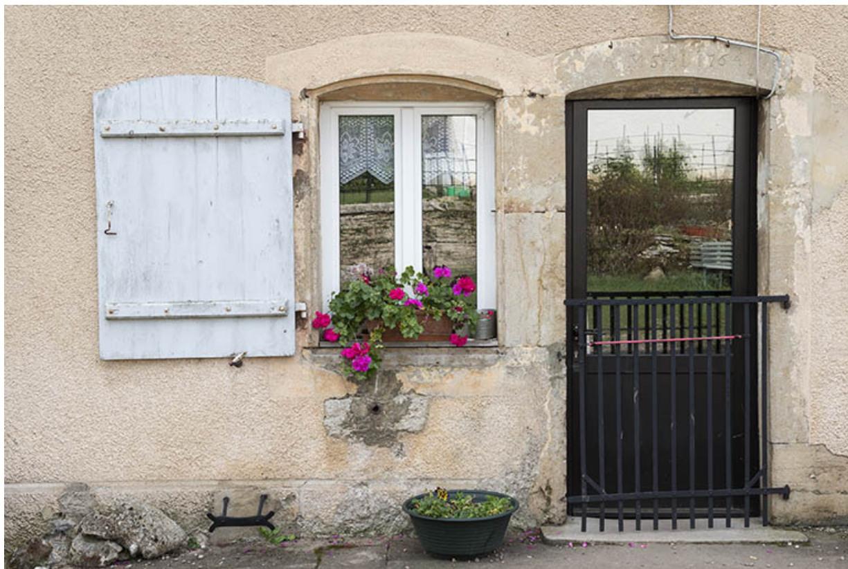
Détail, porte d'entrée de la partie habitation. 70, Vauchoux
