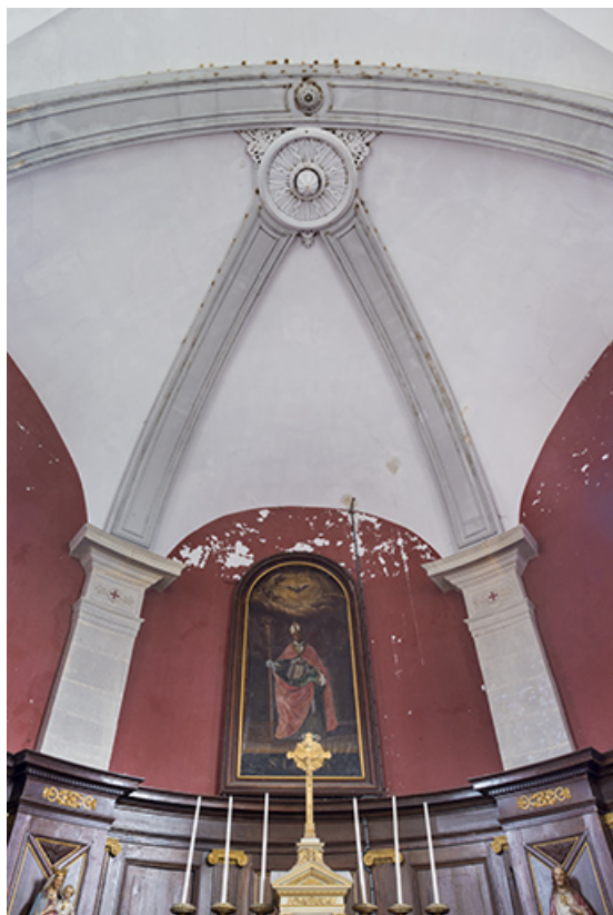
La voûte du chœur.
