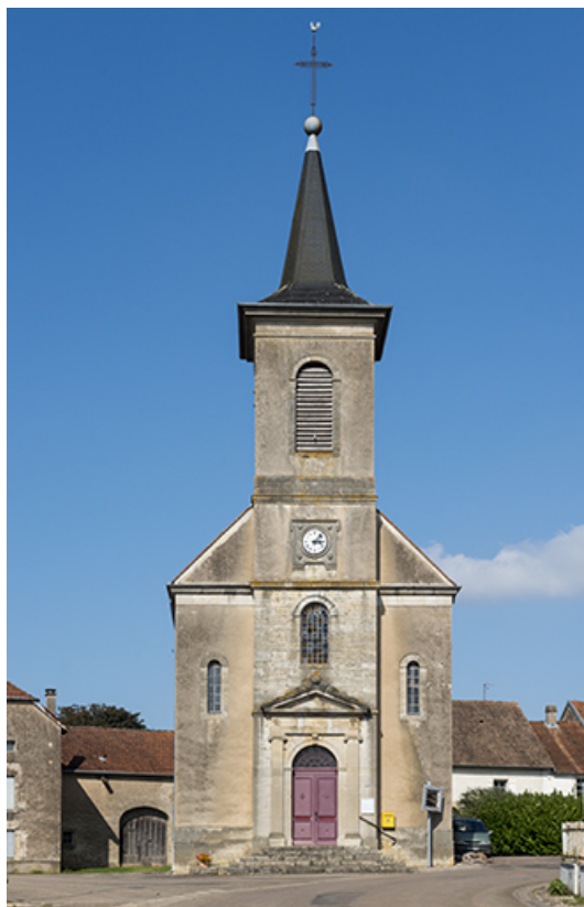
L'édifice depuis la Grande rue.
