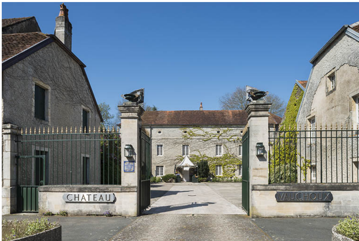
Le chateau, vue générale depuis la Grande rue. 70, Vauchoux
