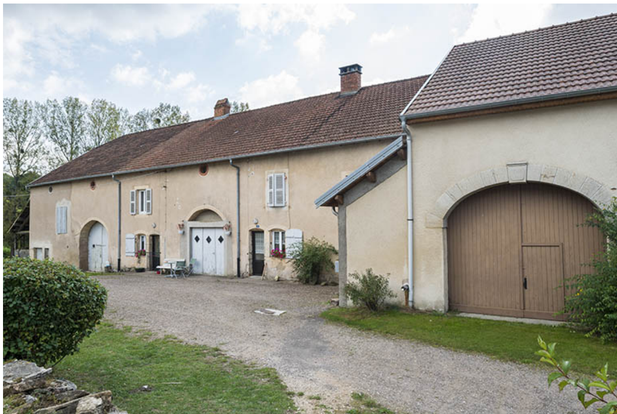
Alignement de fermes, rue de la Fontaine. 70, Vauchoux
