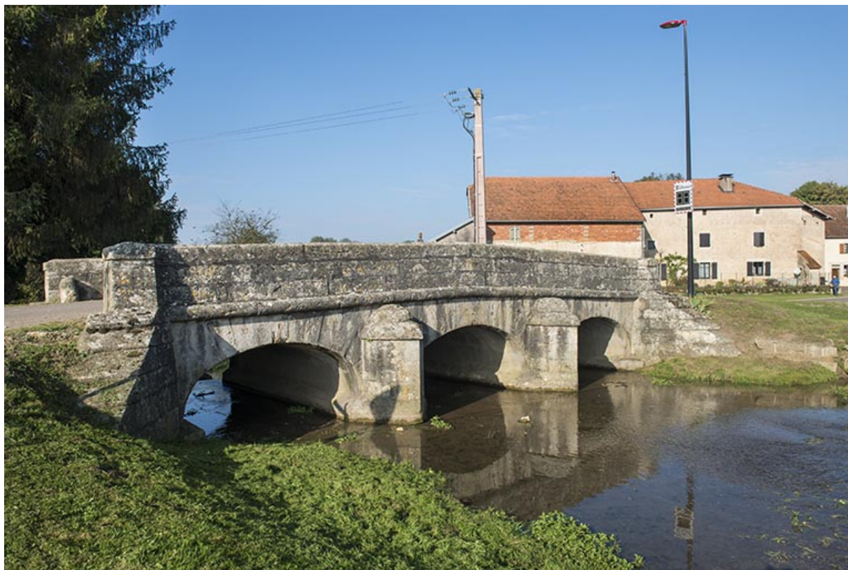
Pont enjambeant le ruisseau, la Scyotte. 70, Vauchoux
