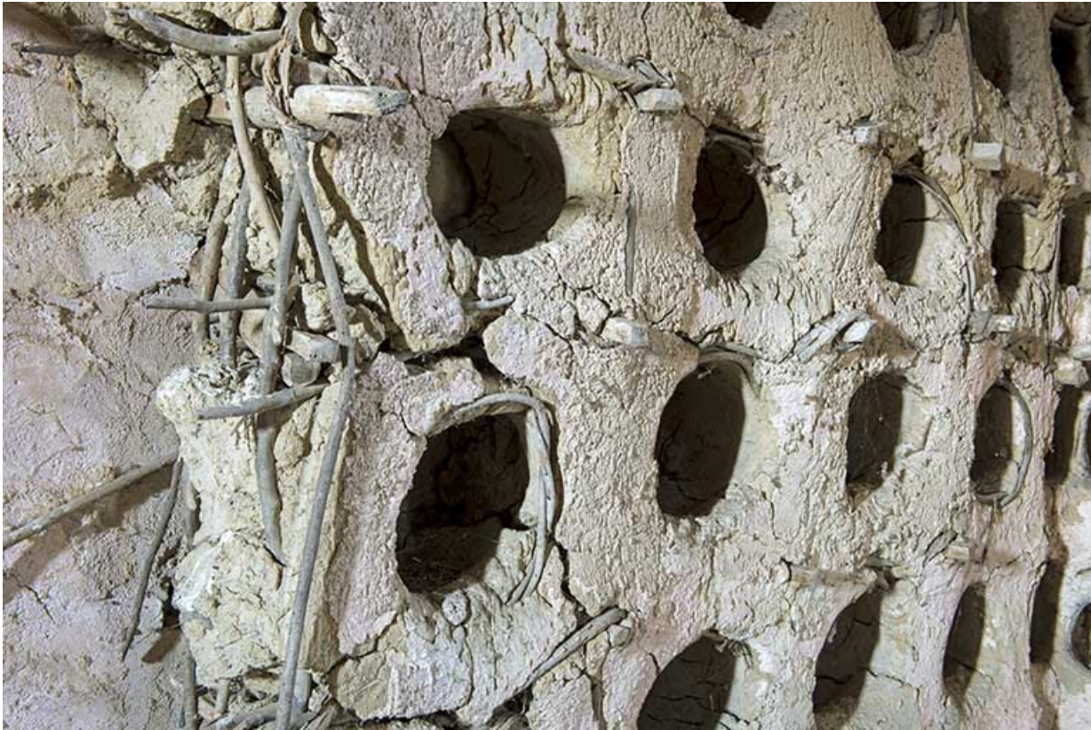
Détail sur la construction des boulins.
