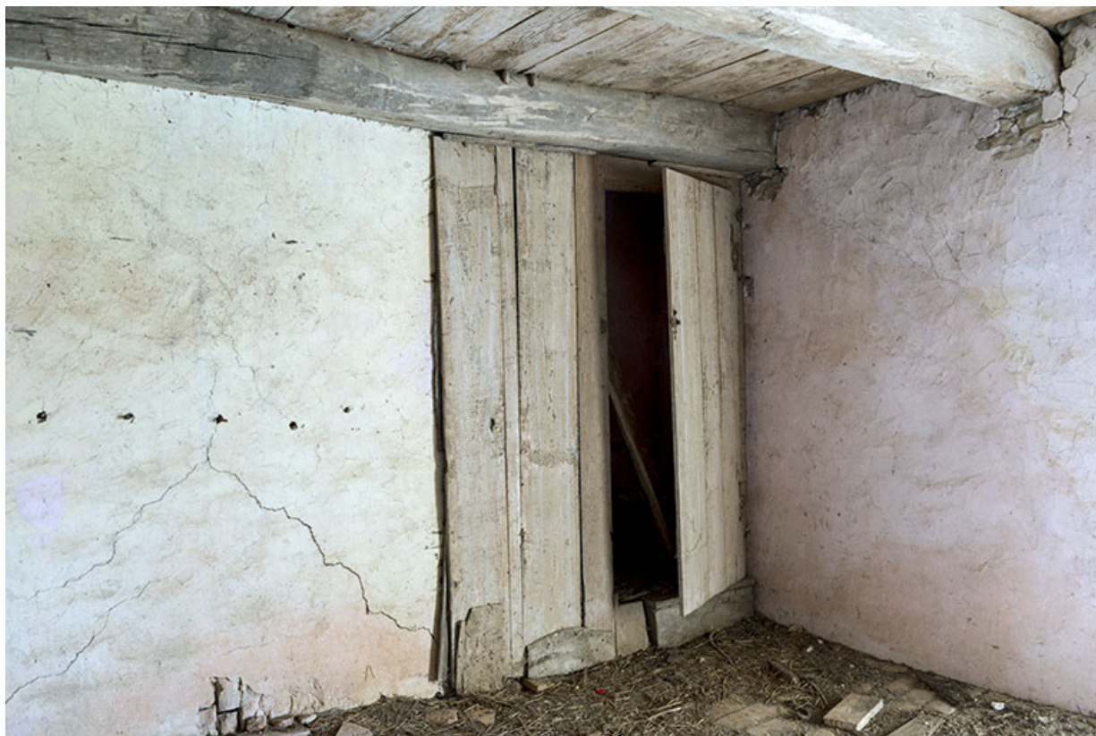
Porte pour accéder à l'étage du pigeonnier.
