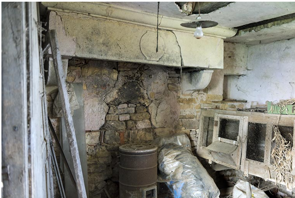
Cheminée au rez-de-chaussée du pigeonnier.
