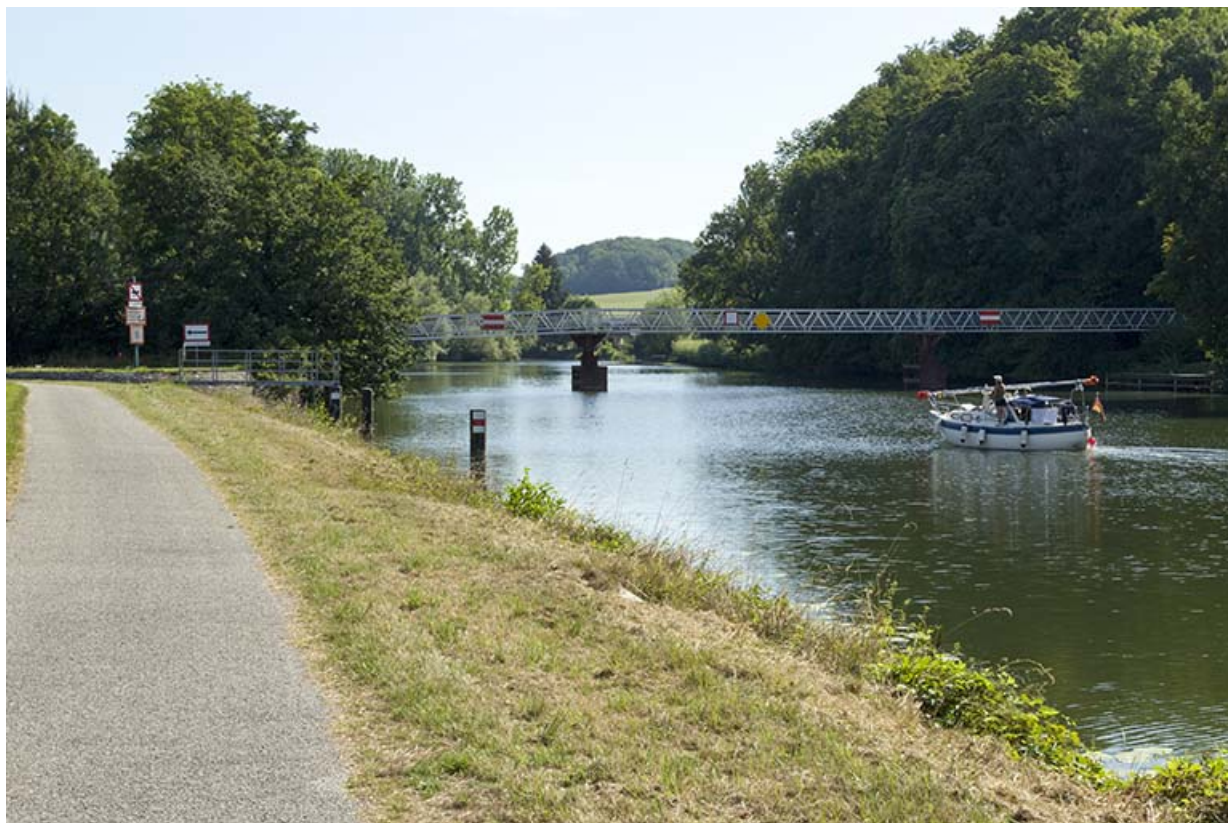
Entrée aval de la dérivation de Chemilly et une passerelle surmontant la Saône. 70, Scey-sur-Saône-et-Saint-Albin
