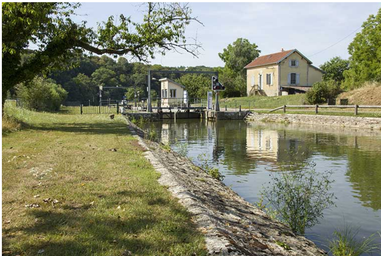
Depuis la rive gauche en amont, vue sur le site d'écluse. 70, Ferrières-lès-Scey
