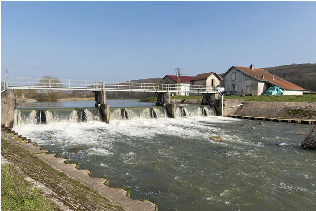
Le barrage vu de la rive droite en aval.
