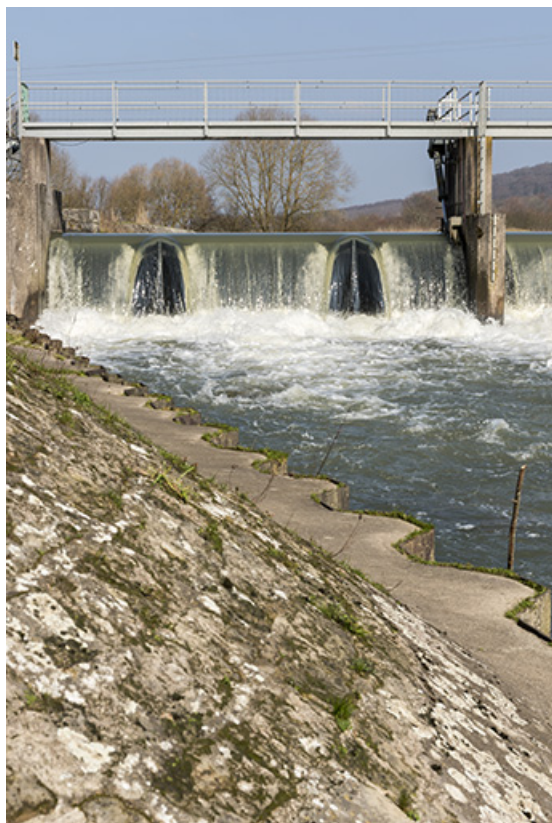
Vue de détail de la berge et du barrage depuis la rive droite en aval.
