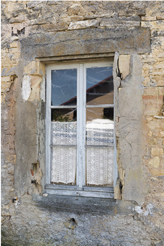
Détail d'une ouverture, mur pignon.
