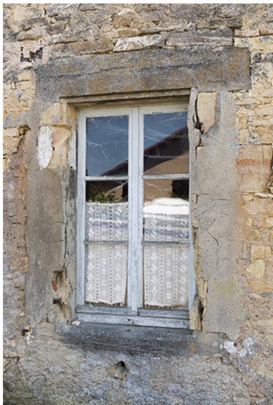
Détail d'une ouverture, mur pignon.
