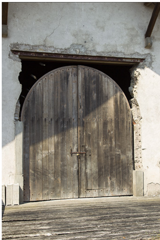
Détail d'une porte de grange sur la façade est des ateliers municipaux. 70, Demangevelle
