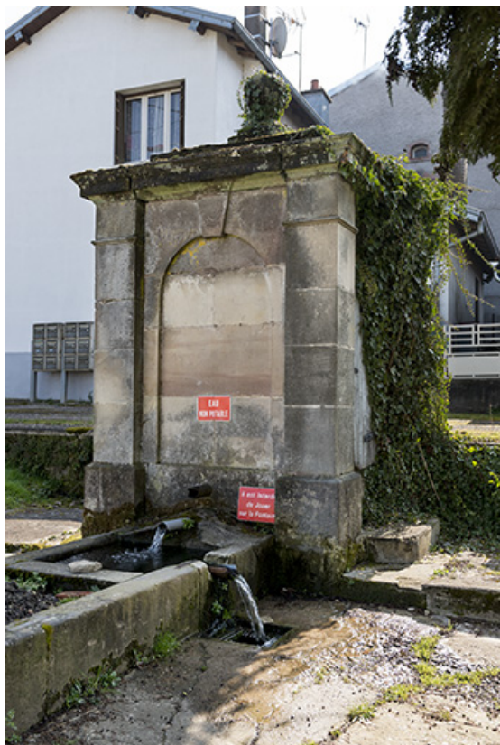
Fontaine vue de trois-quart.
