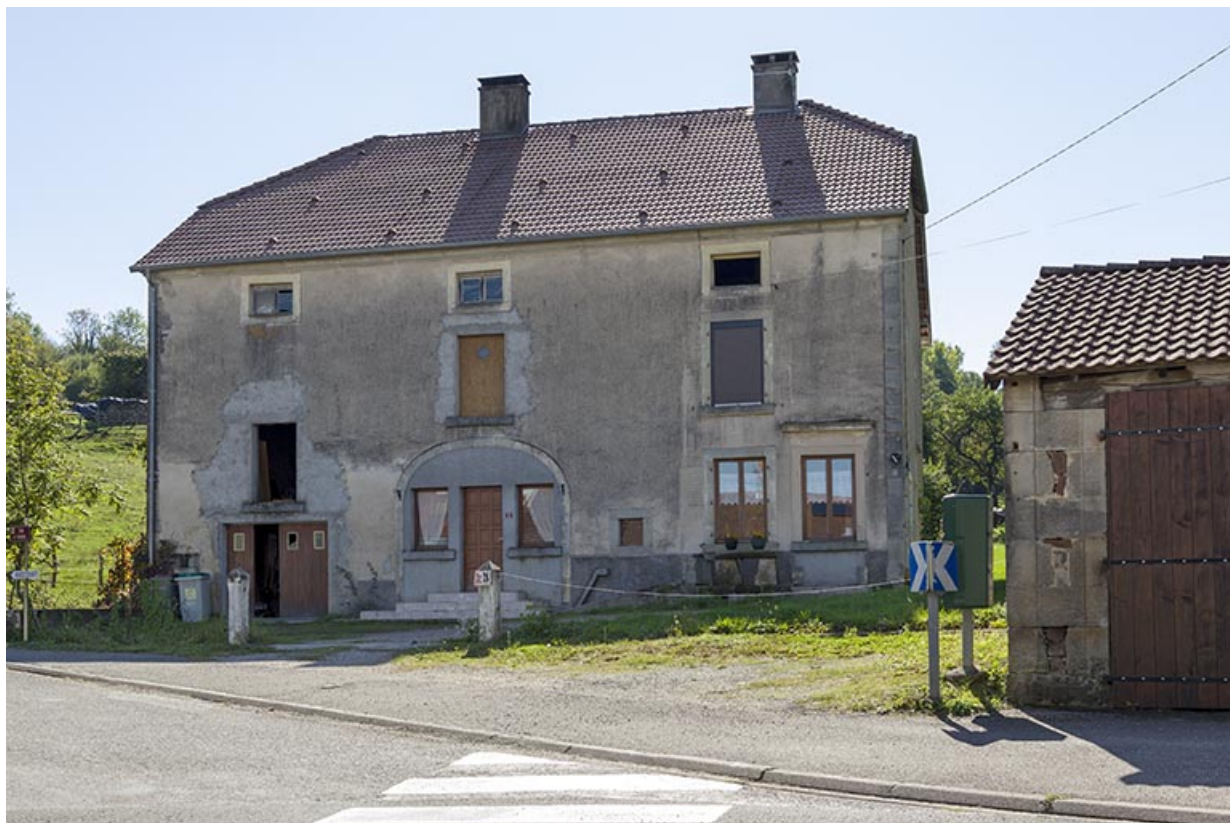
Maison 2 rue Saint isidore 70, Demangevelle
