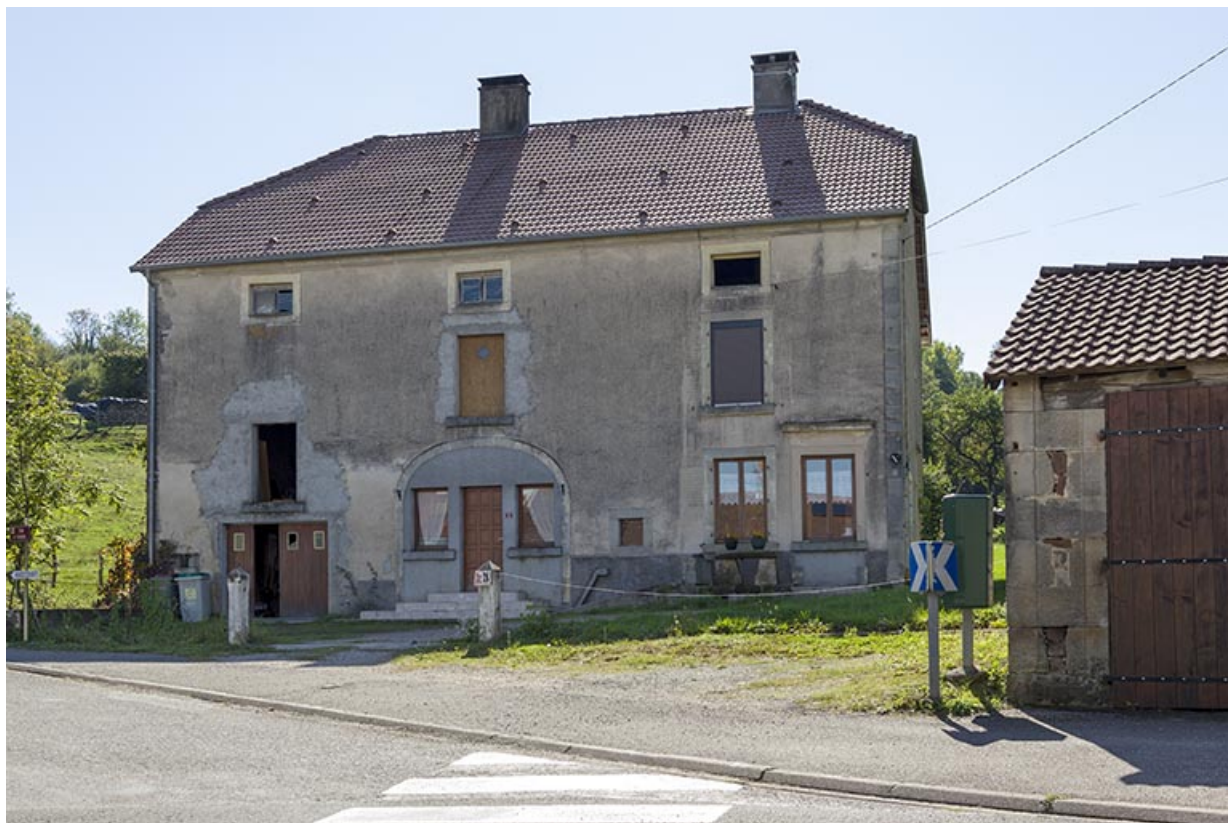
Maison 2 rue Saint isidore 70, Demangevelle
