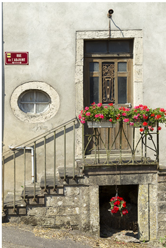
Vue rapprochée de l'entrée principale de la maison 3, rue de l'adjoint. 70, Demangevelle
