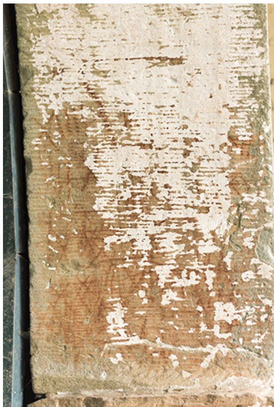
Détail d'une pierre de la porte de grange.
