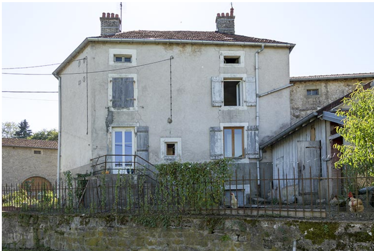
Façade postérieure de la maison d'habitation, 28 grande rue. 70, Demangevelle
