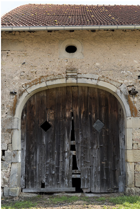
Alignement en bas du village, au nord de la fontaine. Détail de la porte charretière en anse de panier et de l'oculus ovale oblong. 70, Demangevelle
