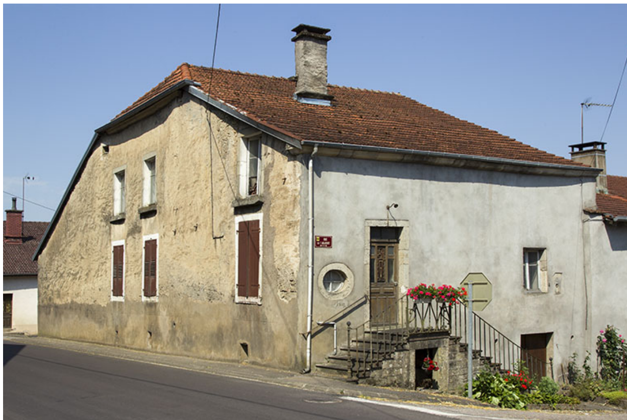
Maison 3 rue de l'adjoint, à l'angle de la grande rue. 70, Demangevelle
