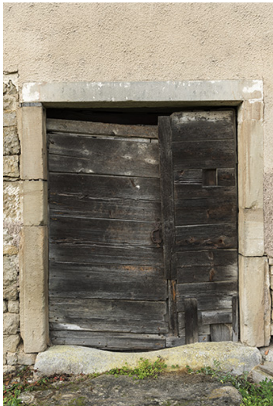
Détail de la porte d'écurie de la maison 7 Rue Bernard Froeliger. 70, Corre
