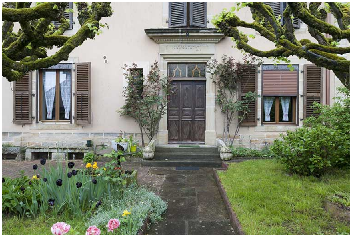
Le rez-de-chaussée, façade principale.
