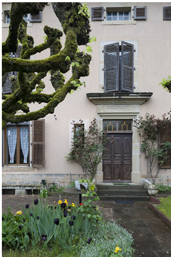
Vue sur la travée centrale, avec la porte d'entrée, la fenêtre reposant sur une corniche et le fenestron. 70, Montureux-lès-Baulay, 27 Grande Rue
