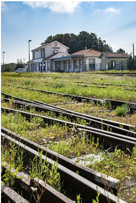
La gare, vue éloignée depuis les voies.
