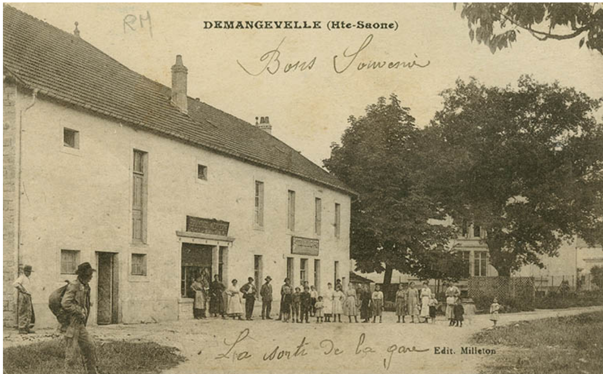
Demangevelle. La sortie de la gare. Carte postale. 70, Demangevelle
