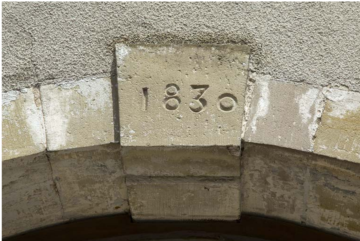
Détail de la clé de voute de la porte cochère portant la date 1830.
