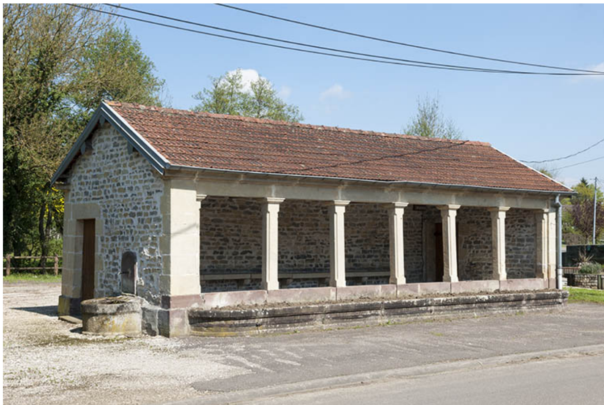
Vue générale depuis le nord.
