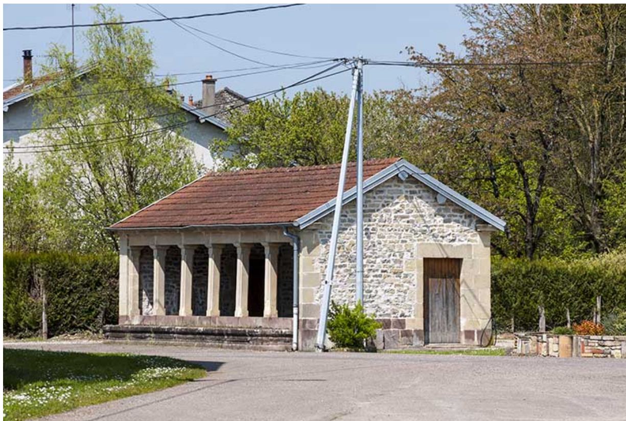
Lavoir-fontaine du colombier. 70, Montureux-lès-Baulay
