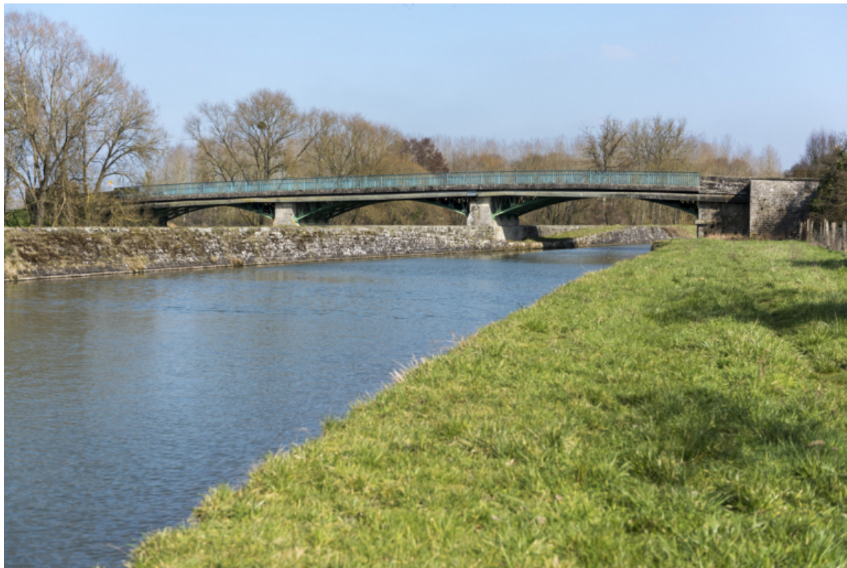
Vue depuis l'aval
