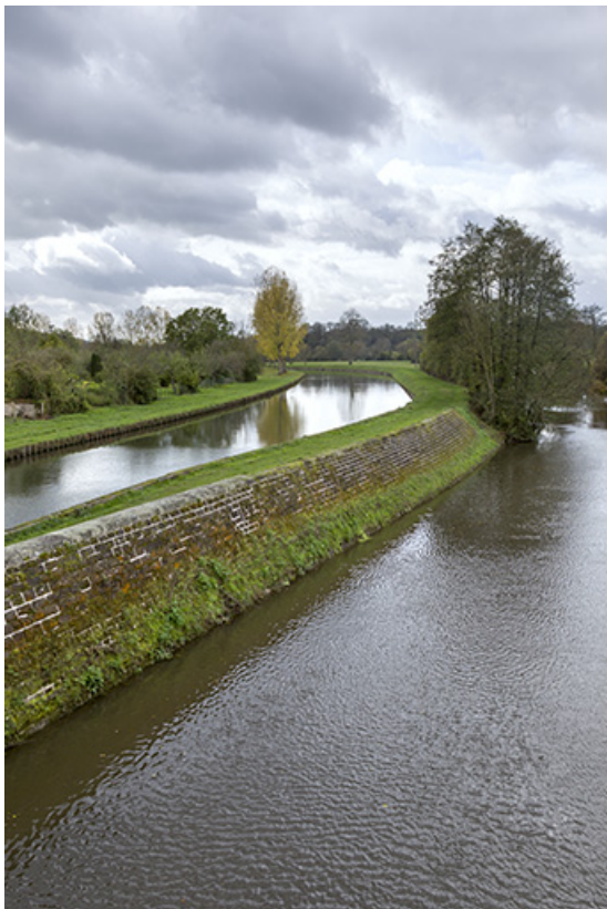
La dérivation construite latéralement à la rivière. 70, Ormoy
