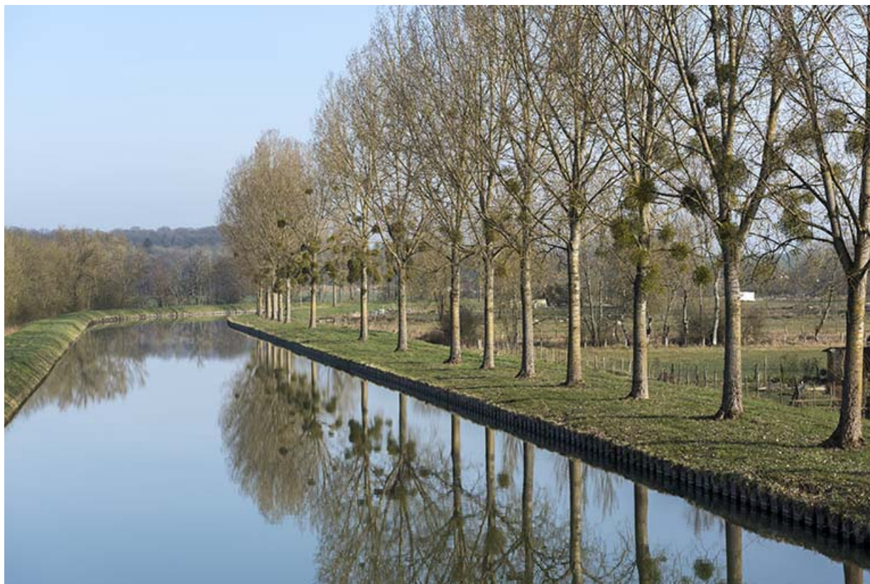
Le canal, vue vers l'amont.
