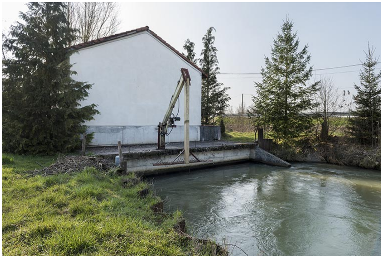
Appareil lié à l'entretien du bief.
