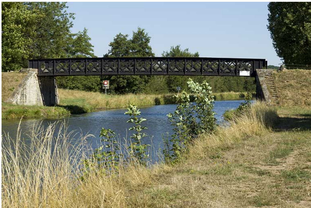
Le pont depuis l'aval.
