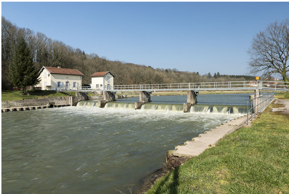
Le site du barrage mobile, vue d'ensemble. 70, Ormoy
