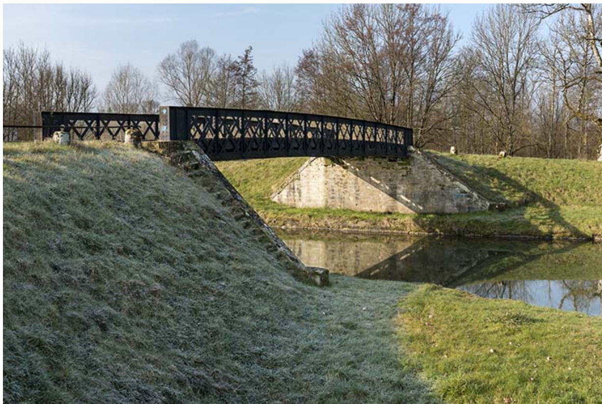
Pont du Devez.
