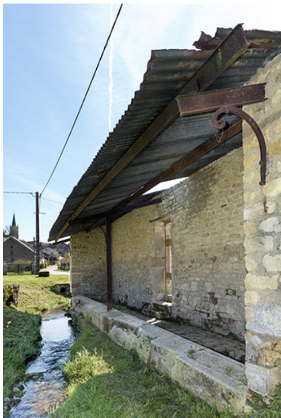
Intérieur du lavoir.
