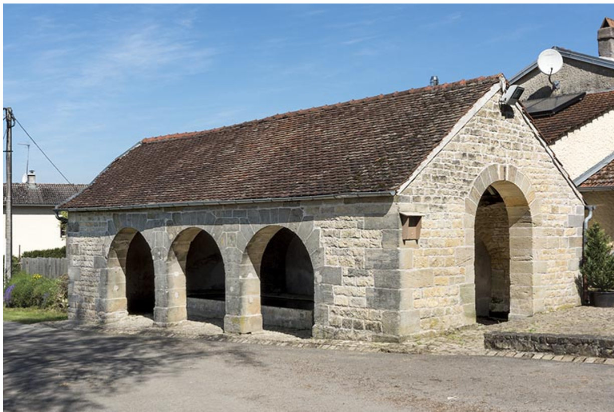
Vue générale du lavoir, rue de la Charlotte. 70, Aisey-et-Richecourt
