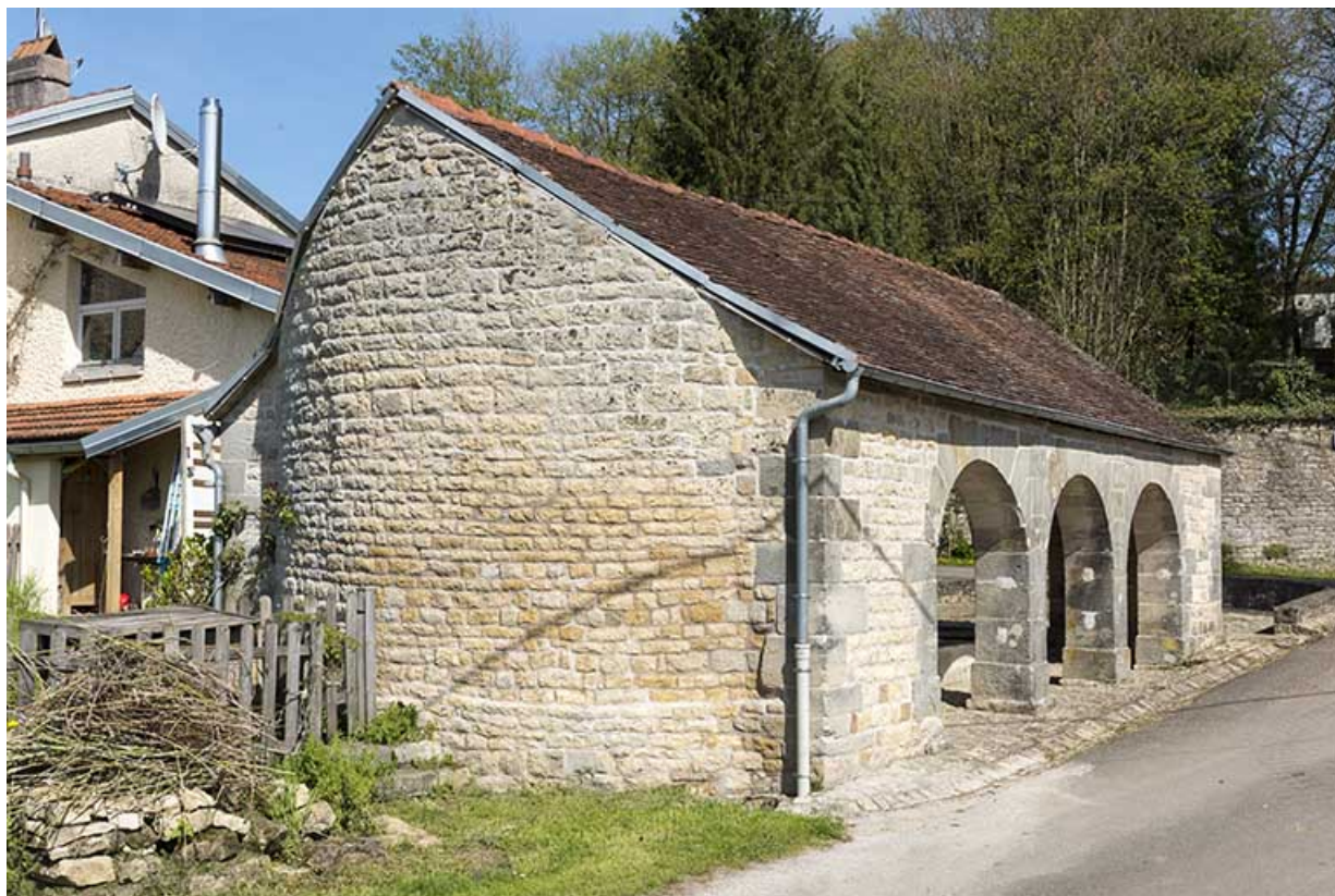
Mur pignon du lavoir. 70, Aisey-et-Richecourt
