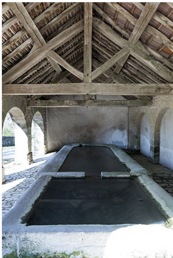
Bassins du lavoir.
