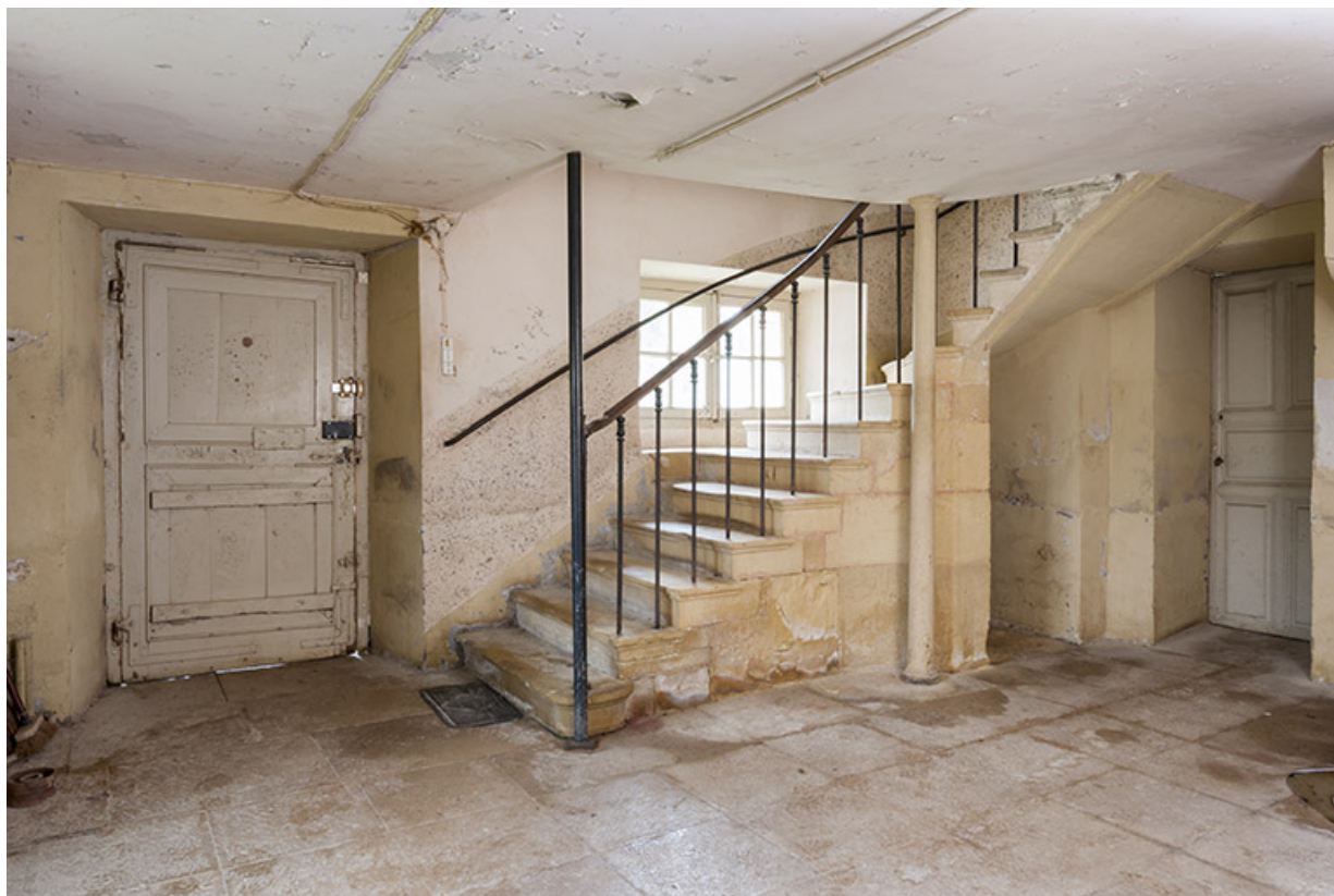
Escalier d'accès au rez-de-chaussée depuis le sous-sol.
