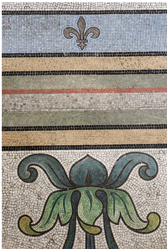
Motifs de la mosaïque recouvrant le sol du hall : deux fleurs dont une de lys. 70, Montureux-lès-Baulay, 2, 4 rue de l' Église
