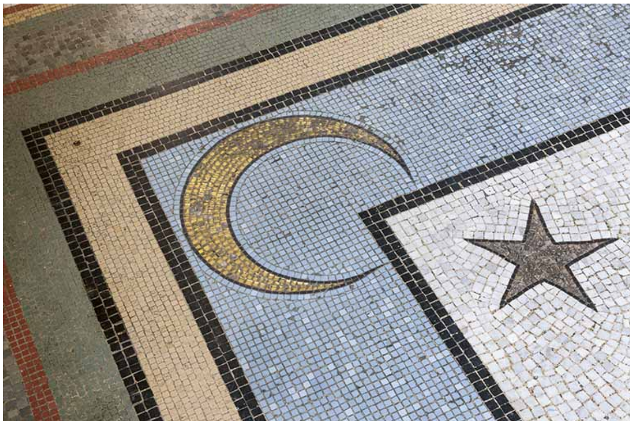
Motifs de la mosaïque recouvrant le sol du hall.
