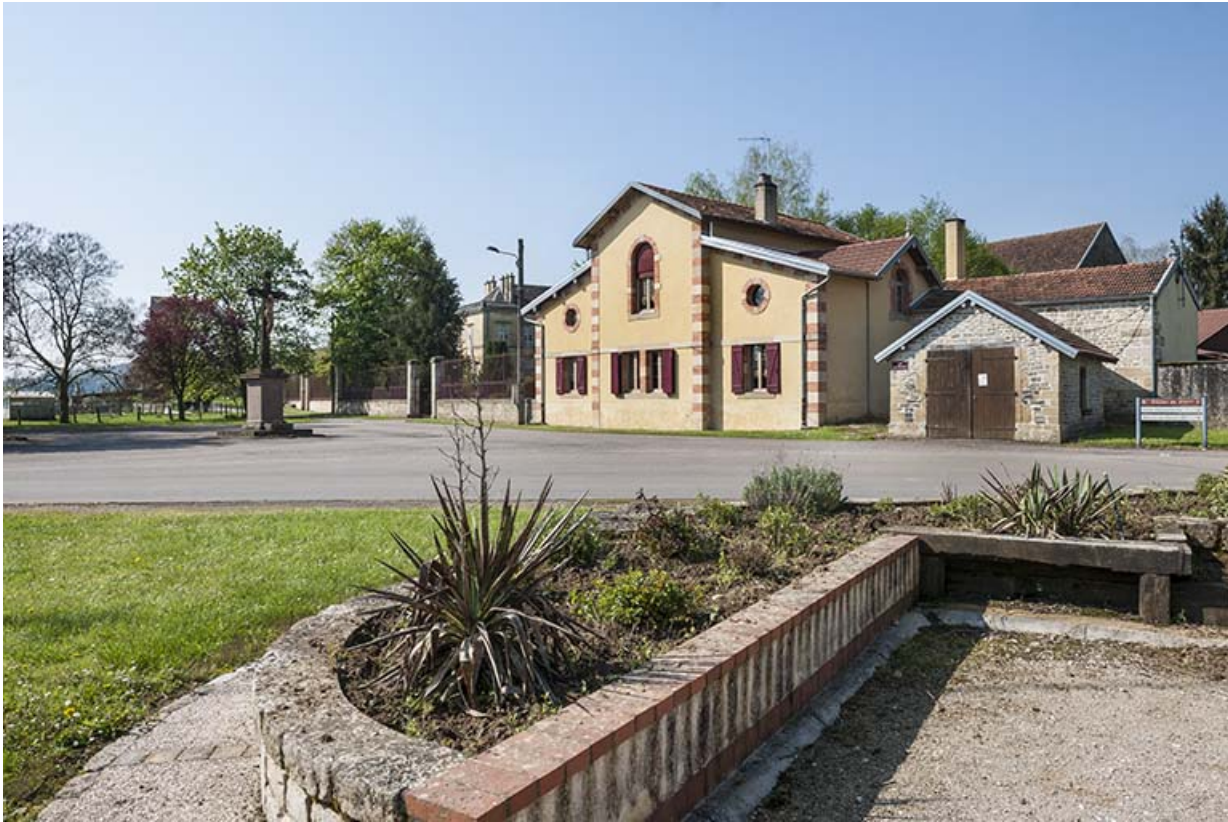
La maison du gardien depuis l'ancien lavoir. 70, Montureux-lès-Baulay, 2, 4 rue de l' Église
