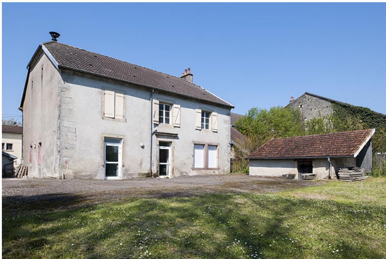
Vue d'ensemble de la façade postérieure avec les anciens cabinets d'aisance. 70, Montureux-lès-Baulay, 10 Grande Rue
