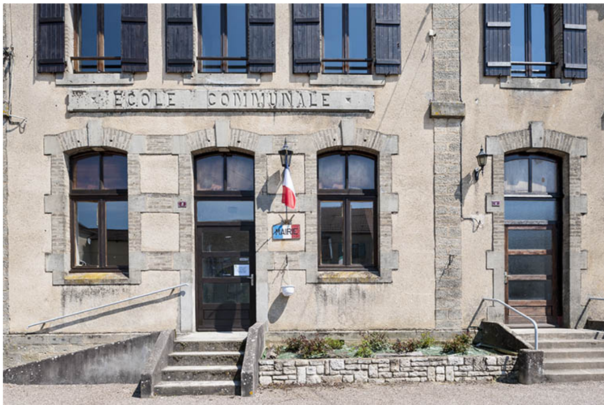
Vue de détail, rez-de-chaussée de la façade principale.
