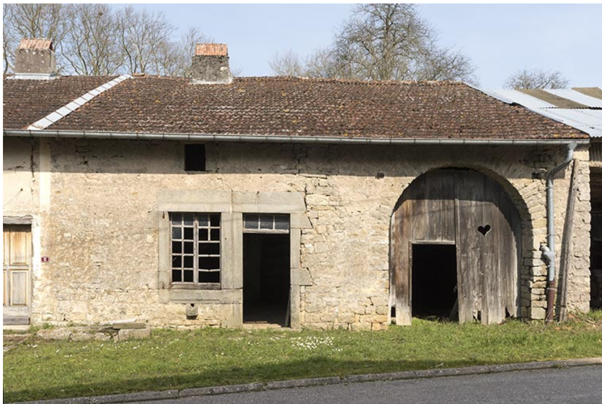
ferme à deux travées. 70, Aisey-et-Richecourt
