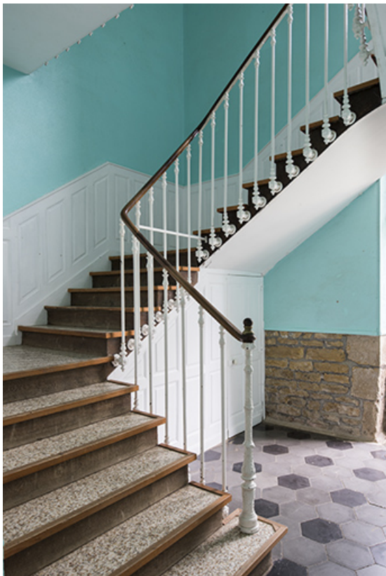
Escalier intérieur, côté nord.
