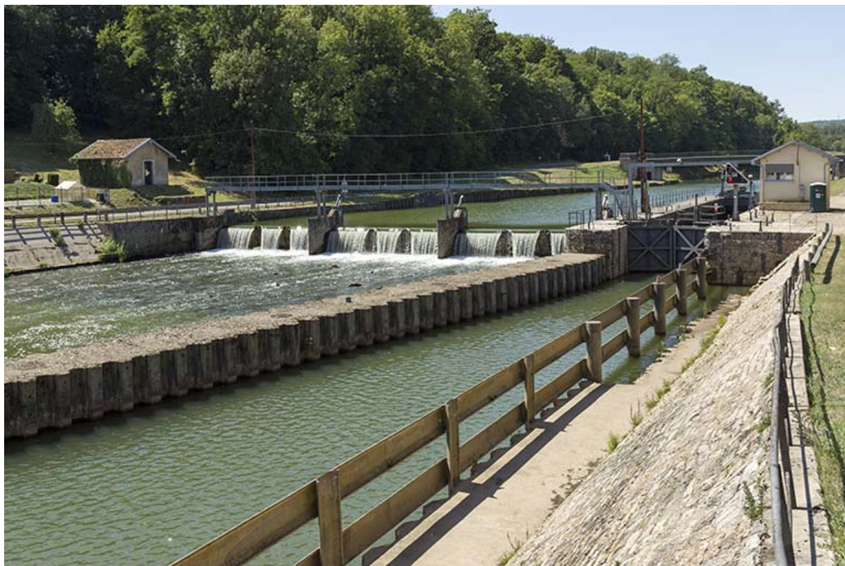
Depuis la rive gauche, en aval, vue sur le barrage, le site d'écluse, le poste de commande. 70, Conflandey
