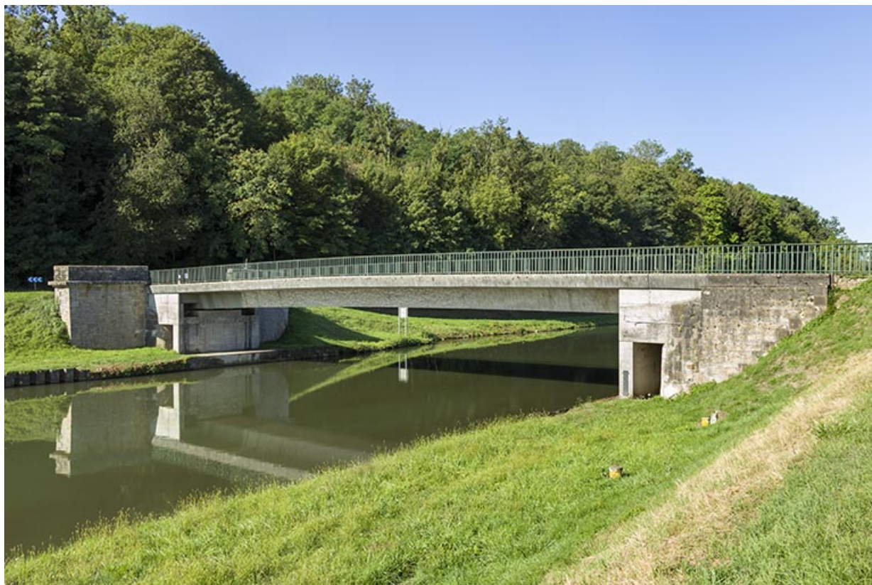
Pont de la D152 enjambant le canal. 70, Conflandey
