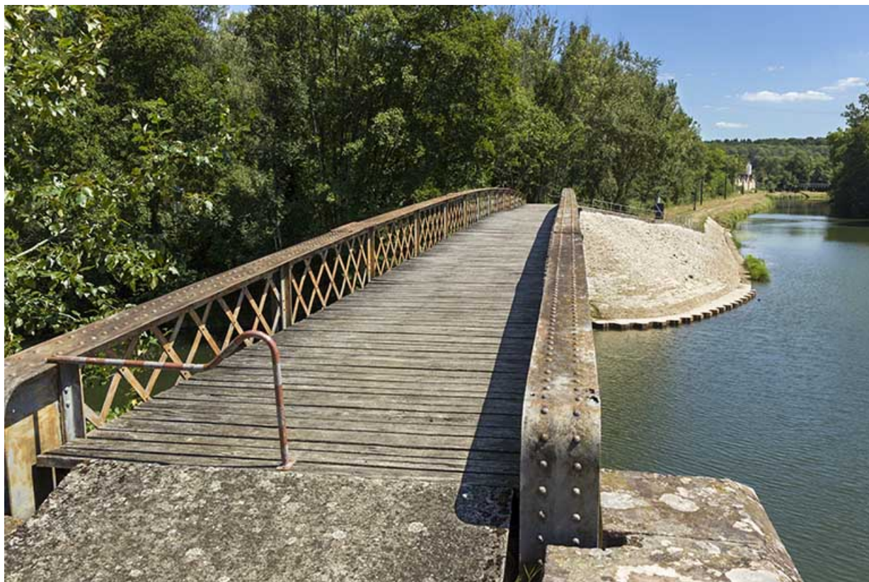
Jouxtant l'écluse en aval, passerelle enjambant La Lanterne. 70, Conflandey
