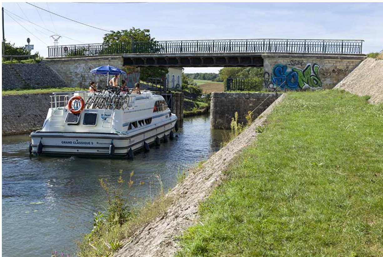
Bateau montant dans la porte de garde.
