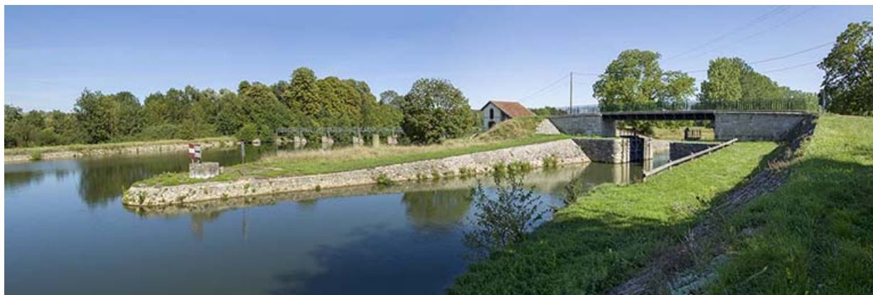
Vue sur la porte de garde et le barrage depuis l'amont au nord.
