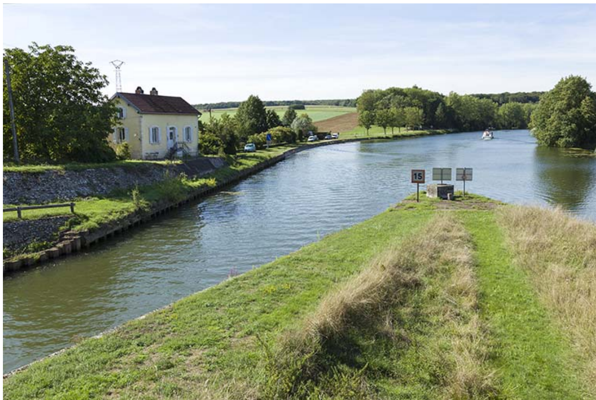
Vue de la maison de garde et de la dérivation depuis l'aval.
