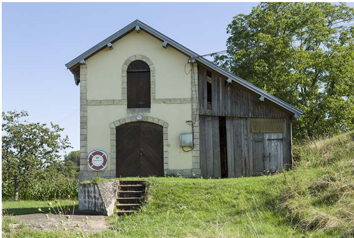
Vue du pignon nord de la maison de garde avec date portée sur l'arc de la baie de l'étage. 70, Ferrières-lès-Scey
