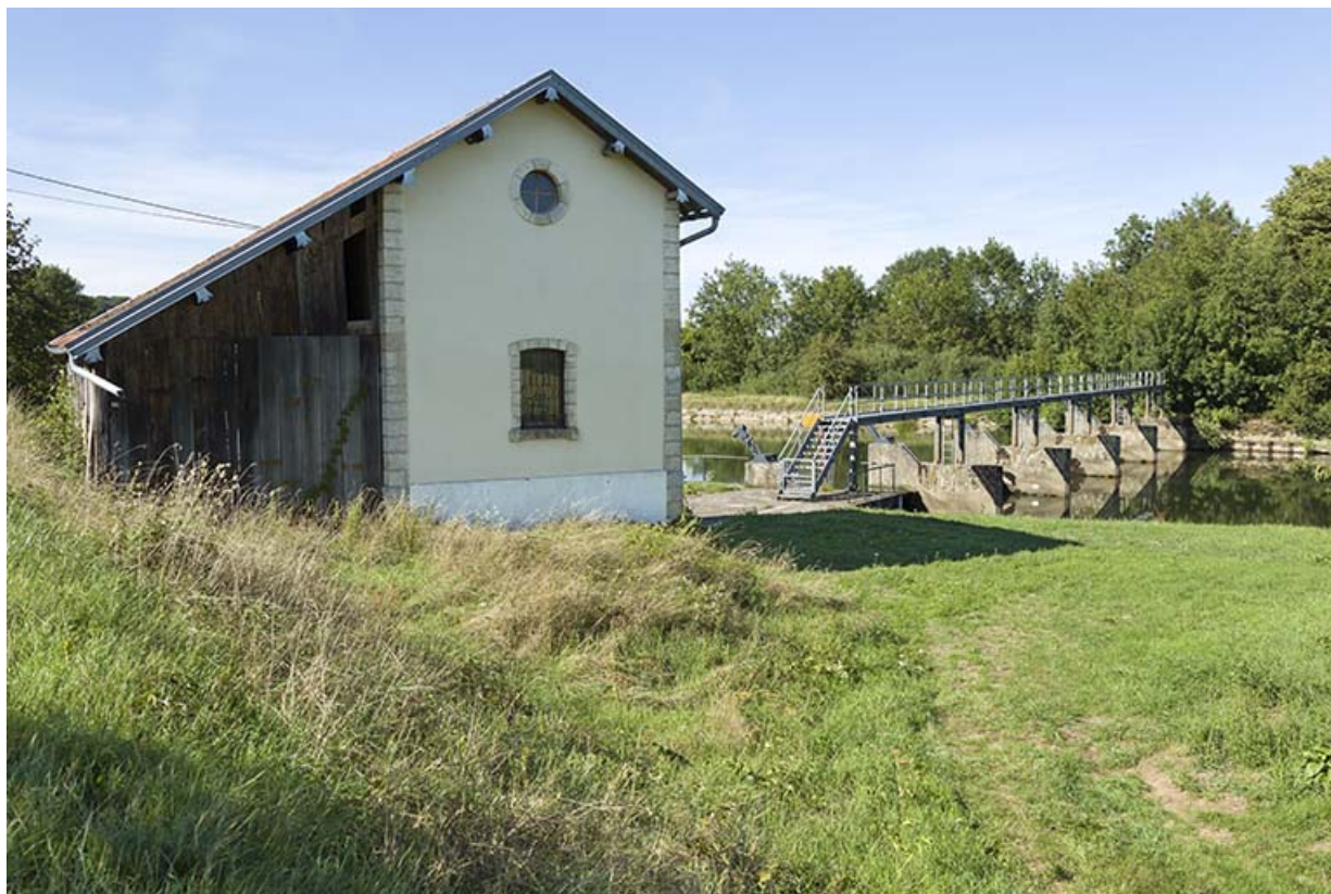
Depuis le sud, vue du barrage et du pignon de la maison de garde. 70, Ferrières-lès-Scey
