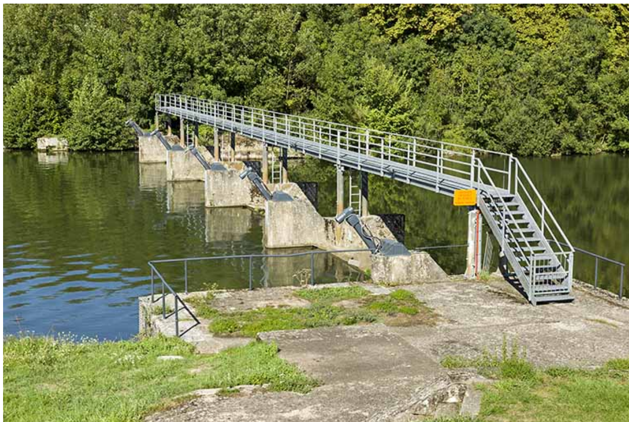
Vue de trois-quart du barrage depuis la rive droite en amont. (nord-ouest) 70, Ferrières-lès-Scey
