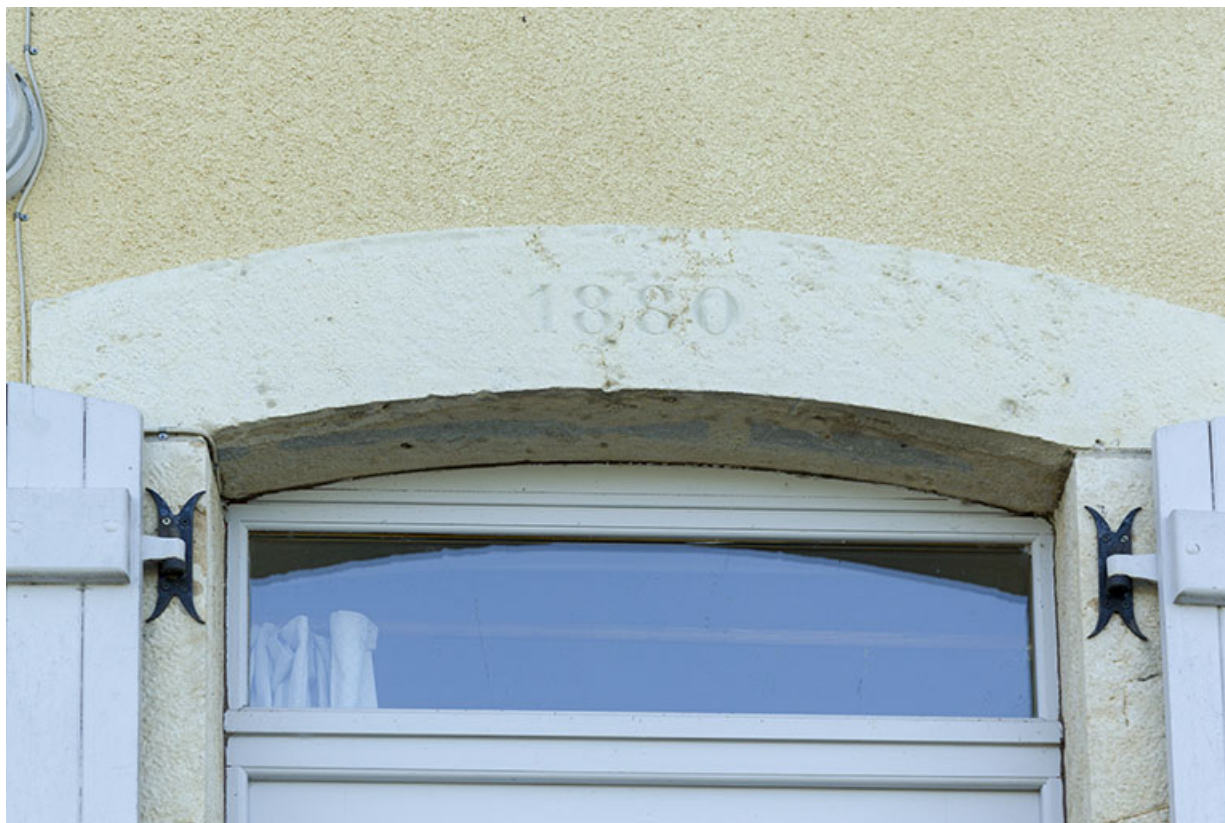
Détail de date portée (1880) sur le linteau de la porte de la maison de garde. 70, Ferrières-lès-Scey
