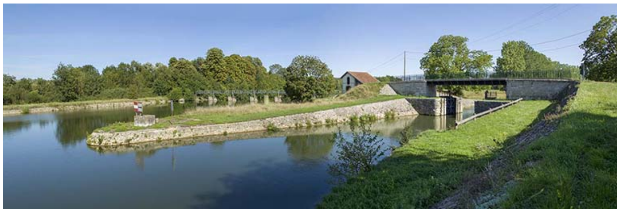
Vue sur la porte de garde et le barrage depuis l'amont au nord.
