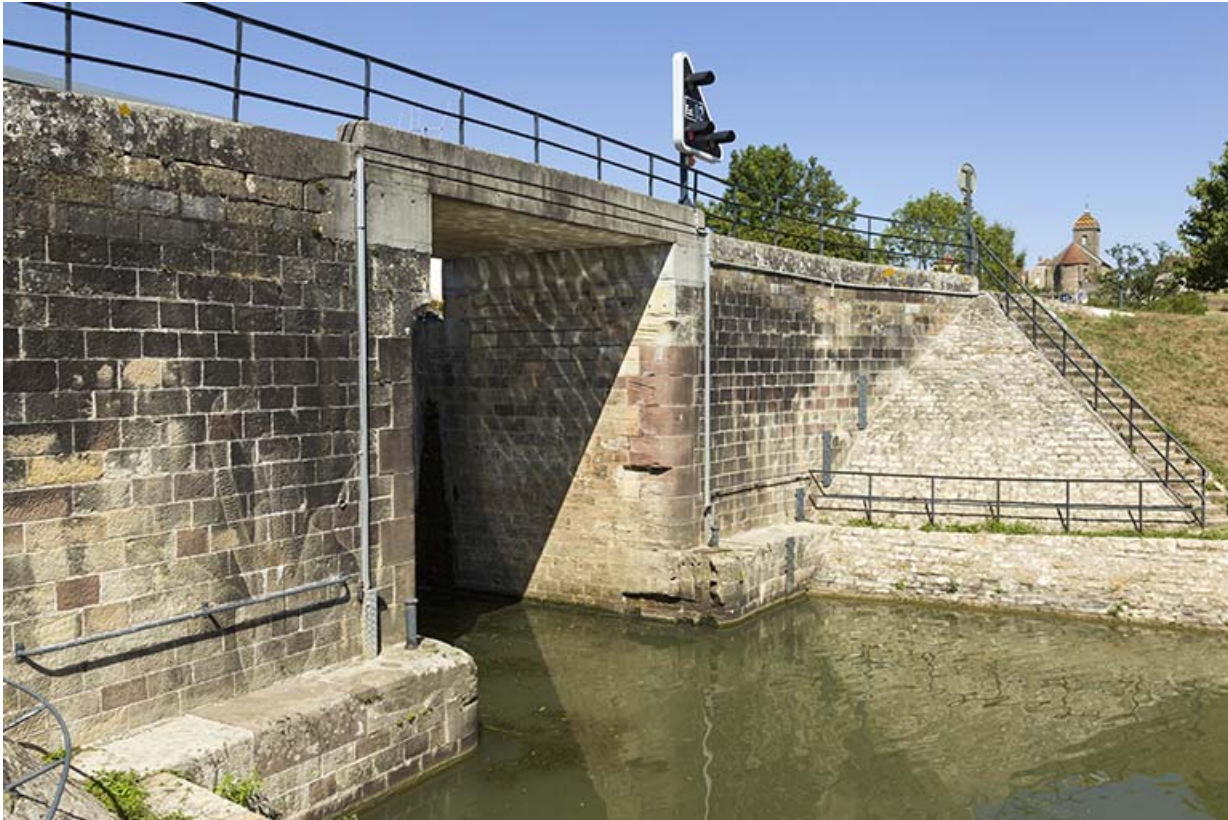
Détail des maçonneries de l'écluse (aval) et vue sur l'église.
