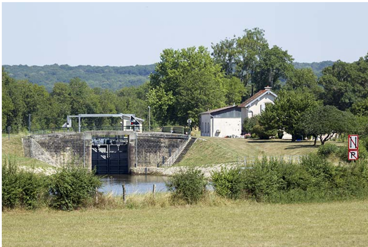
Vue d'ensemble du site depuis la rive droite en aval.
