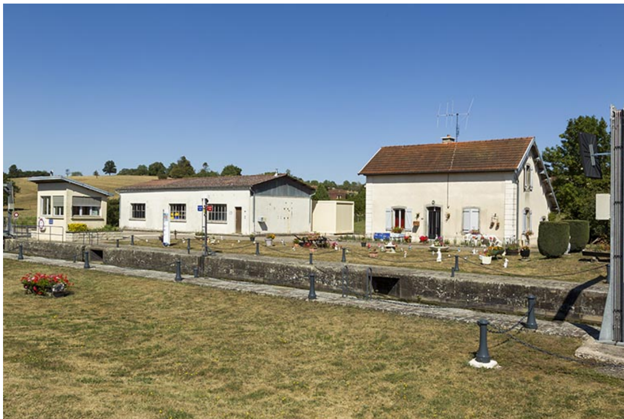
Depuis la rive droite, vue sur la maison d'éclusier et le hangar de Voies navigables de France (centre d'exploitation). 70, Cendrecourt, lieudit : le Closey
