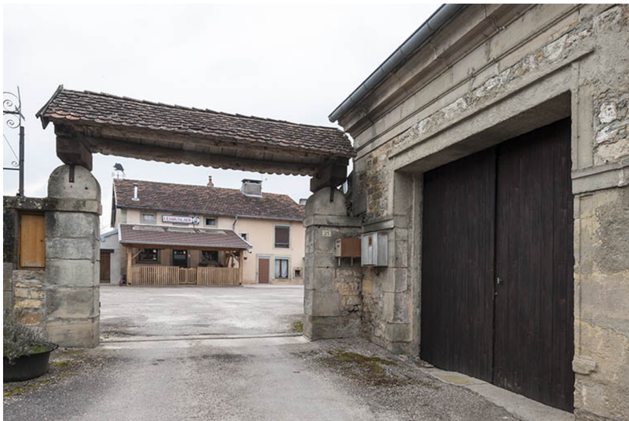
Ancienne maison des soeur. 70, Ormoy
