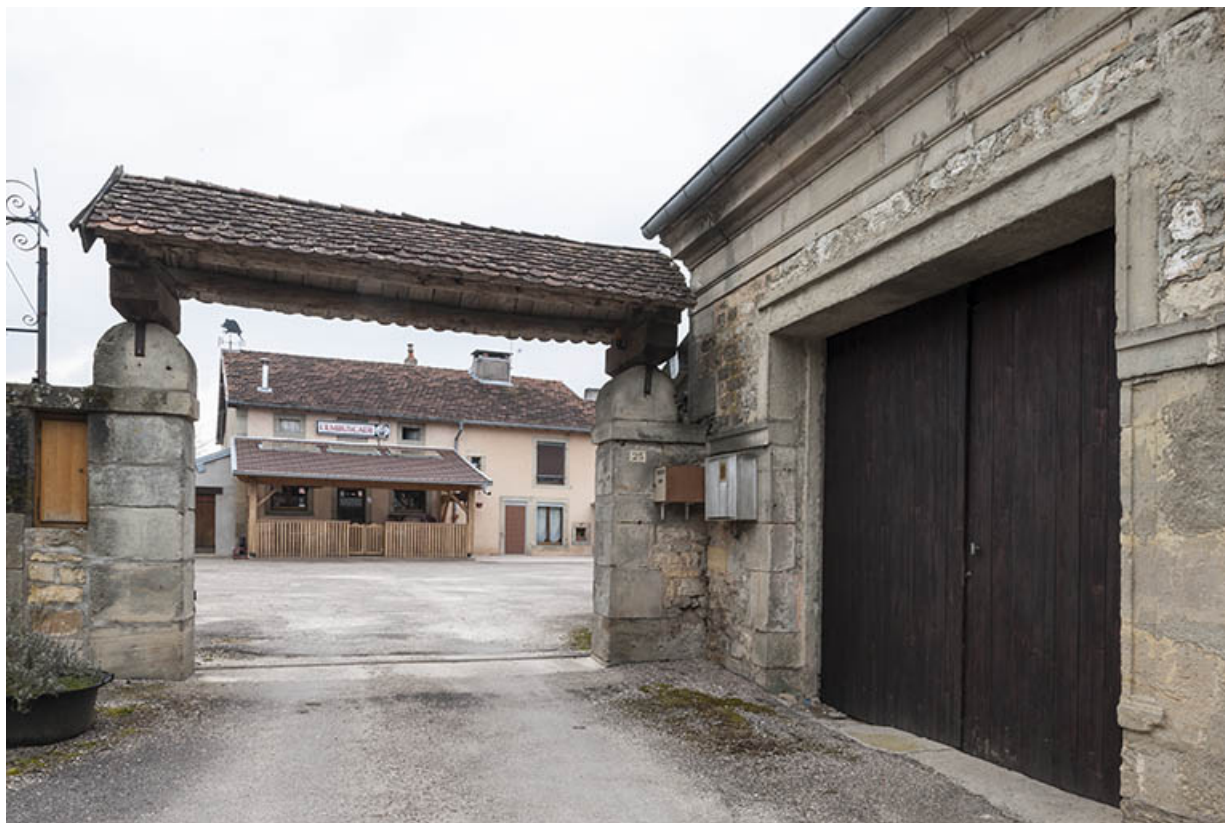
Ancienne maison des soeur. 70, Ormoy
